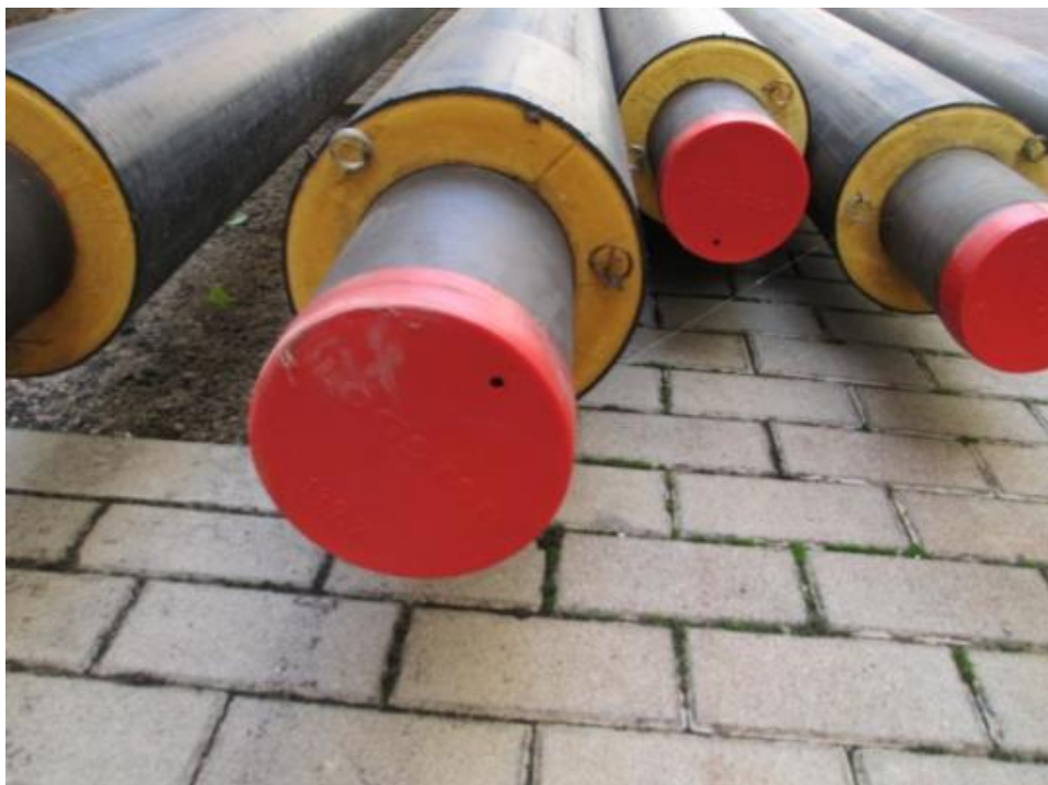
Figura 34. Tuberías pead preaisladas en obra. Fuente: [34]
