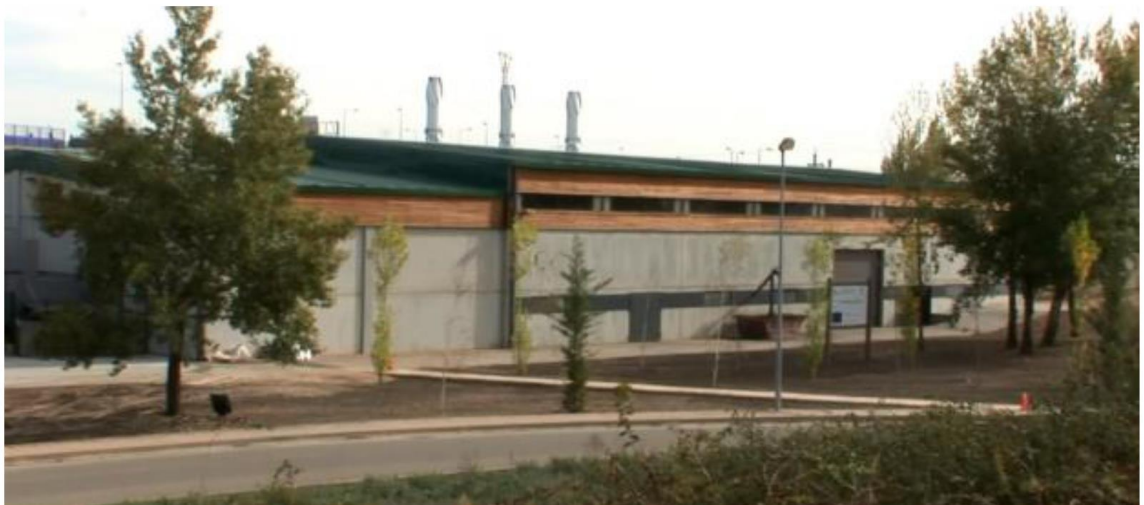
Figura 30. Central Térmica. Fuente [34]
