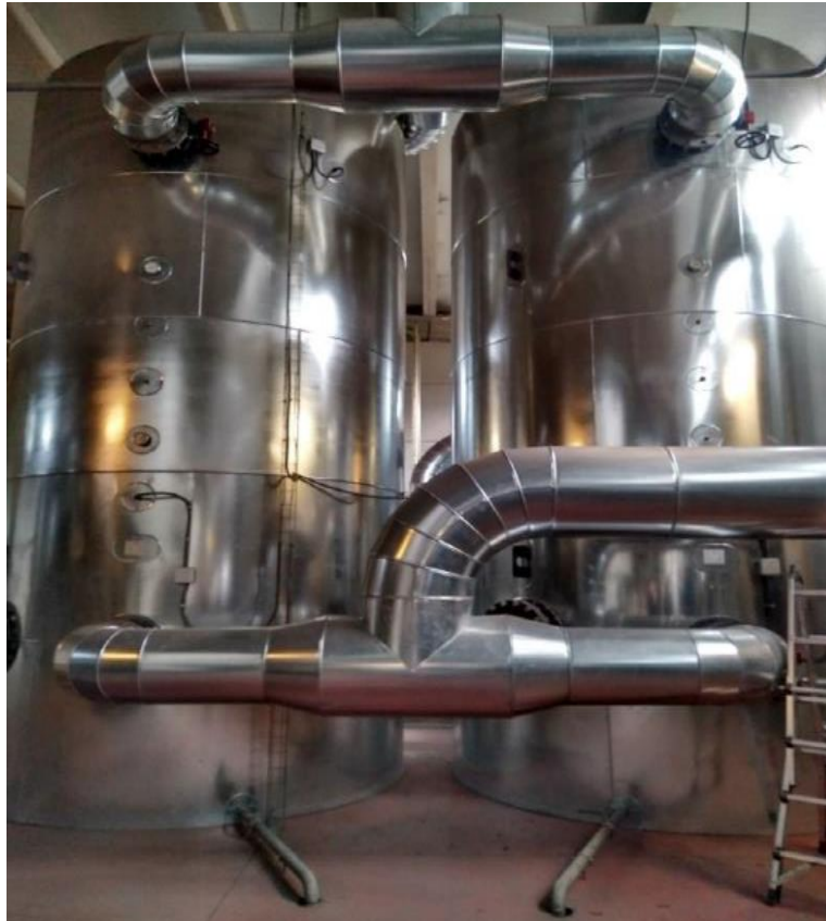
Figura 33. Depósitos de inercia. Fuente: [34]
