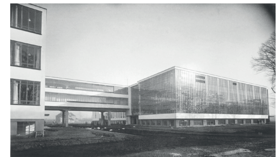
119: Vista de la fachada norte de la Bauhaus en Dessau
