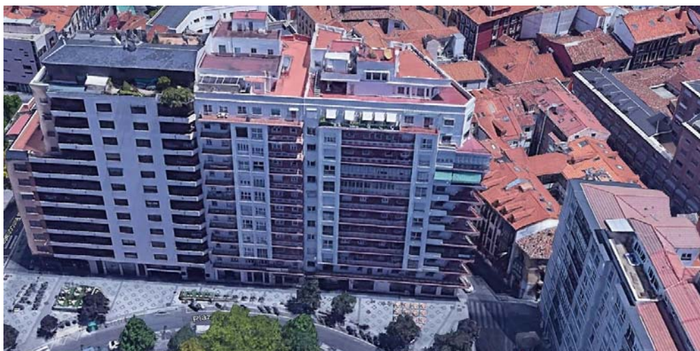
Figura 9: Bloques en altura mayor de B+10 entre medianera en la plaza poniente. Fotografía Google Earth (junio 2019)
