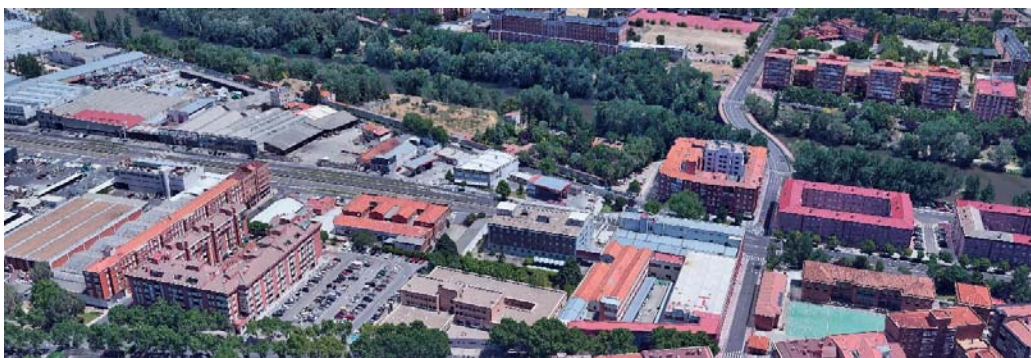
Figura 15: Bloques menor de B+4 en forma lineal y perimetral. Avenida de Burgos Fotografía Google Earth. (junio 2019)
