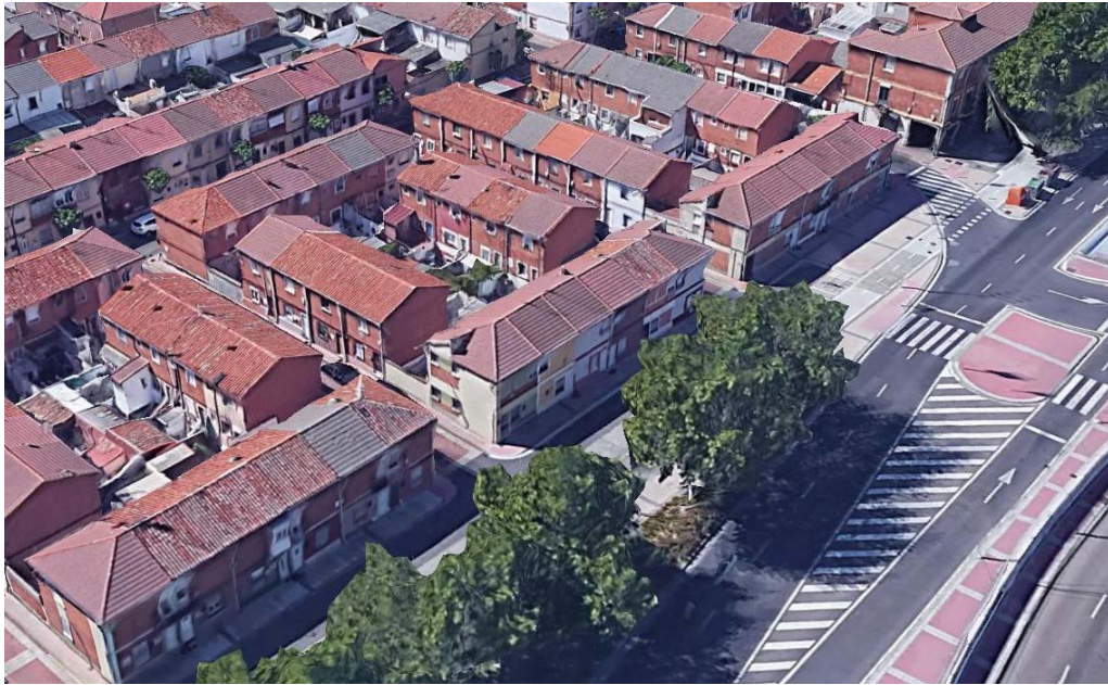
Figura 5: Viviendas unifamiliar adosadas de tipo social. Barrio San Pedro Regalado. Fotografía Google Earth. (junio 2019)
