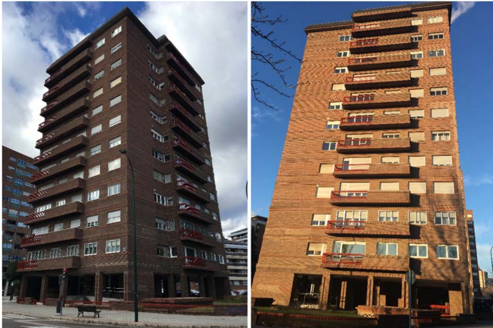
Figura 78: Bloque en altura de B+11 aislado. Avenida Gloria Fuertes 2. Barrio Huerta del Rey Fotografía Jessica Merys. (enero 2020)
