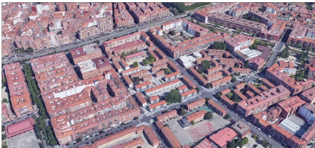
Figura 47: Barrio Pajarillos Bajos. Fotografía Google Earth (junio 2019)
