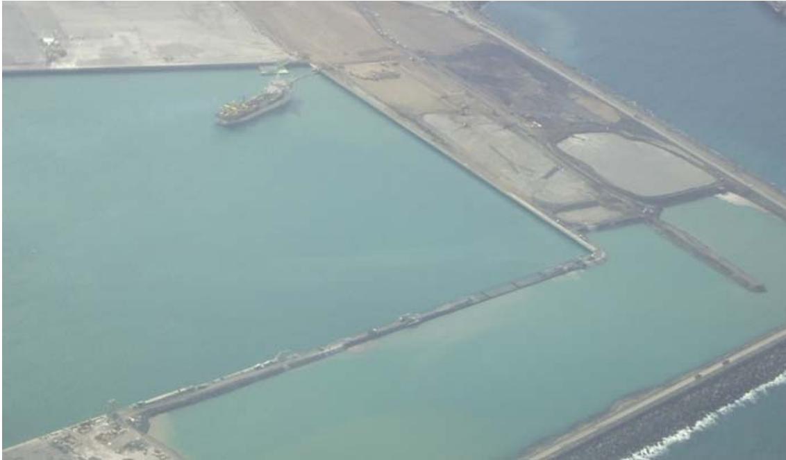
Figura V-52. Vista de cajones fondeados del muelle AZ2
