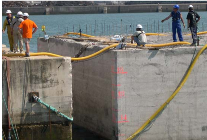
Figura III-20. Superestructura en línea de cajones ya fondeada (izquierda) junto a nuevo cajón a fondear (derecha)
