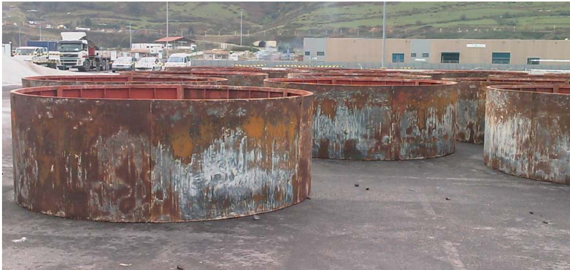
Figura III-17. Acopio de encofrados usados previos a colocación en pontona
