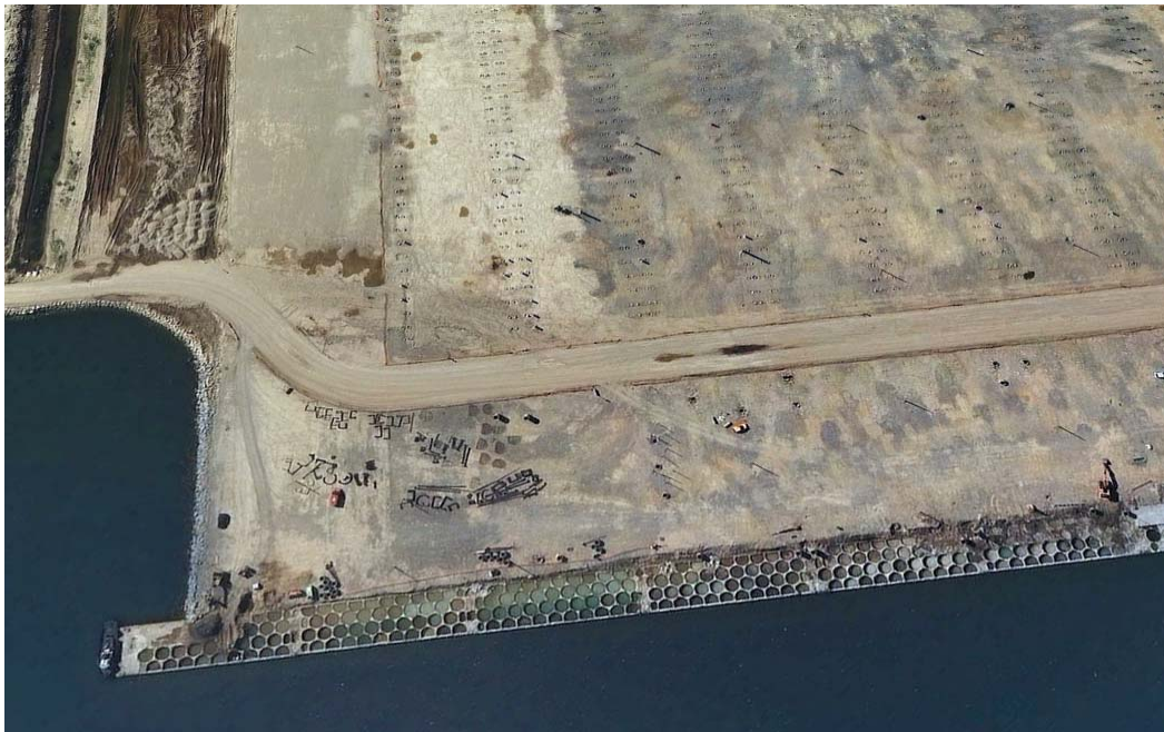
Figura V-44. Vista del muelle de cajones fondeados
