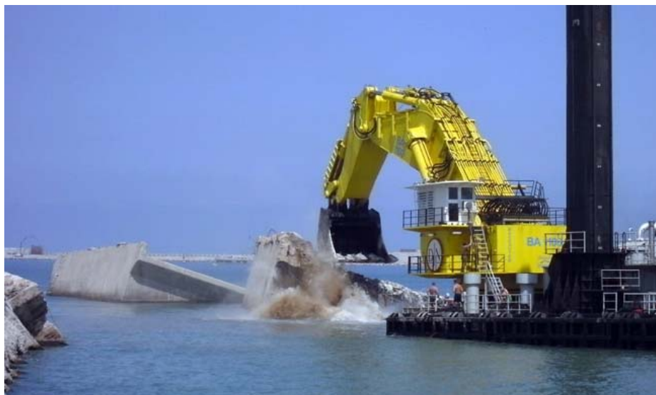
Figura II-11. Operaciones de demolición de cajones dañados [23]
