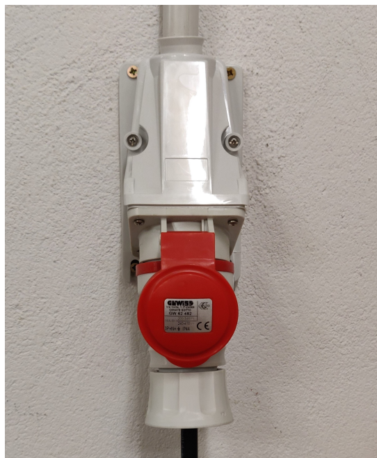
Figura 2.59: Conexión a la red trifásica de 400V.
