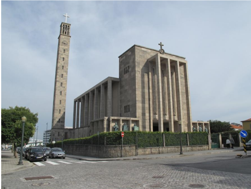
Igreja Paroquial de Santo António das Antas, fachada principal voltada à Avenida dos Combatentes da Grande Guerra.
