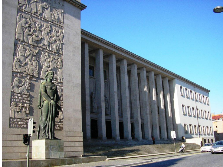
Palácio da Justiça do Porto, 1950-1961. Fachada do Jardim da Cordoaria. Arquitecto Raul Rodrigues Lima
