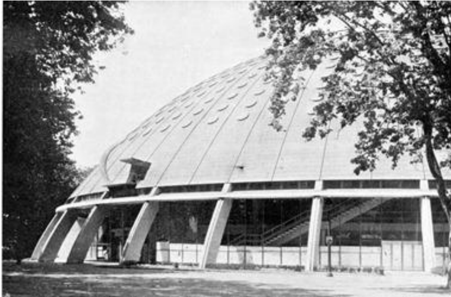
Pavilhão dos Desportos, 1954. Arquitecto José Carlos Loureiro [ http://doportoenaoso.blogspot.pt/2011/04/os-planos-para-o-portodos-almadas-aos_8317.htm ]
