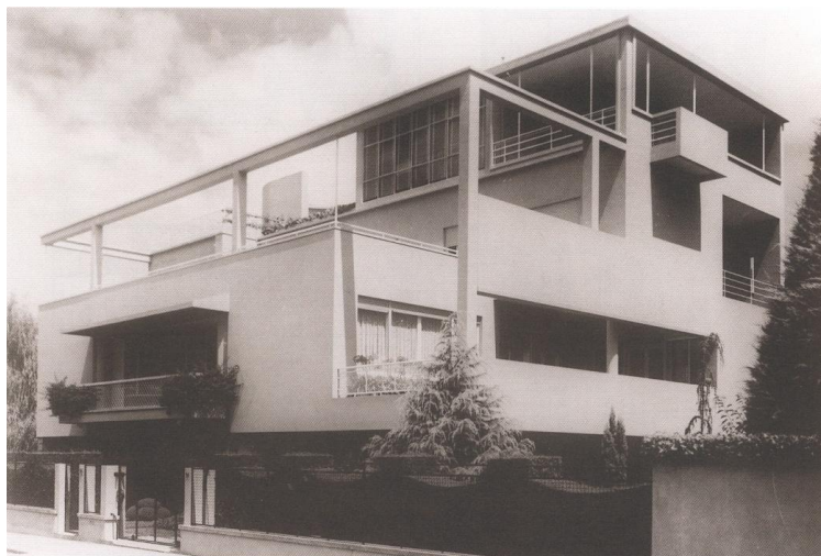
Casa Honório de Lima, Porto, 1939-1943. Arquitecto Alfredo Viana de Lima
