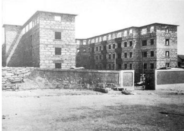
Construção do Bloco Habitacional de Duque de Saldanha, 1937. [AHMP]
