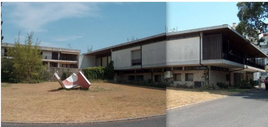
ICG, Centro Social, fotografias de arquivo//biblioteca ICG, Centro Social, fotografias de arquivo//sala de convívio ICG, Centro Social, estado actual, escada de acesso//pátio central ICG, Centro Social, estado actual
