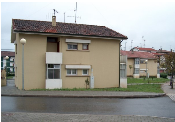
BB, estado actual BB, estado actual BB, estado actual
