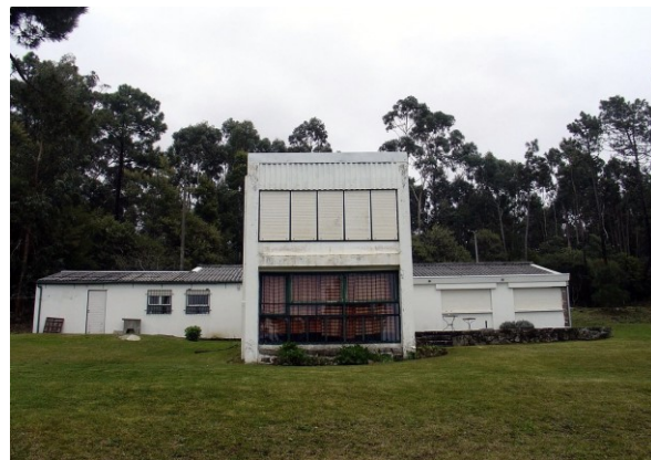
CRA, 1ª ampliação da casa, versão inicial, alçados//plantas CRA, 1ª ampliação da casa, versão final, alçados//planta CRA, 2ª ampliação da casa, planta CRA, estado actual
