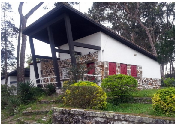
CFO, planta//fachada nascente CFO, corte longitudinal//fachada sul-nascente CFO, fachada norte-nascente//alpendre CFO, estado actual
