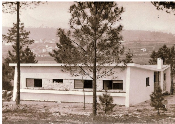
CRF, fachada sul//norte-nascente CRF, fachada sul, pátio da entrada CRF, fachada sul//poente CRF, fachada nascente
