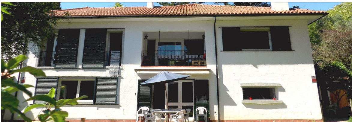
CCR, planta do andar//alçados noroeste e sudeste CCR, planta do r/chão//alçado norte CCR, implantação CCR, estado actual
