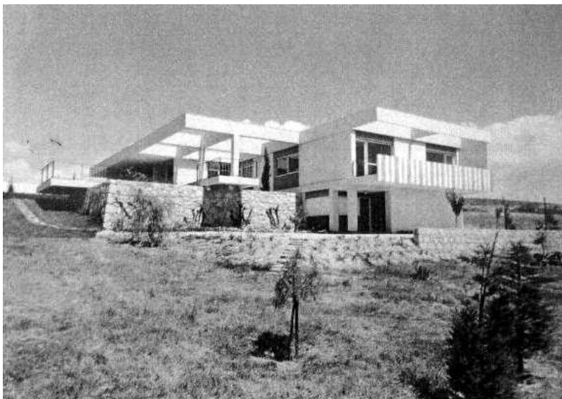
CLG/C, solução final, plantas CLG/C, solução final, alçados CLG/C, fotografia de arquivo, perspectiva das fachadas sul-nascente
