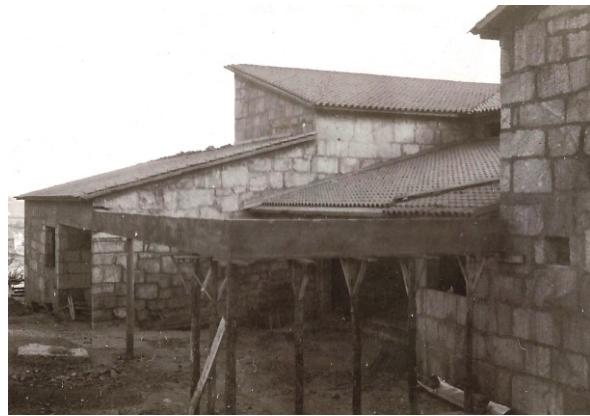
CVT, fase de construção//fase de acabamento CVT, fase de construção//fase de acabamento CVT, fase de construção//fase de acabamento CVT, fase de construção
