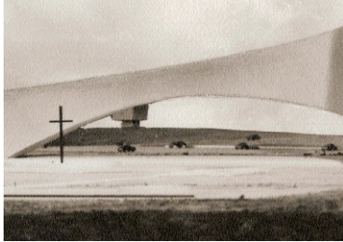
429. Mar Novo, estacionamento 430. Mar Novo, estacionamento
