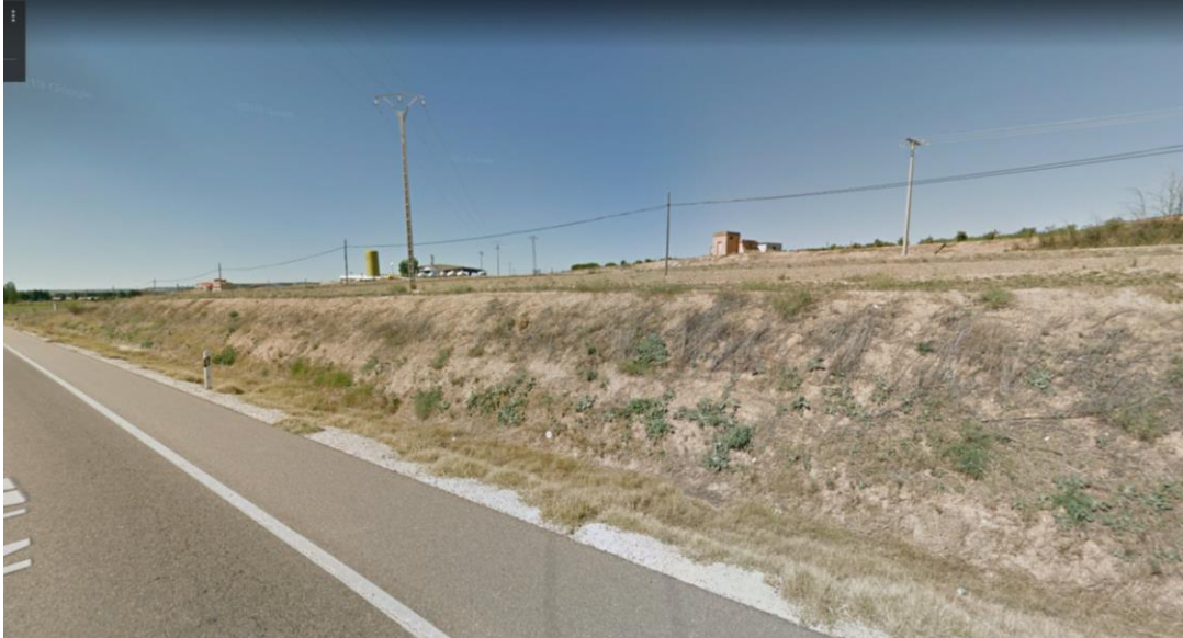
Figura 18: Imagen de Google Street view del desnivel de 3 metros desde la linde sur, en la carretera N-122. imagen de 2017
