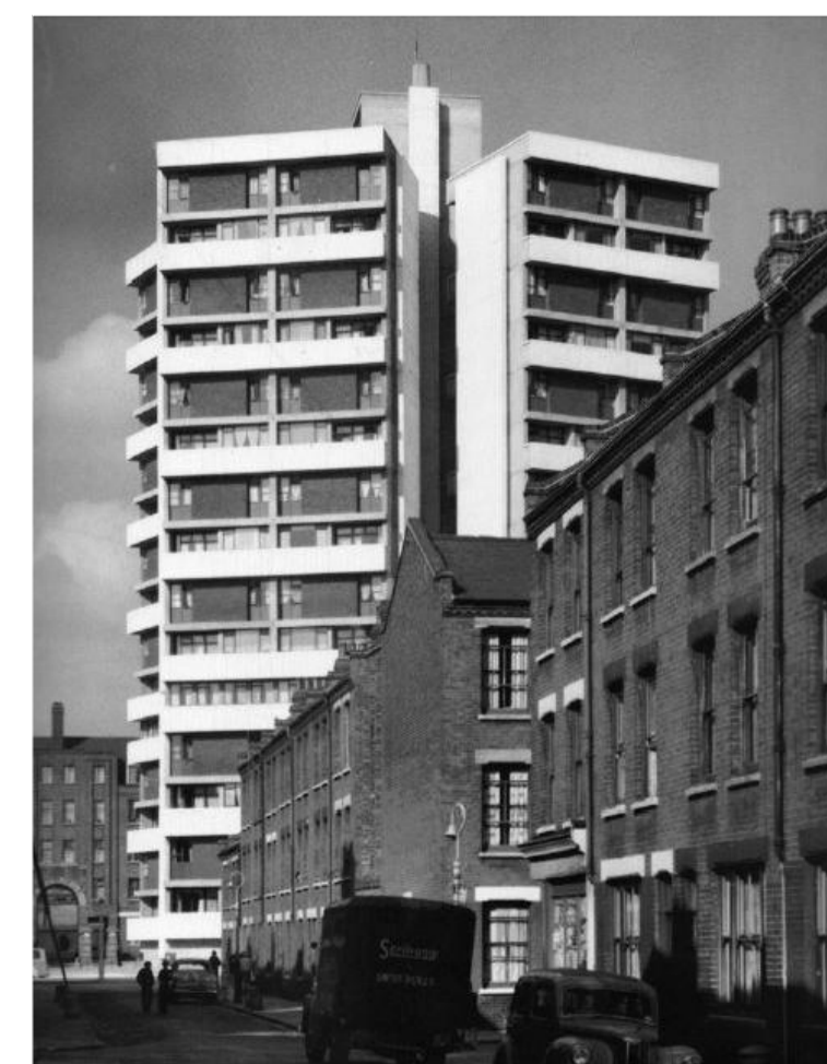
Figura 3.3: Vista desde la calle.
