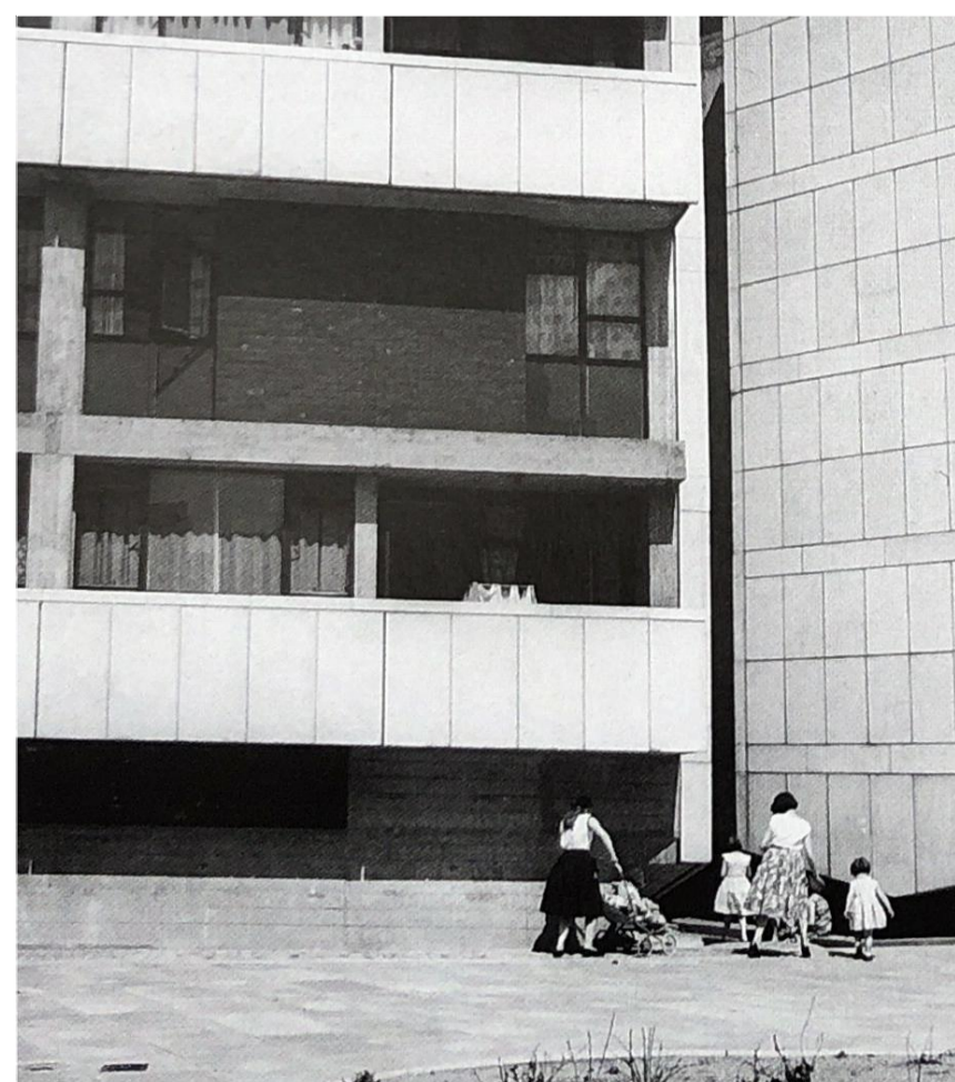
Figura 3.2: Detalle de la fachada.
