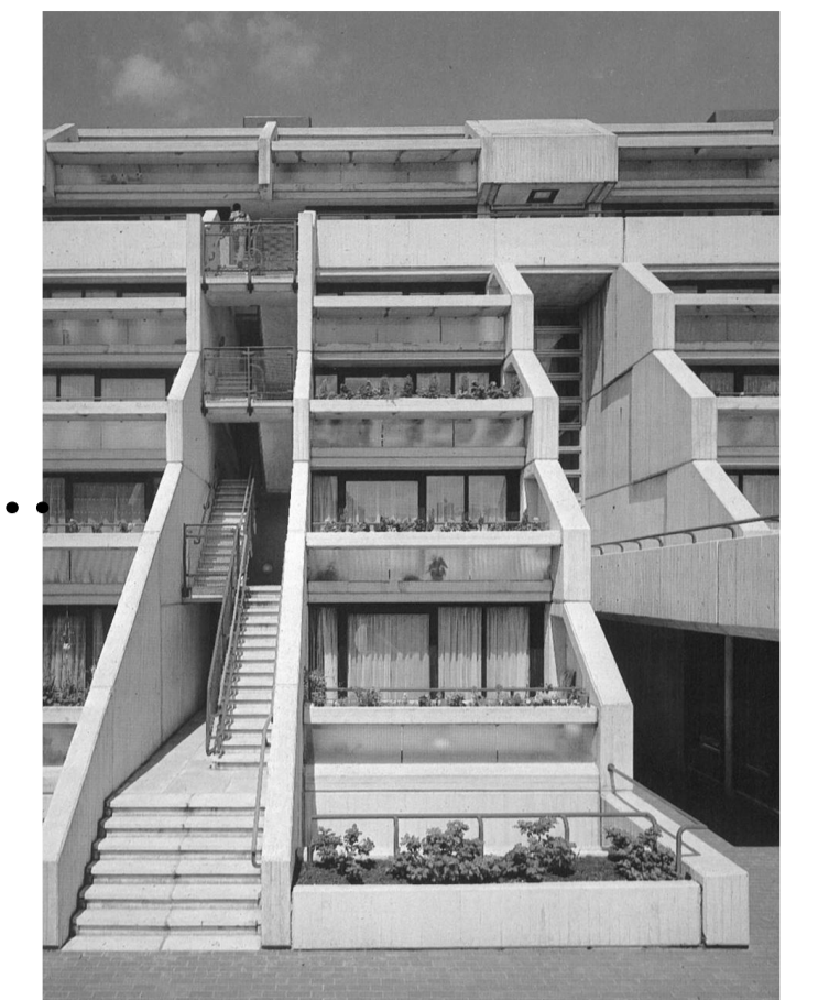
Figura 1.10: Imagen de la fachada sur.
