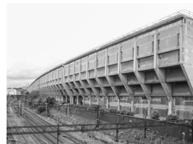
Figura 24: Imagen de la fachada Norte desde el puente del ferrocarril. Fuente: https://es.wikiarquitectura.com/edificio/alexandra-road-estate/#
