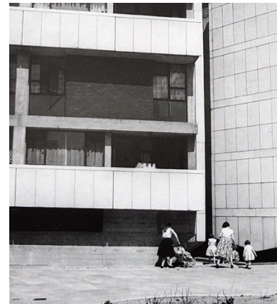
Figura 47: Imagen de la fachada. Fuente: Curtis, William J. R. (1994). Denys Lasdun: architecture, city, landscape .
