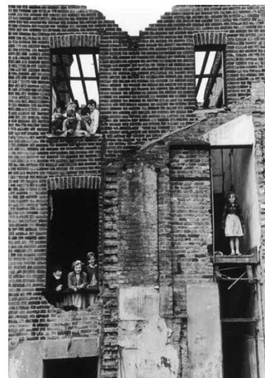
Figura 20: Southam Street durante su demolición. Fuente: Haworth Tompkins Limited. (2015). Cheltenham Estate. Conservation management plan.
