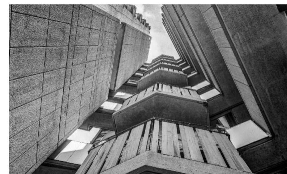
Figura 3.5: Vista desde la planta baja hacia arriba de las plataformas del núcleo.
