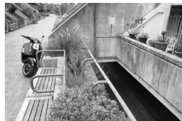
Figura 32: Jardinería de la calle peatonal con banco integrado y patio inglés. Fuente: https://es.wikiarquitectura.com/edificio/alexandra-road-estate/#
