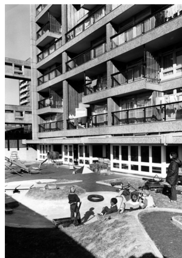
Figura 36: Jardín superior del púlpito. Guardería. Fuente: Haworth Tompkins Limited. (2015). Cheltenham Estate. Conservation management plan.
