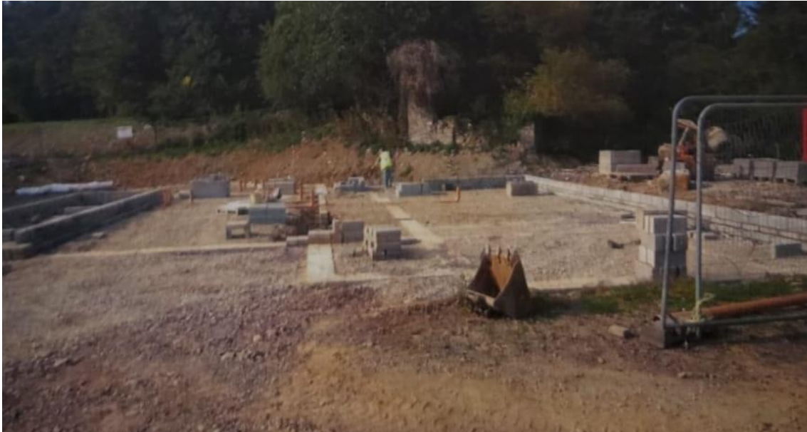
Fig 27. Levantamiento del muro con bloques macizos de hormigón.
