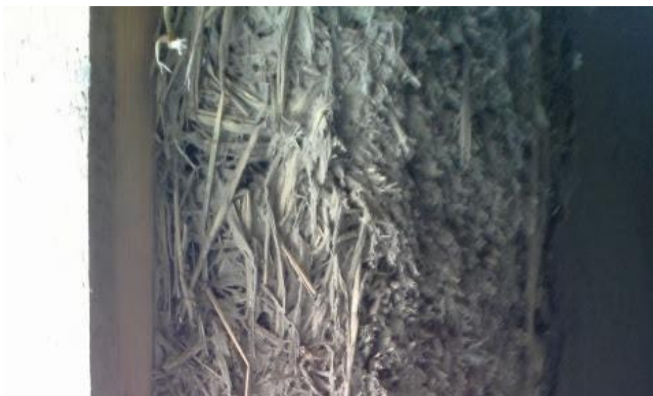
Fig 38. Revoco interior. Dos primeras capas.
