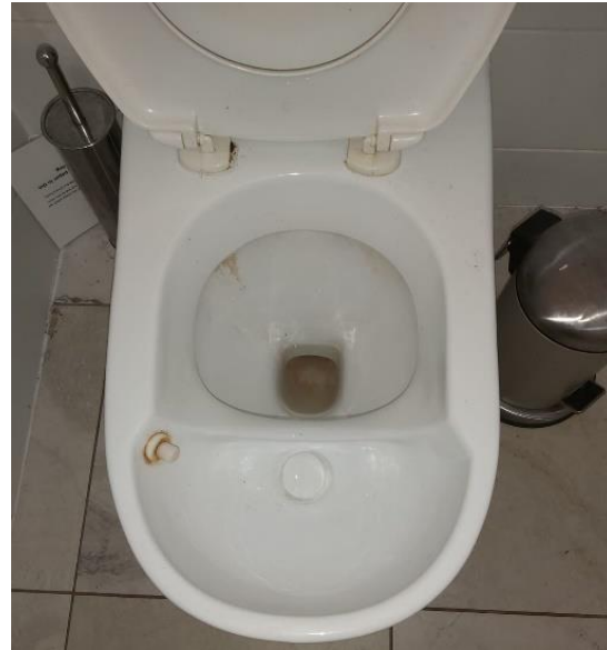
Fig 39. Aquatron. Separación de líquidos y sólidos.
