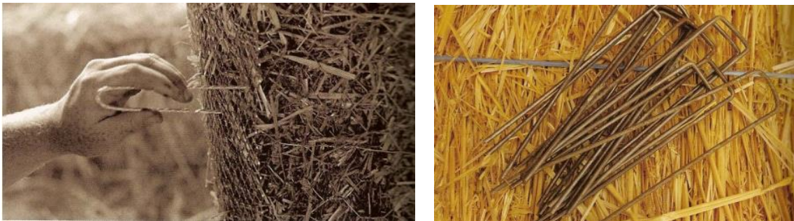
Fig 17. Grapas empleadas para unir la malla al muro.
