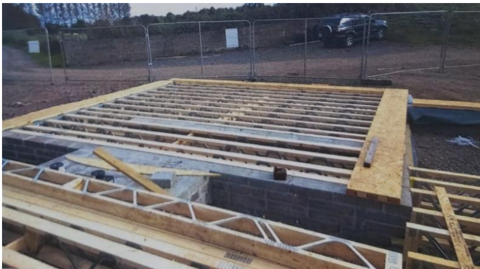
Fig 28. Colocación de viguetas y zuncho perimetral.
