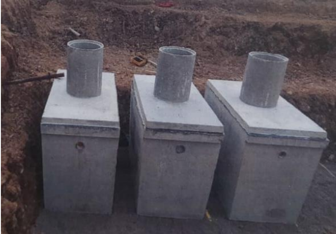
Fig 36. Depósitos almacén de orina.
