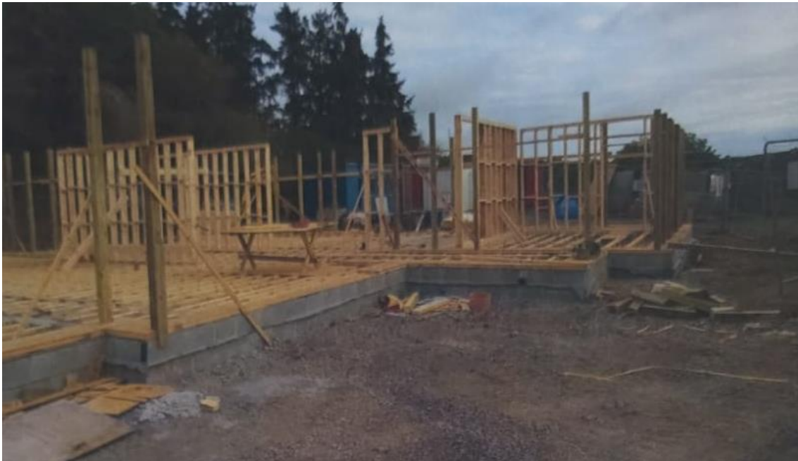
Fig 31. Levantamiento de los muros.
