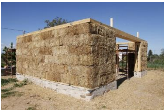
Fig 9. Construcción de muros portantes de balas de paja. Fig 10. Zuncho perimetral de madera.
