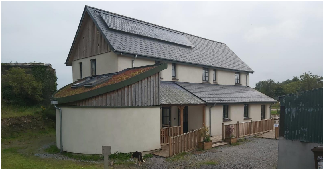
Fig 35. Imagen actual de la construcción. Vista de las placas solares en la cubierta.
