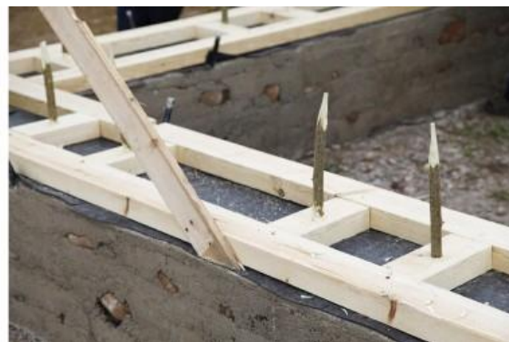
Fig 9. Construcción de muros portantes de balas de paja. Fig 10. Zuncho perimetral de madera.
