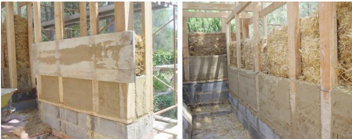
Fig 16. Encofrado realizado en un edificio real.
