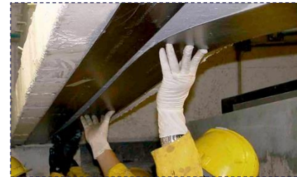
ilustración 2: refuerzo de viga estructural con láminas de fibra de carbono. Fuente: www.topconsult.com (2020-05-21).
