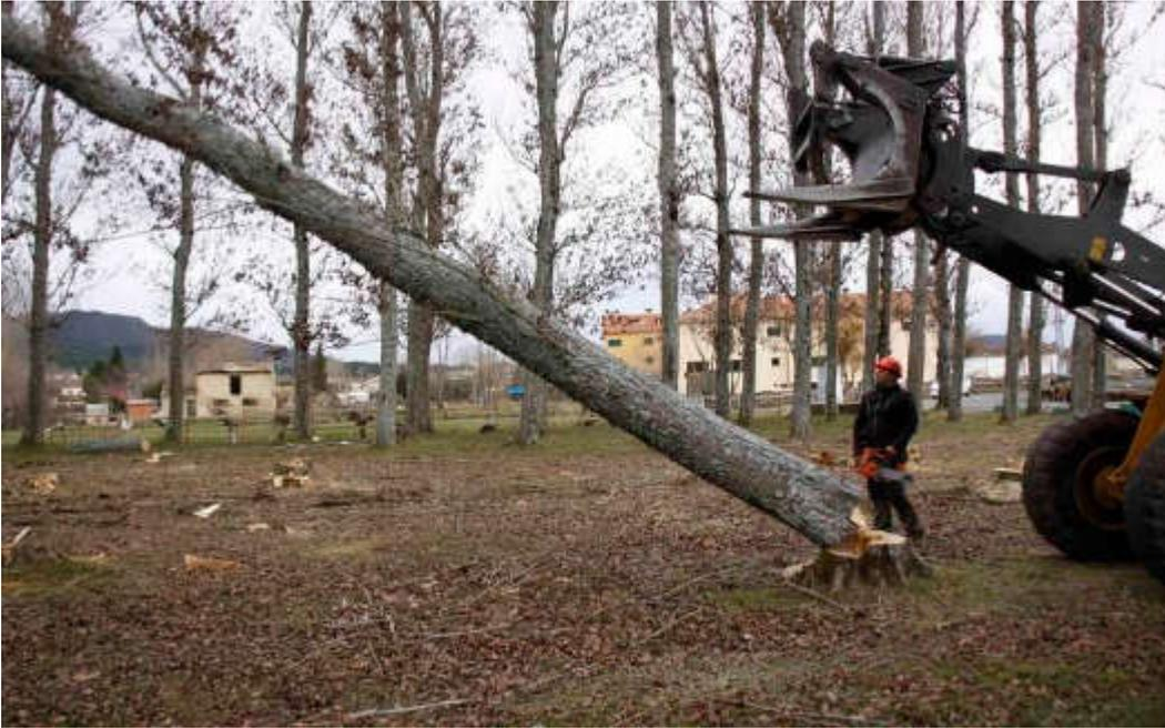
Figura 17. Motoserrista apoyado por retroexcavadora de ruedas con cizalla para realizar el apeo de los chopos del país. Fuente: Diario de León
