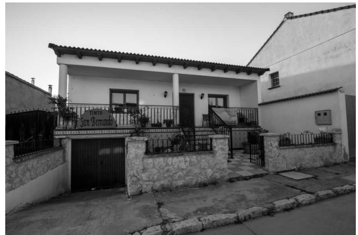
En la figura: Vivienda construida tras el derribo de la original, que se ha construido retranqueada con respecto a la línea de fachada existente.
