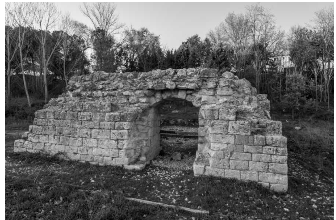
En la figura: Ruinas del molino del monasterio de San Bernardo.
