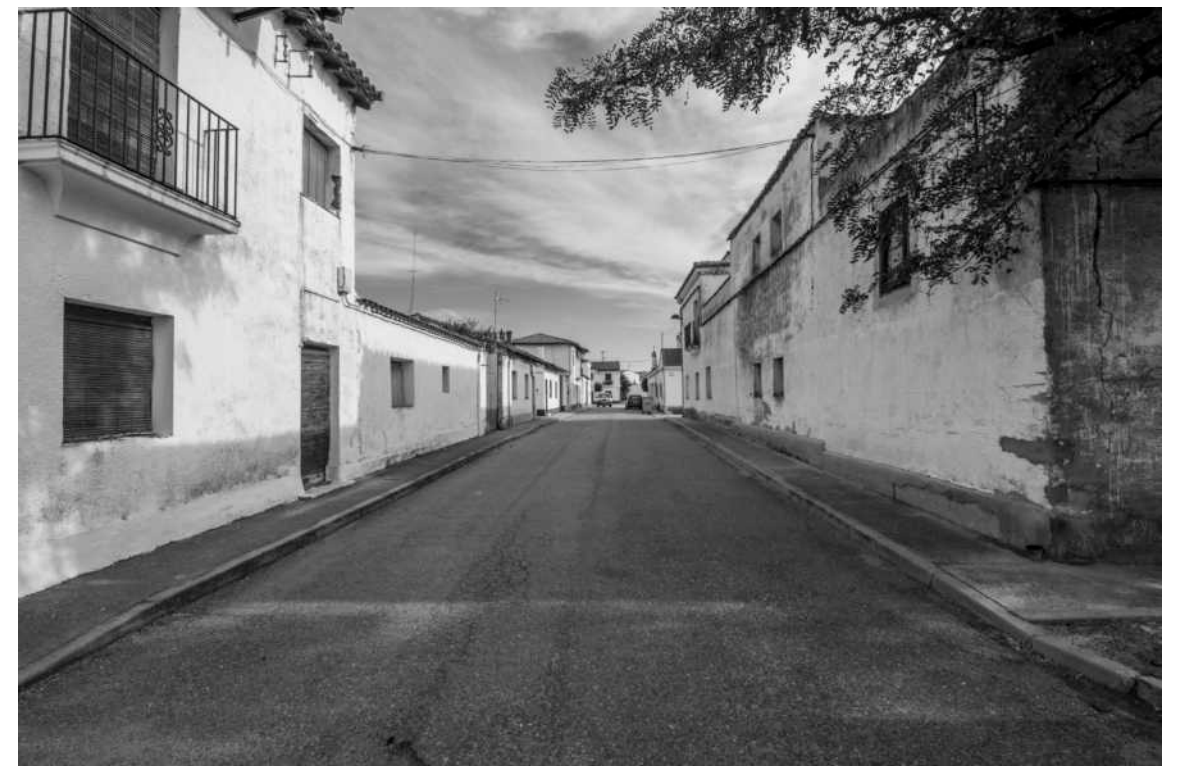
En la figura: Vista de una de las calles de Foncastín, donde se aprecia claramente la diferencia de alturas existente entre las viviendas.
