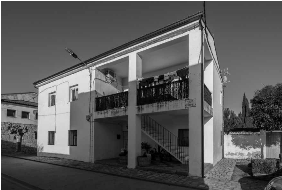
En la figura: Viviendas de los maestros, que se encuentran en el estado original.
