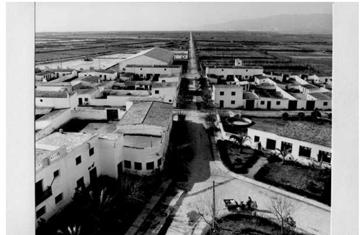
En la figura: Vista aérea de Poblenu del Delta, donde vemos las viviendas con la mencionada cubierta plana.
