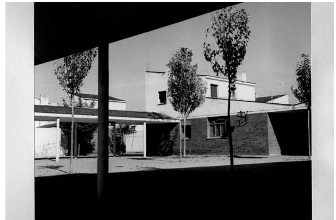
En la figura: Vista de la plaza mayor de Fuentes Nuevas, donde se aprecia el uso de la pizarra, al igual que en la arquitectura vernácula tradicional berciana.
