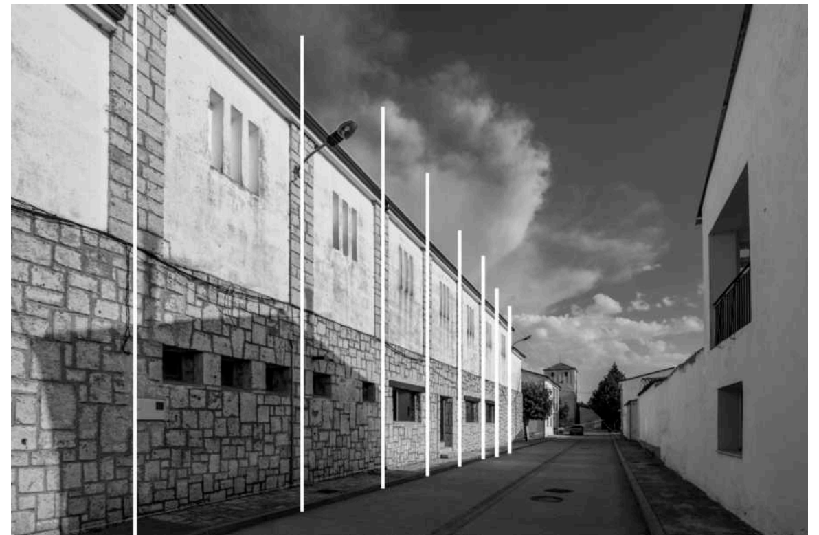
En la Figura: Fachada posterior del centro social, con la modulación indicada.
