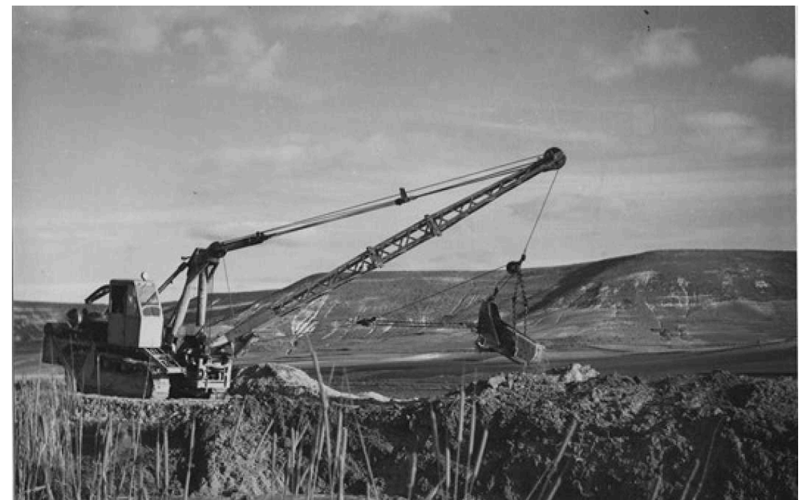
En la figura: Dragalina ejecutando obras de mejora del cauce del Río Esgueva en las proximidades de Renedo de Esgueva por orden del Instituto como parte del programa de mejoras que tenía programadas.
