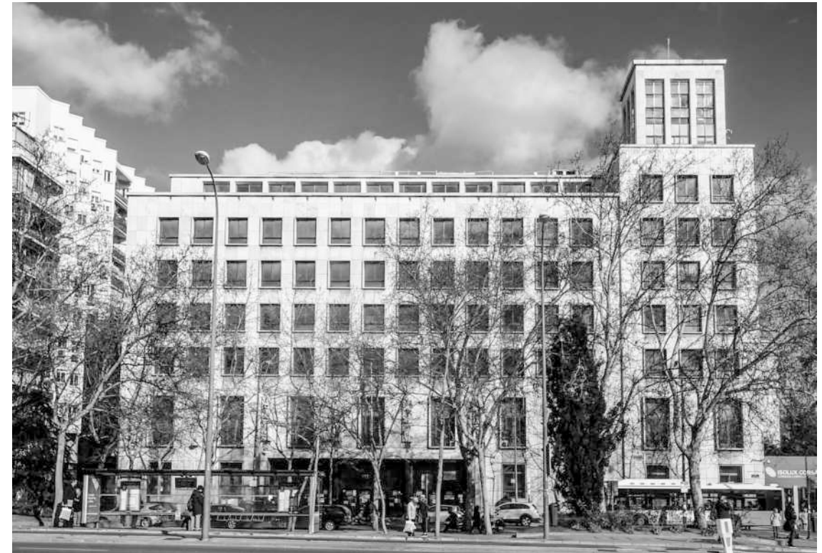
En la figura: Antigua sede del Instituto Nacional de Colonización en el Paseo de la Castellana, Madrid, obra de José Tames Alarcón, jefe del Servicio de Arquitectura del Instituto.
