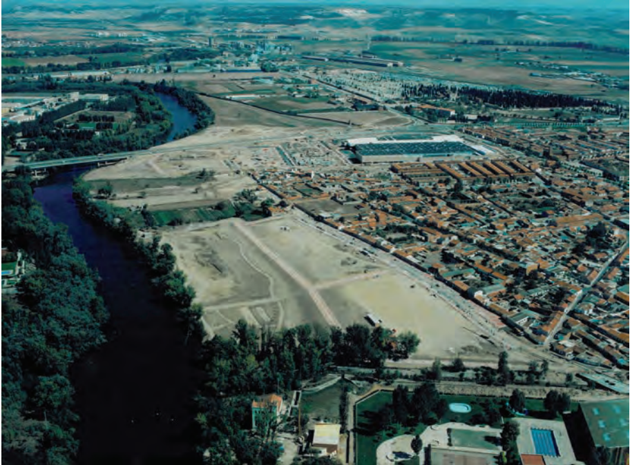
Fig. 37. Obras de urbanización del plan parcial Soto de Medinilla. Al fondo, centro comercial de Pryca, junto a la ronda norte.
