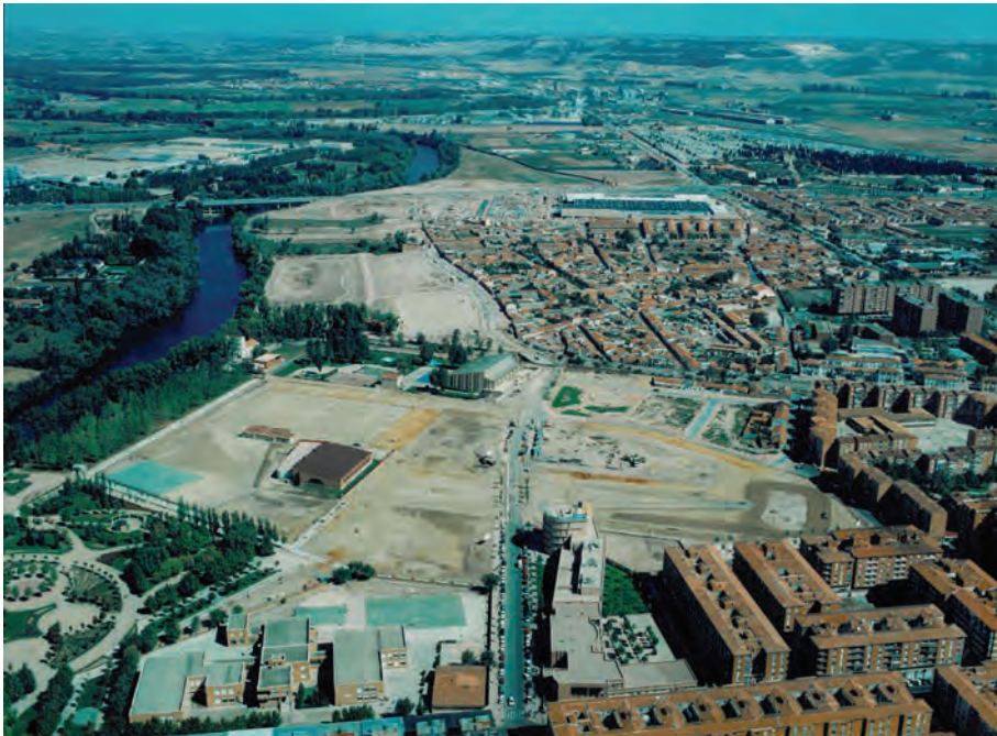
Fig. 31. Obras de urbanización del plan parcial Ribera de Castilla.
