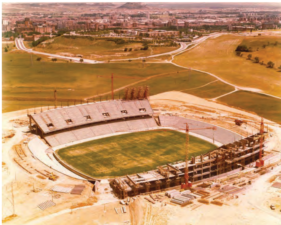
Fig. 17. Obras de construcción del Estadio Nuevo José Zorrilla en 1981. Fuente: Archivo Municipal de Valladolid, AM 5-8.
