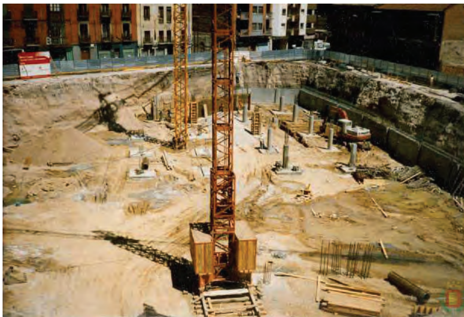
Fig. 16. Obras de construcción del mercado municipal de El Campillo.
