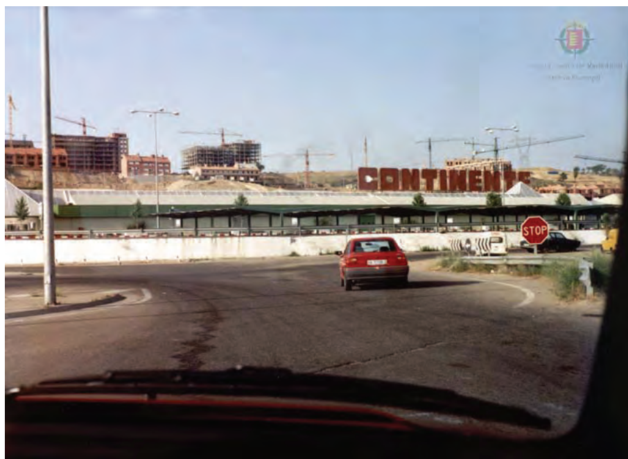
Fig. 36. Centro comercial Continente en 1982. Al fondo, edificios en construcción en Parquesol.
