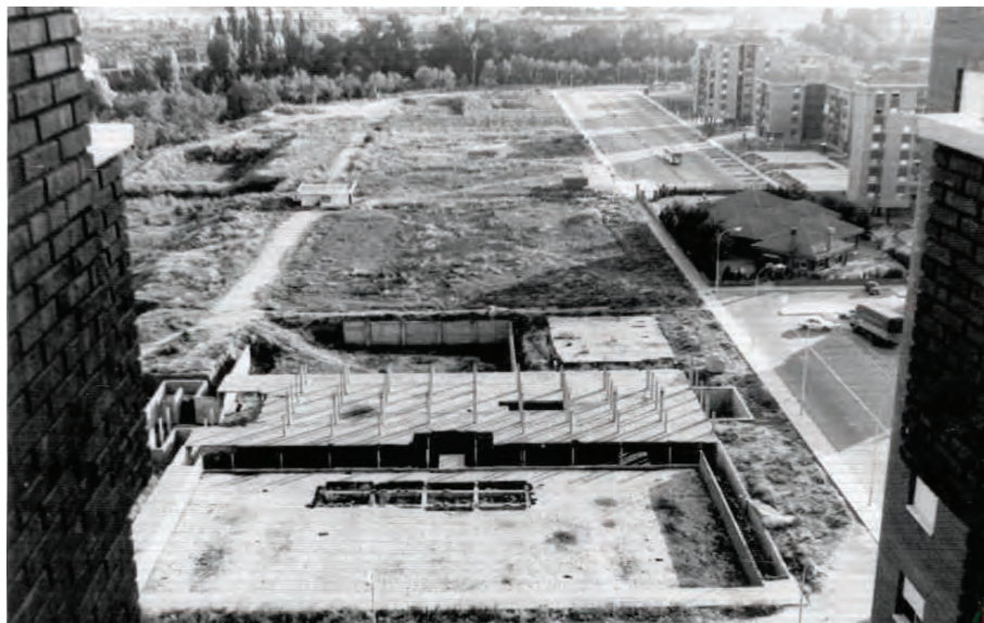
Fig. 18. Obras de construcción del Polideportivo Pisuerga. Fuente: Archivo Municipal de Valladolid, ONXZ 927-4.
