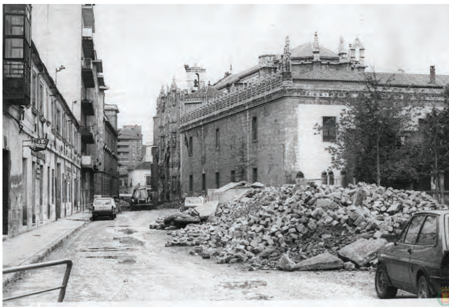
Fig. 21. Obras de peatonalización de la calle Cadenas de San Gregorio.
