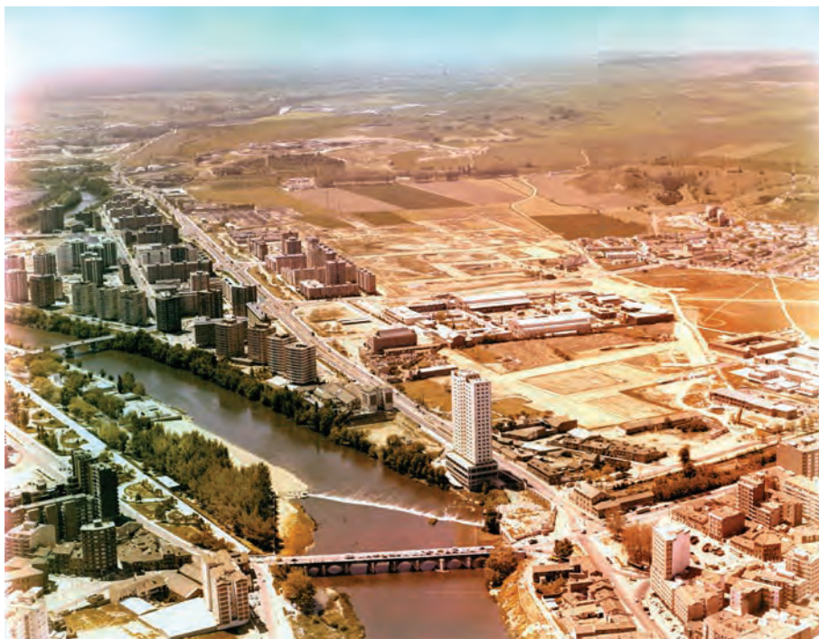
Fig. 28. Vista aérea de las obras de urbanización de la segunda fase de Huerta del Rey.
