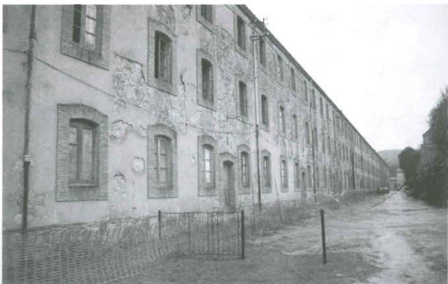
Fig. 42. Bloque de viviendas para obreros de la Colonia Pons, en Puig Reig (Barcelona).
