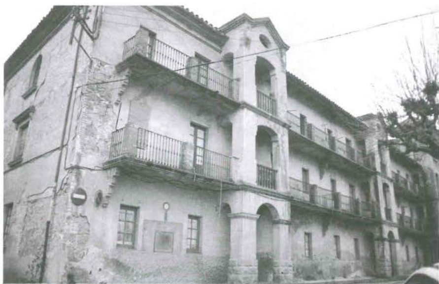
Fig. 48. Uno de los bloques de viviendas para obreros de la Colonia Prat (Puig Reig, Barcelona).
