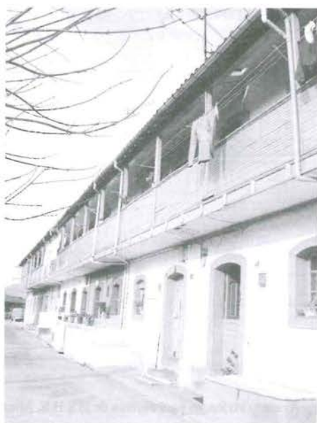
Fig. 58. Cuartel de San Antonio, de los "Cuarteles Viejos" de la Sociedad Hullera Española Minas de Aller, en Caborana (Asturias).
