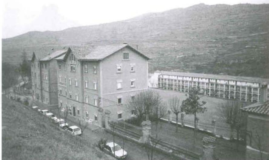
Fig. 45. Diferentes bloques de viviendas en El Guixaró, Puig Reig (Barcelona).
