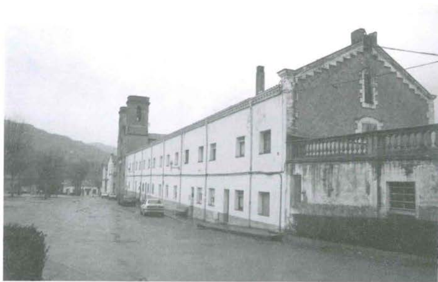
Fig. 43. Viviendas de la Colonia Viladomíu Nou, en Gironella (Barcelona).
