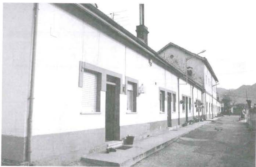
Fig. 63. "Cuarteles Nuevos" de la S.H.E. Minas de Aller, en Caborana (Asturias).
