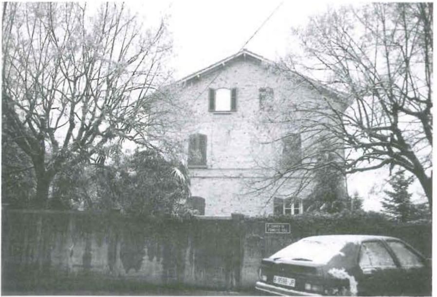
Fig. 54. Cuarteles obreros y casas para empleados de la Solvay en Suria (Barcelona).
