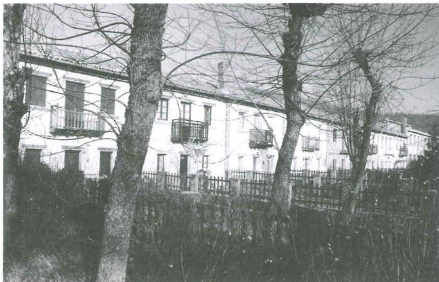
Fig. 70. Viviendas de Hulleras de Sabero en la Colonia de Sabero (León). Grupo de viviendas unifamiliares en la carretera de Olleros.
