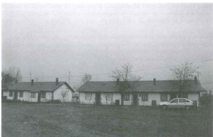
Fig. 74. Casas de Cristalería Española en la Colonia de Arijia (Burgos). Arriba: casas pareadas, probablemente para empleados. Abajo: casas de una planta, posiblemente para obreros.
