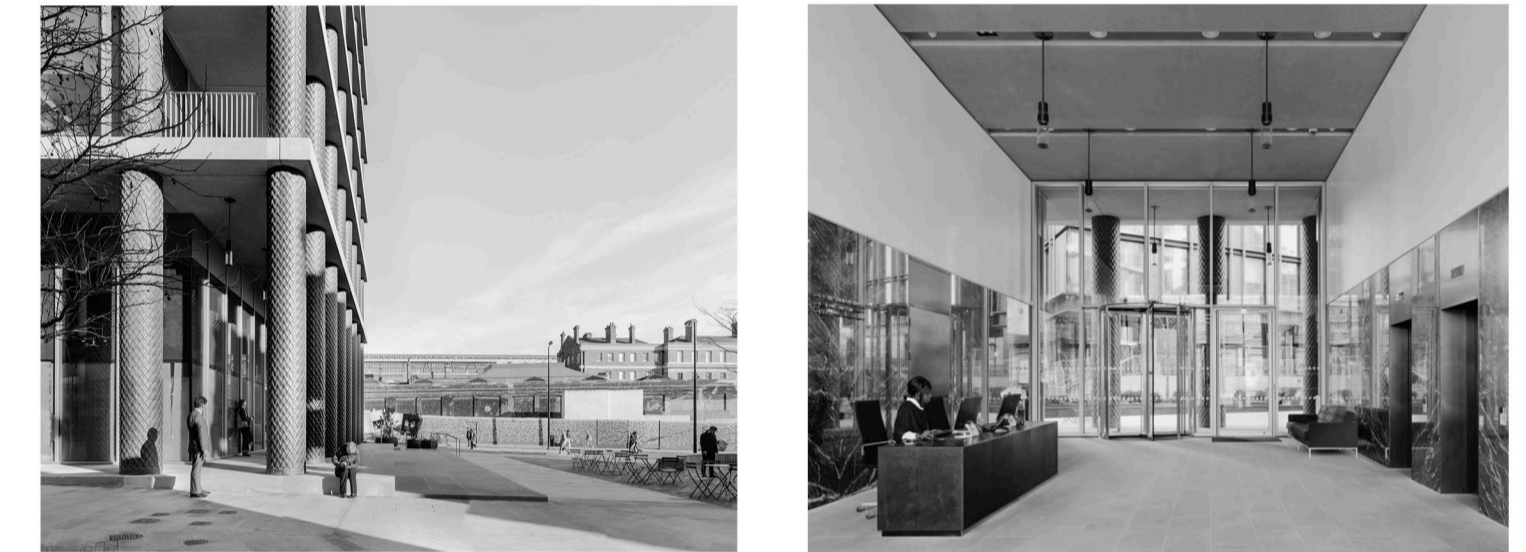
One Pancras Square, Basel. David Chipperfield Architects. Imagen: Divisare Soportal perimetral en planta baja y sistema en fachada de pilastras conformando una retícula homogénea.
