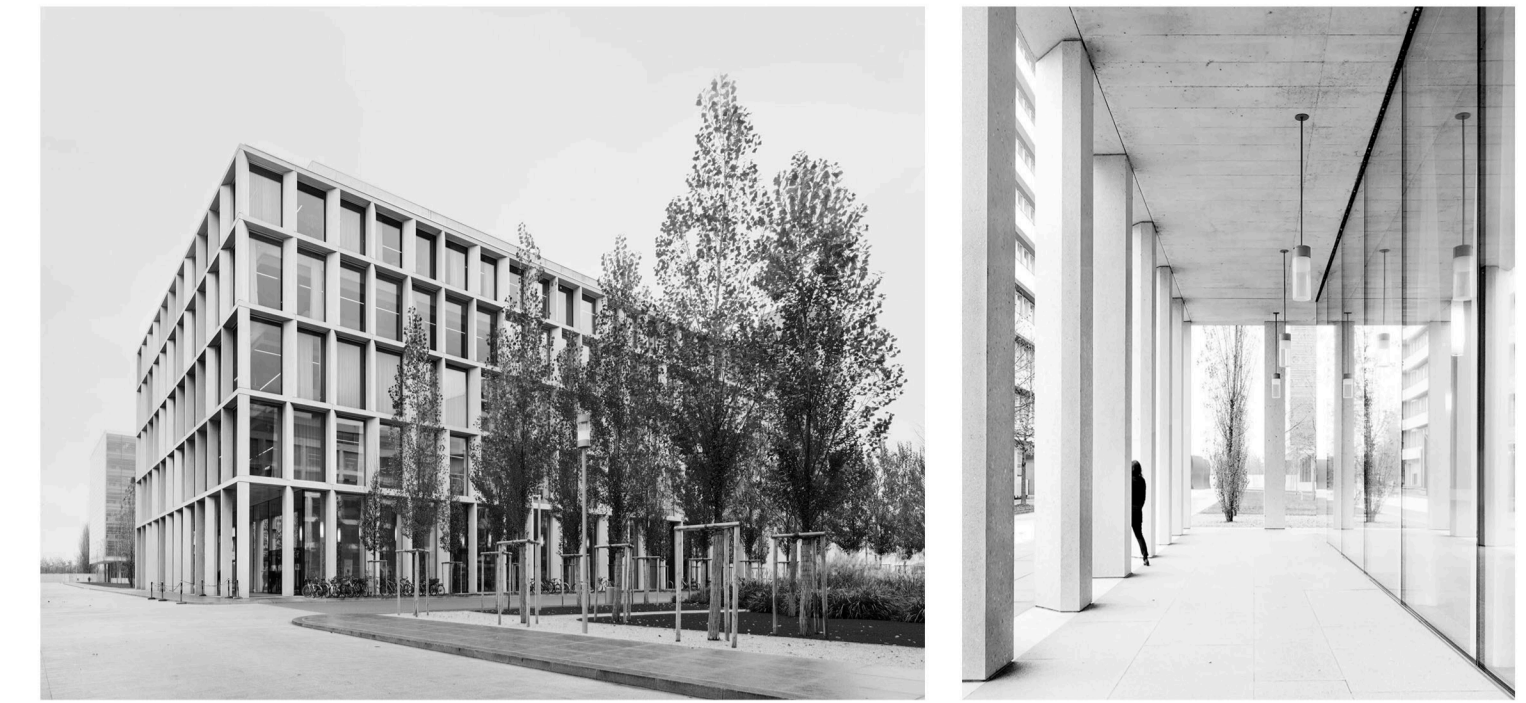
Novartis laboratory building, Basel. David Chipperfield Architects. Imagen: David Chipperfield Architects Soportal perimetral en planta baja y sistema en fachada de pilastras conformando una retícula homogénea.
