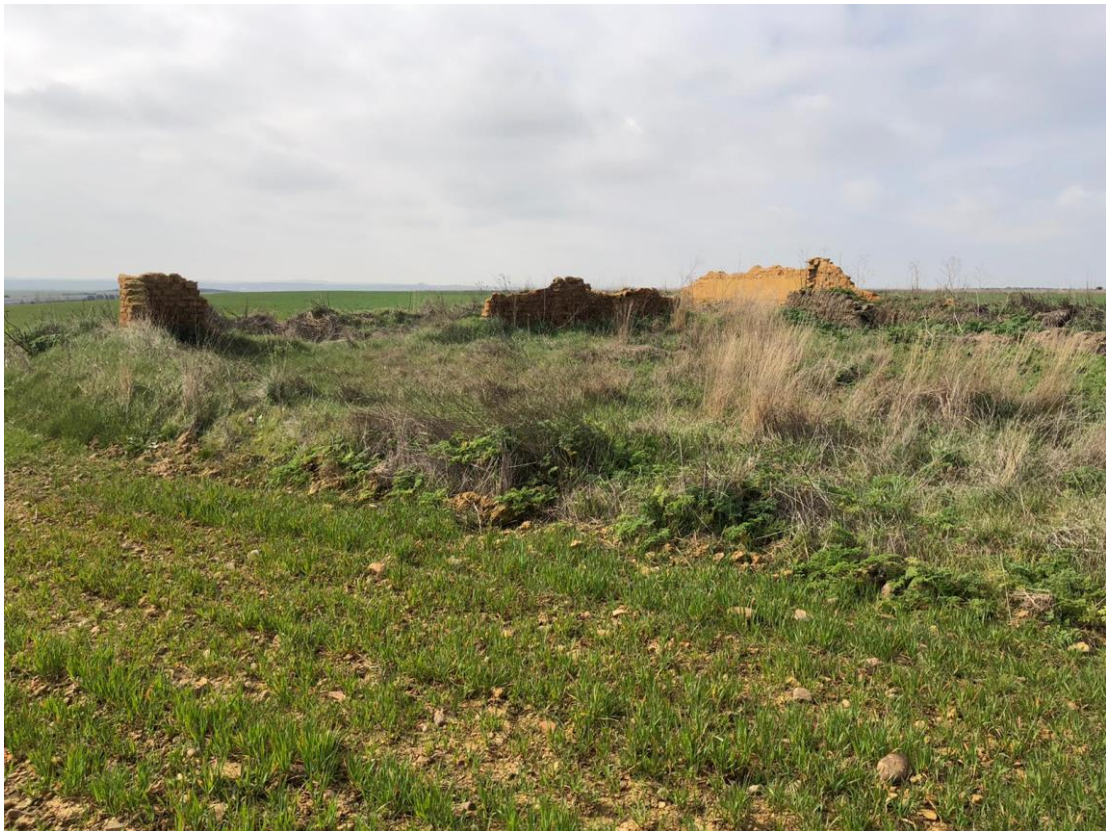
Imagen 15: Corral ganadero derrumbado
