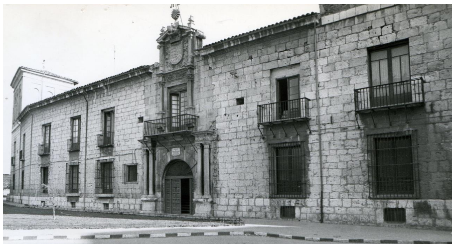
Figura 5. Fachada de la casa del licenciado Leguizamón.
