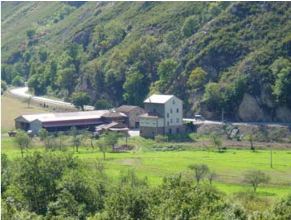
Fig. 22: Nave agroindustrial en Selviella, Belmonte de Miranda
