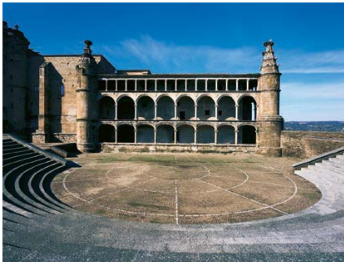
FIG. 47 Vista exterior de la Hospedería del convento, con el espacio urbanizado delante para auditorio
