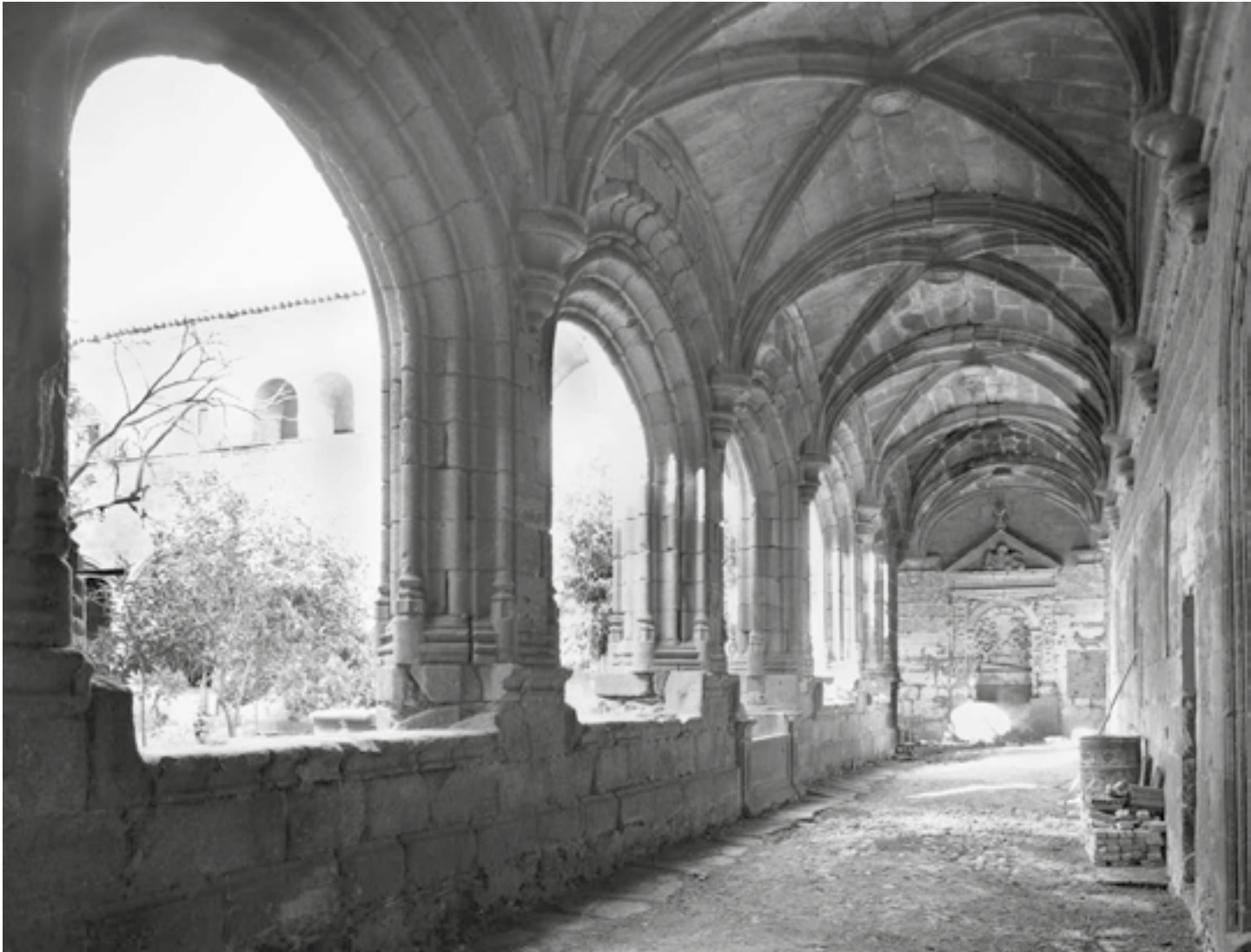
FIG. 42 Claustro del convento antes de la restauración. Archivo Iberdrola
