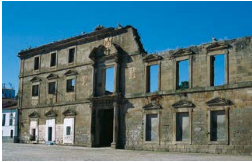
FIG. 20 Casa de los Roco-Campofrío
