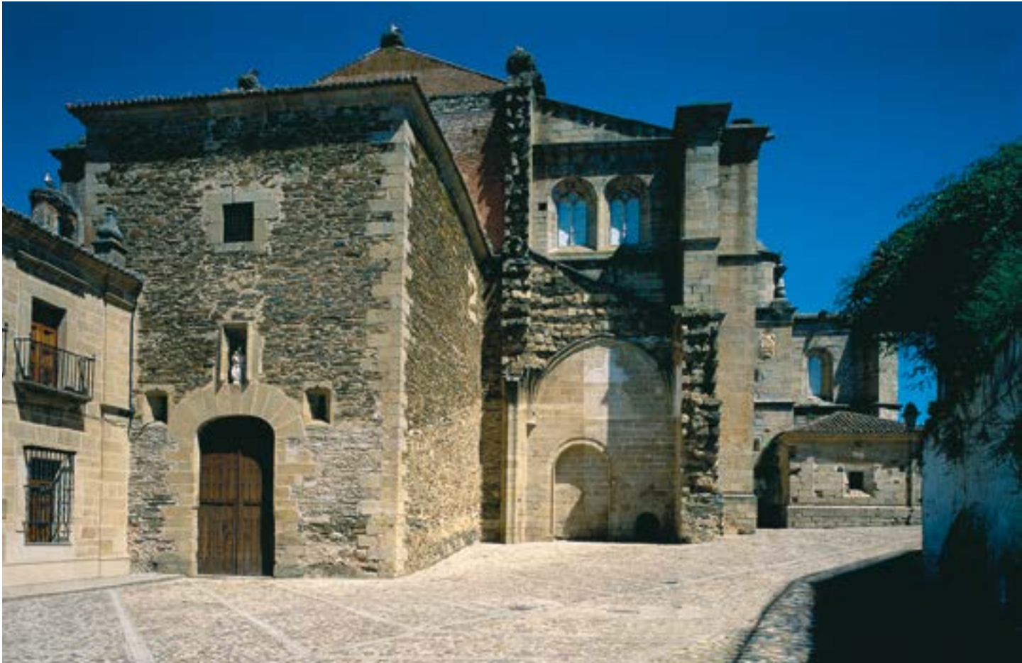
FIG. 137 Exterior suroccidental de la iglesia conventual, mostrando la inferior calidad constructiva con que se improvisó la terminación de su fábrica
