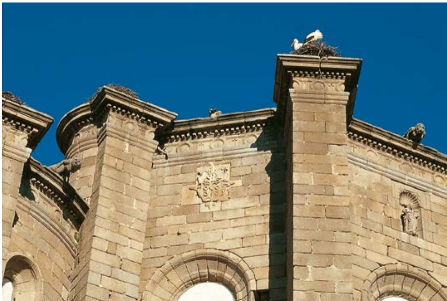
FIG. 70 Culminación del ábside central en cuyo exterior está la hornacina avenerada con la Virgen y el Niño, y a los lados sendos escudos de la Orden de Alcántara (árbol con trabas sobre la cruz)
