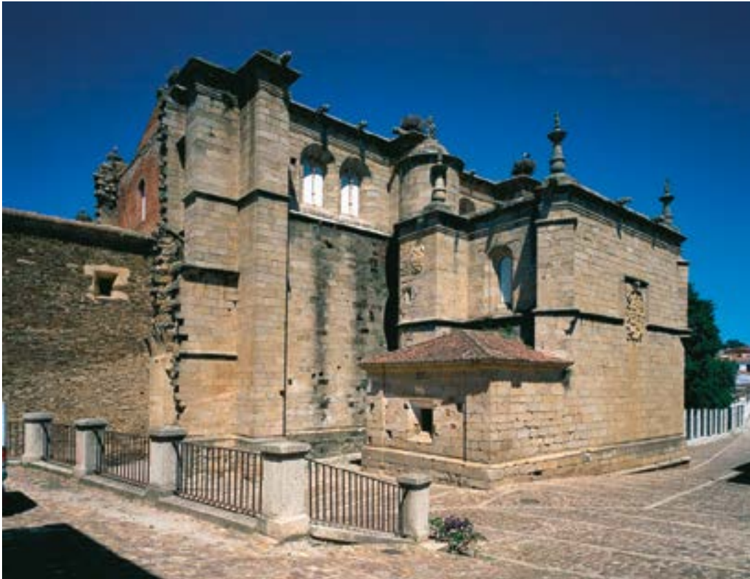
FIG. 46 Aspecto exterior de la iglesia conventual, donde se aprecia la calidad arquitectónica general del templo y la capilla del comendador de Piedrabuena, contrastando con la deficiente terminación improvisada en la nave posterior
