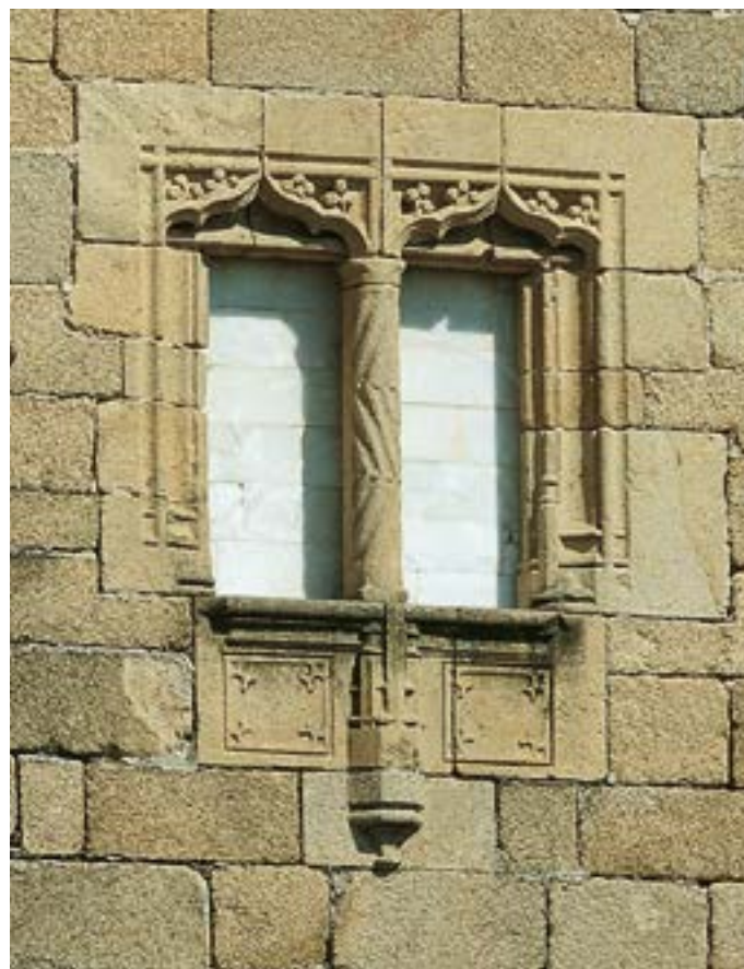
FIG. 172 Detalle de la elaborada ventana doble de la sobresacristía a la que se accede por la «escalera de San Gil»
