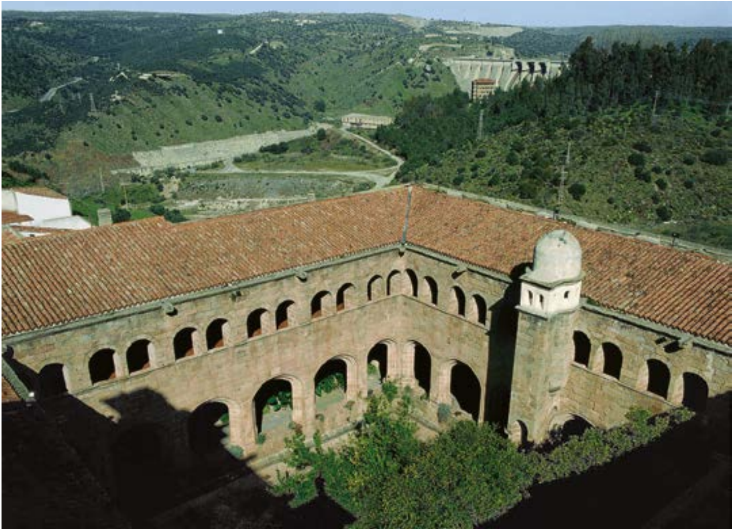
FIG. 52 Vista aérea del claustro conventual
