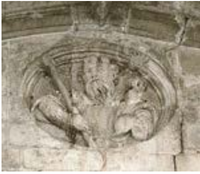
FIG. 99 Medallón de Josué, en el tramo anterior del lado del evangelio
