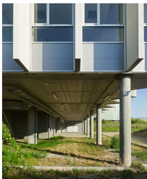
Figura 4.6 Vista del pavimento drenante de la planta de aparcamiento
