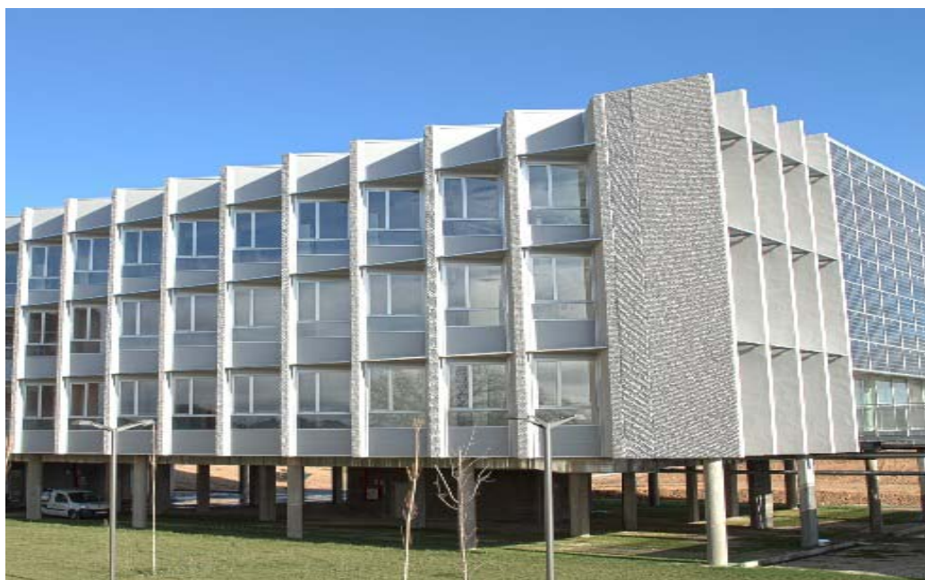
Figura 4.14 Fachada Oeste. El sol incide plenamente sobre la parte ‘recta’ de la fachada (a la derecha), mientras las ventanas giradas están sombreadas
