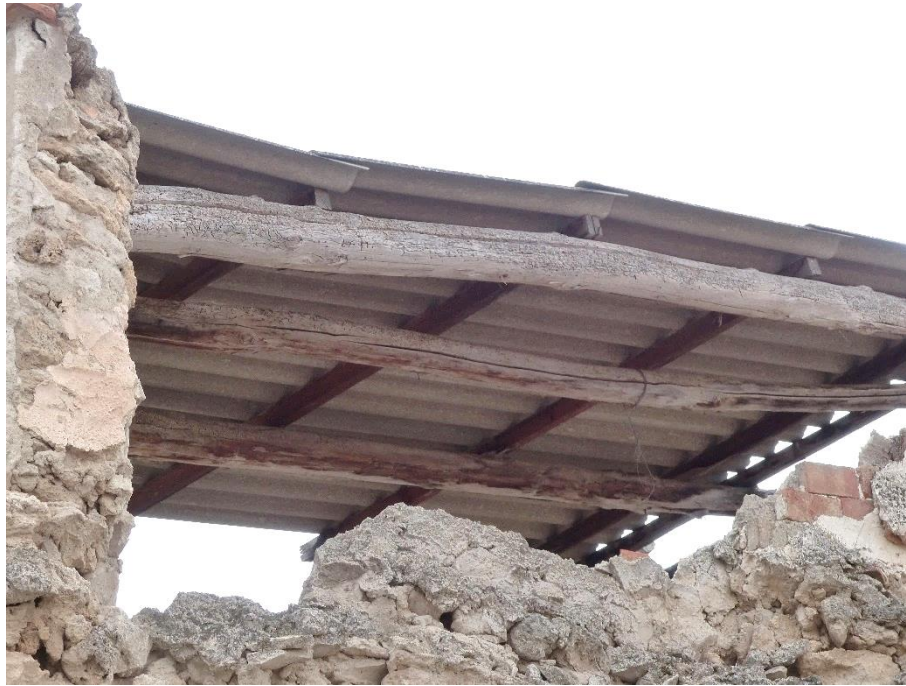
Figura 163. Las vigas de chopo conviven con nuevos materiales constructivos como las tejas de fibrocemento. Imagen propia.
