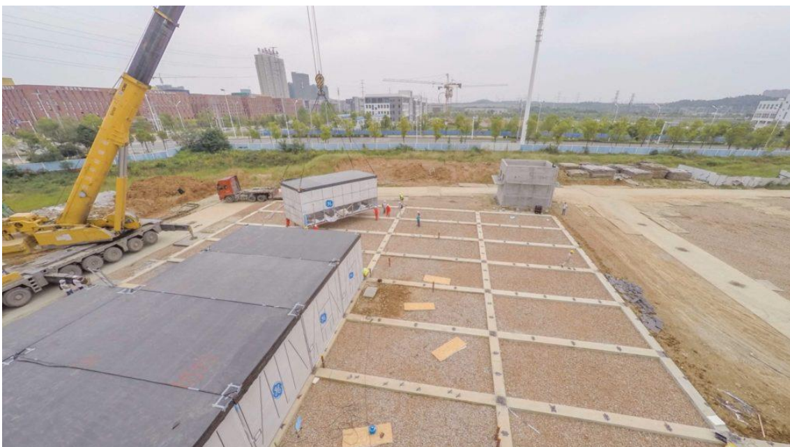
Ilustración 8. colocación de módulos para la planta KUBio en Wuhan, China
