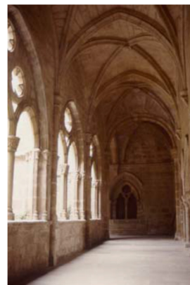
Fig. 125._ Claustro Ala Sur.
