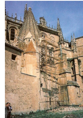
Fig. 37._ Intervención en la Sala Capitular del año 1980.
