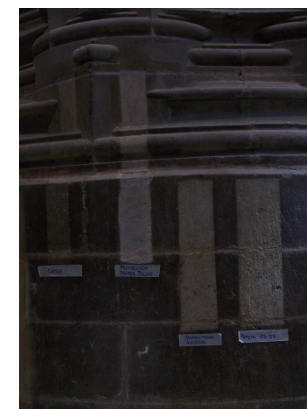
Fig. 84._ Estudios preliminares. Restauración del interior de la Catedral Nueva. Pruebas de limpieza para el granito.
