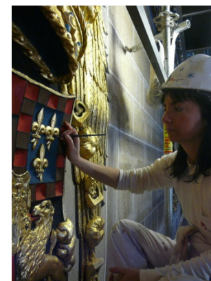
Fig. 105._ Proceso de los trabajos de restauración y dorado. Restauración del interior de la Catedral Nueva. Detalle escudo.
