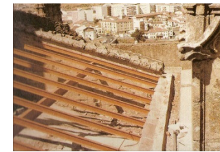
Fig. 36._ En la intervención de 1980, se desmontaron y sanearon las cubiertas del crucero y de las naves laterales en su totalidad.
