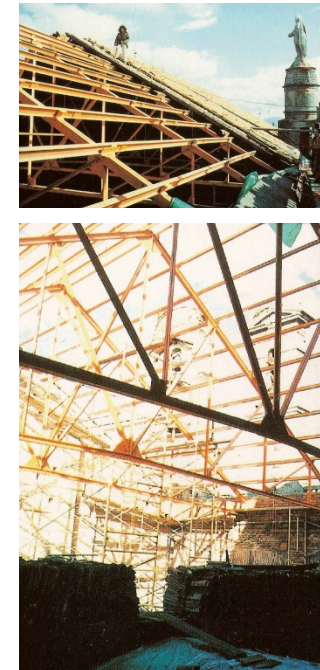
Fig. 33 y 34._ Estado previo de la cubierta central una vez desmontado parte de las tejas, en la intervención de 1979. Estructura metálica con pares y contrapares de madera, tillado cargado de escombros bajo las tejas. En la intervención de 1979, la D. F. decidió mantener la estructura metálica existente que se había colocado en la intervención de 1929 por su valor histórico. Es una estructura roblonada con cercha múltiple en el cabecero. Araujo & Nadal.
