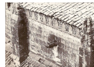
Fig. 39._ Macizado del remate de las almenas originarias. Cubierta Catedral Antigua.
