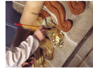
Fig. 106._ Proceso de dorado, colocación de la hoja de oro y aplacado. Restauración del interior de la Catedral Nueva. Detalle bóvedas.
