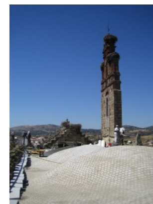
Figs. 79 y 80._ Restauración de las cubiertas de la Catedral Antigua. Estado inicial antes de la intervención, y estado final. Nave central.
