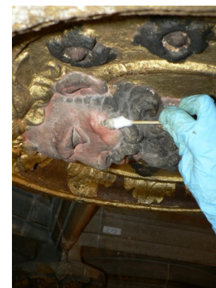
Fig. 91._ Proceso de limpieza. Restauración del interior de la Catedral Nueva. Detalle clave.
