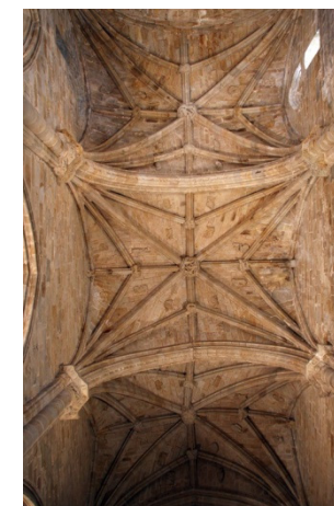
Fig. 116._ Catedral Antigua. Nave central. Bóvedas de crucería de combados angevinos y terceletes con medallones en claves.
