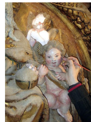
Figs. 94 y 95._ Proceso de estucado y reintegración cromática. Restauración del interior de la Catedral Nueva. Detalle relieve portada de acceso a la sacristía.
