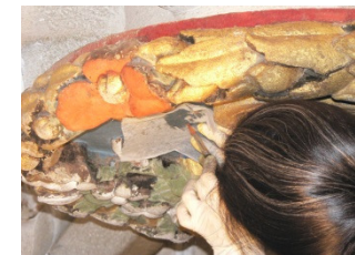
Fig. 88._ Proceso de fijación de la policromía mediante empapelado. Restauración del interior de la Catedral Nueva. Detalle clave.
