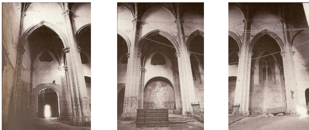
Figs. 46, 47 y 48._ Restauración del interior de la Catedral Antigua. Los paramentos se encontraban encalados, y los huecos cegados.
