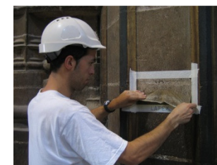
Fig. 83._ Estudios preliminares. Restauración del interior de la Catedral Nueva. Pruebas de limpieza para el granito.
