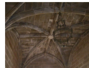
Fig. 151.- Bóveda de la cerería.
