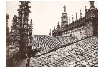
Fig. 35._ Cubiertas del crucero y naves laterales de la Catedral Nueva. Araujo & Nadal.
