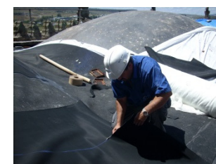
Figs. 71, 72, 73 y 74. Restauración de las cubiertas de la Catedral Antigua.
