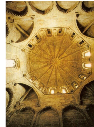
Figs. 60 y 61._ Restauración de la Torre del Melón. Exterior e interior.
