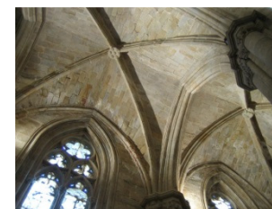
Fig. 117._ Interior de la Catedral Antigua. Bóvedas de ojiva.
