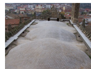
Figs. 75, 76, 77 y 78._ Restauración de las cubiertas de la Catedral Antigua.
