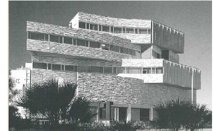
Oficinas Caja de Ahorros de Mediterráneo. Alicante. (1988)
