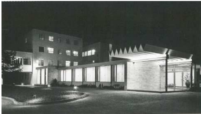
Edificio de Dirección de los Laboratorios Alter. Madrid. (1959)
