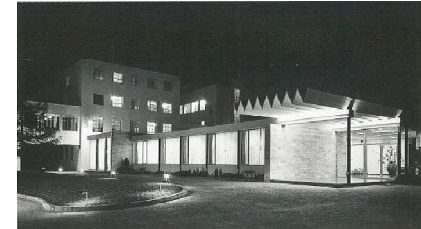
Pabellón de los Laboratorios Alter en Madrid (1960)
