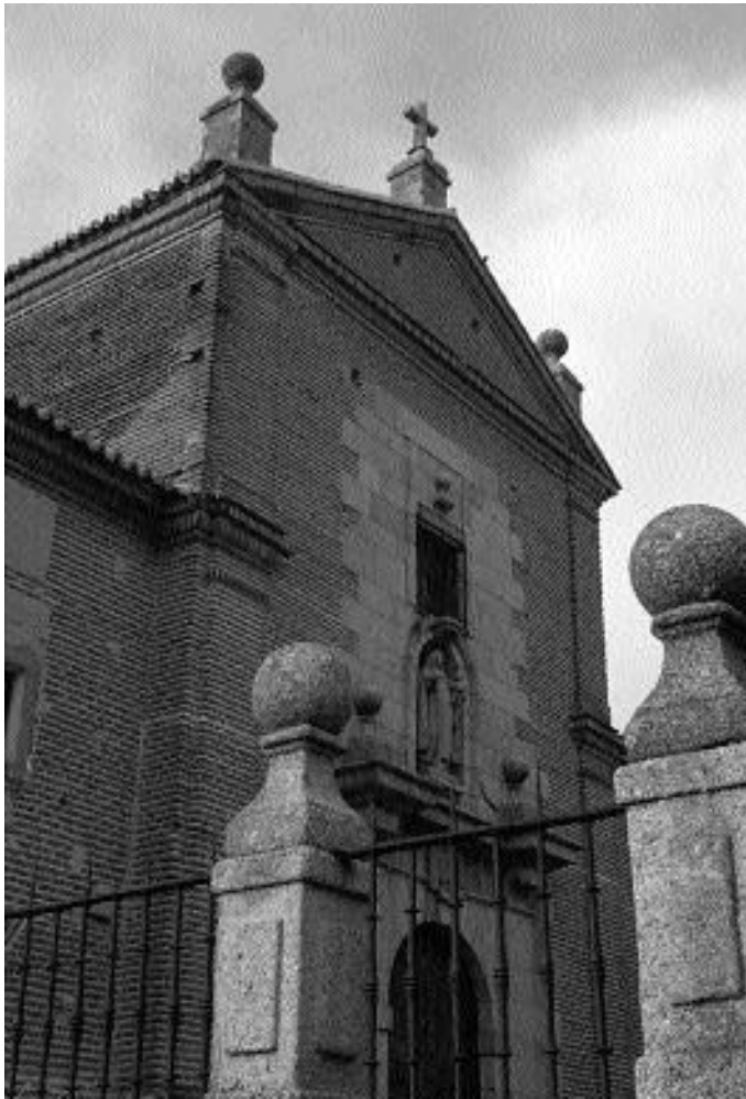
Fig. 29:Detalle de la fachada principal del Convento de las Carmelitas Descalzas
