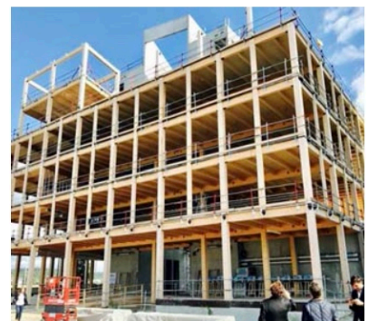
Structure construction process. Nicolas Laisné y Dimitri Roussel. Batiactu. https://n9.cl/69u9a
