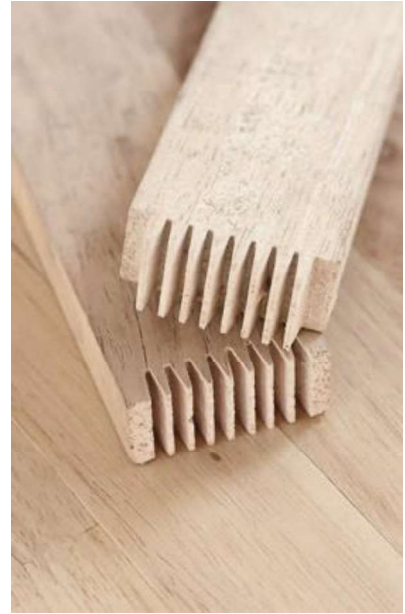
Fig. 61. Empalme mediante uniones dentadas o a peine ( finger joints ). Fuente: https://cutt.ly/Emc7qlp
