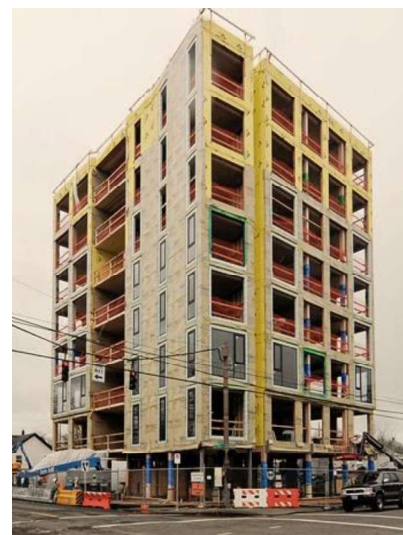
Fig. 66. Fotografía de la estructura de edificio Carbon 12, Portland. Fuente: https://n9.cl/8p1nr
