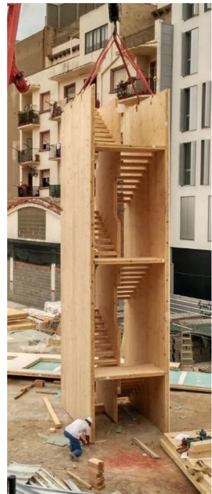
Fig. 65. Montaje del núcleo de escaleras del edificio La Borda, en 2018 en Barcelona, España. Fotografía cedida por el equipo de arquitectos Lacol.
