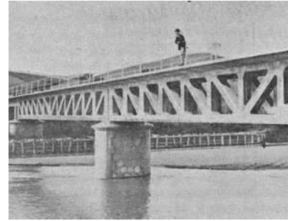
Fig. 48. Puente sobre el río Vélez en 1909. Fuente: http://ingenieriacivil.cedex.es/index.php/ingenieria-civil/article/view/2402
