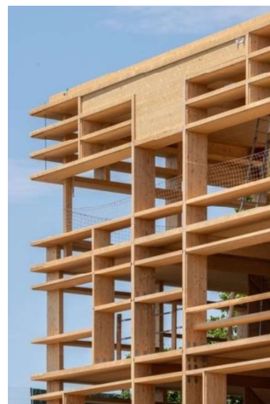
Fig. 91. Estructura del edificio OSH ( Our Shelves House ), Madrid. Fuente: Jesús Granada en https://n9.cl/getox
