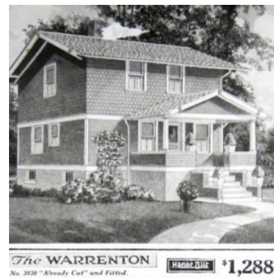
Fig. 19. Casa prefabricada con estructura ligera en Carlinville, Illinois. Fuente: https://cutt.ly/emzd7KI
