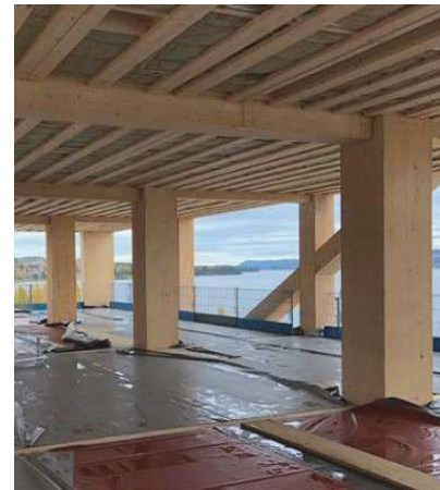
Fig. 69. Fotografía del forjado durante la construcción de la Torre Mjøstårnet, Noruega. Fuente: https://cutt.ly/fmyKyuc
