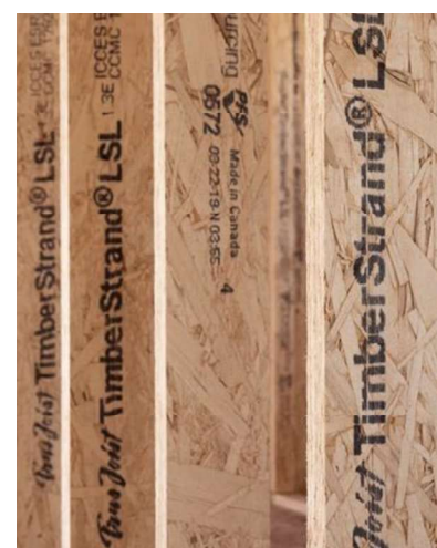
Fig. 72. Montantes LSL como estructura de un sistema de entramado ligero. Fuente: https://cutt.ly/wmug3z5
