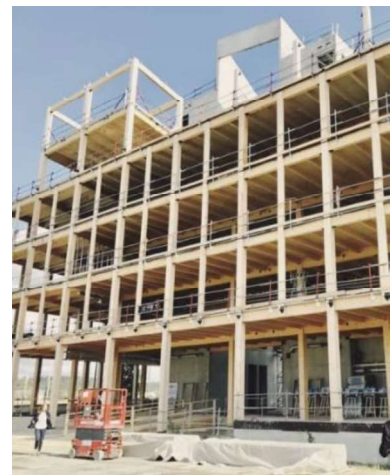
Fig. 85. Fase de estructura durante la construcción del edificio Office Perspective en Burdeos, Francia. Fuente: https://cutt.ly/cmuGqBp
