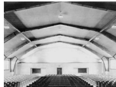
Fig. 58. Estructura con vigas en arcos lamiados encolados en el gimnasio de Peshtigio, Wisconsin Fuente: https://cutt.ly/fmtPjiV
