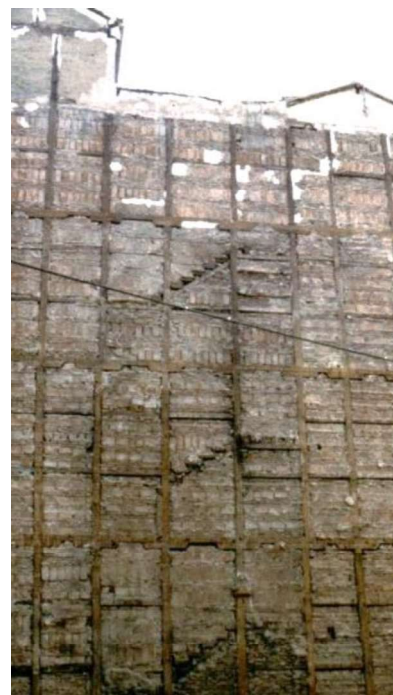
Fig. 12. Muro entramado en Madrid. Fuente: (García, 2006, p. 17).
