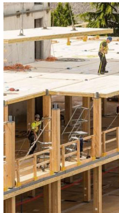
Fig. 67. Fase de estructura del edificio Brock Commons Student Hall , Vancouver. (53 m). Fuente: https://www.naturallywood.com/project/brock-commons-tallwood-house/
