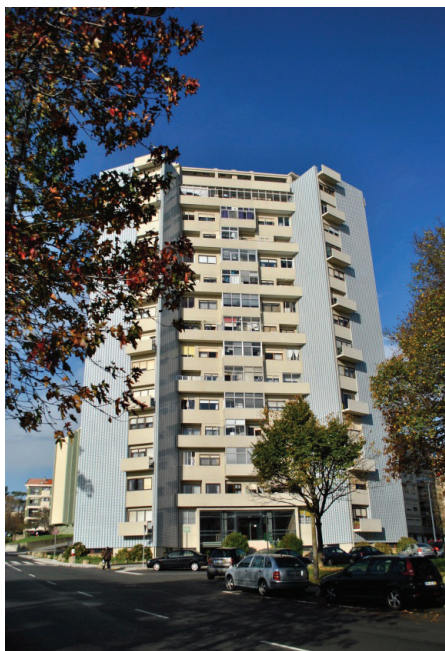
Fig. 225 - Fachada de uma das torres habitacionais do complexo da Pasteleira, Porto, 1963-1967. Arq. Pedro Ramalho e Sérgio Fernandez.
