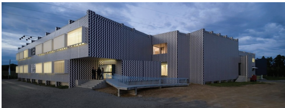
Fig. 269 - Aspecto geral do edifício “Incubadora de Empresas”, Vila Verde, Braga, 2007. Arq. Manuel Graça Dias e Egas José Vieira.
