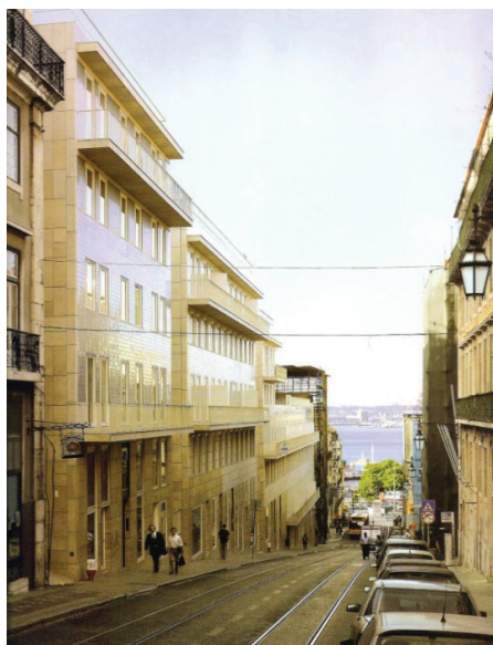
Fig. 257 - Fachada revestida de azulejos azuis da Rua do Alecrim, Lisboa, 2004. Arq. Álvaro Siza Vieira. In: CECILIA, Fernando Márquez e LEVENE, Richard, Álvaro Siza 2001-2008, El Sentido de las Cosas, El Croquis n.º 140, Madrid, Editorial Croquis, 2008, p. 85.
