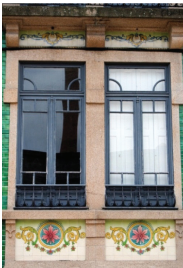
Fig. 108 - Detalhe de um edifício na Rua António Granjo, Porto. Azulejos que combinam o gosto "Beux-Arts" e Arte Nova. Início do Séc. XX.
