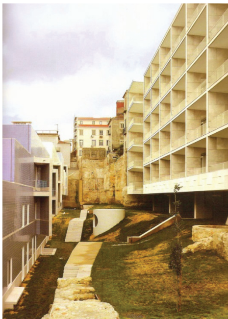
Fig. 258 - Espaço interior entre o bloco da Rua do Alecrim e da Rua António Maria Cardoso. Lisboa, 2004. Arq. Álvaro Siza Vieira. In: CECILIA, Fernando Márquez e LEVENE, Richard, Álvaro Siza 2001-2008, El Sentido de las Cosas, El Croquis n.º 140, Madrid, Editorial Croquis, 2008, p. 85.
