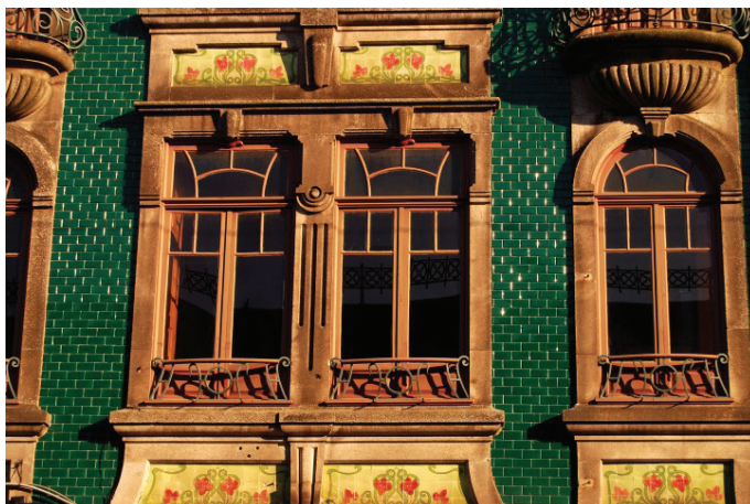
Fig. 94 - Edifício ao gosto “Beux-Arts” na rua Alexandre Braga, no Porto. Revestimento a azulejos de lingote e elementos decorativos Arte Nova. Final do Séc. XIX, início do Séc. XX.
