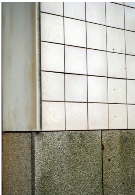
Fig. 248 - Detalhe do remate da superfície azulejada com as ombreiras e o roda-pé. Edifício de habitação e comércio na Boavista, Porto, 1990-1998. Arq. A. Siza Vieira e A. Madureira.
