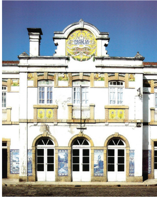
Fig. 117 - Fachada voltada para a rua da estação ferroviária da Granja. Azulejos Arte Nova e monocromáticos, 1914. Foto in: CALADO, Rafael Salinas e ALMEIDA, Pedro Vieira de, Aspectos azulejares na Arquitectura Ferroviária Portuguesa , CP – Caminhos de Ferro Portugueses, E.P., 2001, p. 57.
