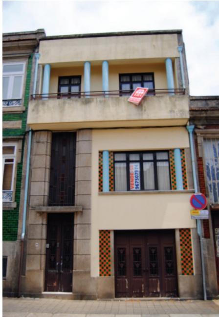
Fig. 160 - Fachada principal do edifício da Rua António Granjo n.º 102, Porto, 1938. Arq. Aucíndio dos Santos.
