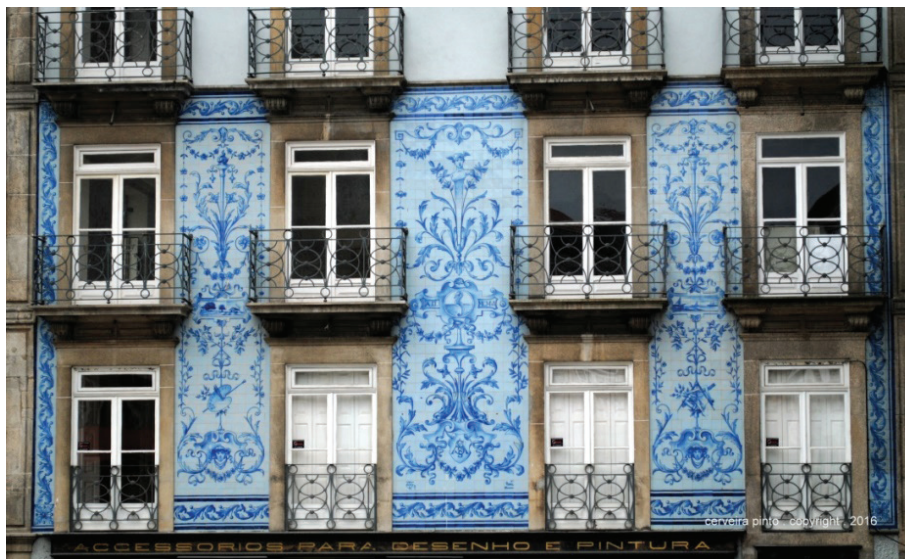
Fig. 81 - Fachada do edifício do Largo S. Domingos, no Porto, da autoria de Silvestre Silvestri/Mário Branco, 1906.
