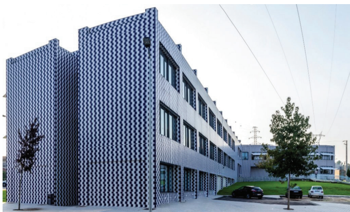
Fig. 270 - Aspecto geral do edifício “Incubadora de Empresas”, Vila Verde, Braga, 2007. Arq. Manuel Graça Dias e Egas José Vieira.
