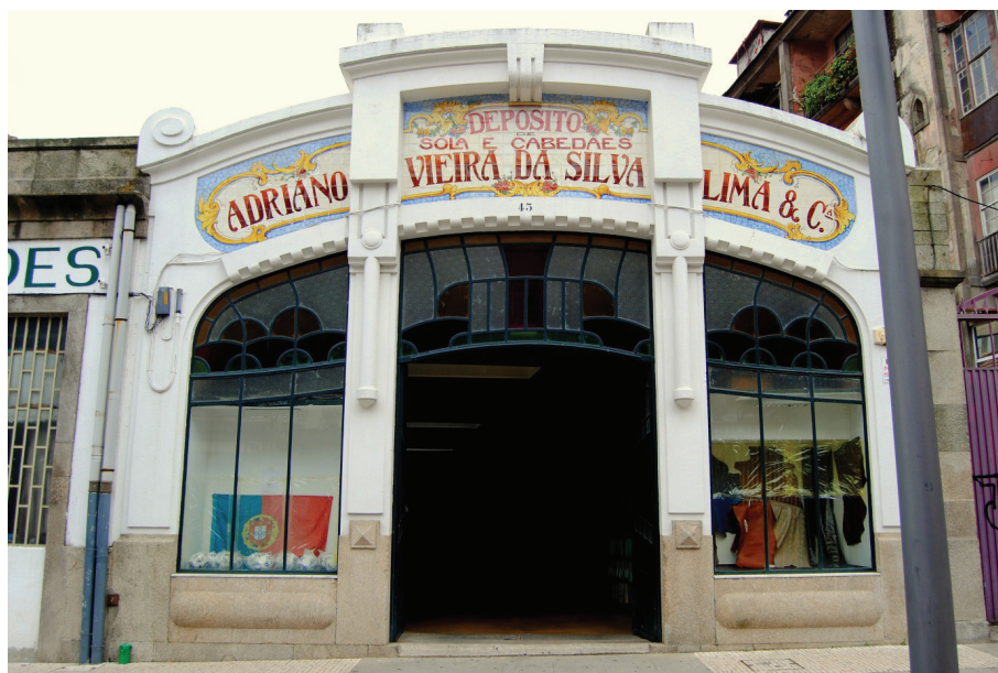
Fig. 111 - Fachada de características Arte Nova/Art Déco do edifício do do “Depósito de Sola e Cabedães Adriano Vieira da Silva Lima & C.ª”, localizado no n.º 43 da Rua do Ateneu Comercial do Porto. Início do Século XX.
