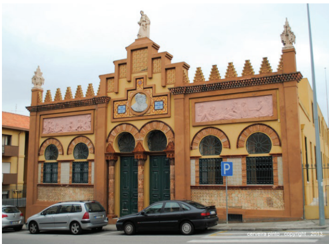
Fig. 76 - Edifício na rua Almeida Costa, em Gaia, com características semelhantes ao da rua José Falcão, no Porto, provavelmente também da autoria de Teixeira Lopes. Séc. XIX.
