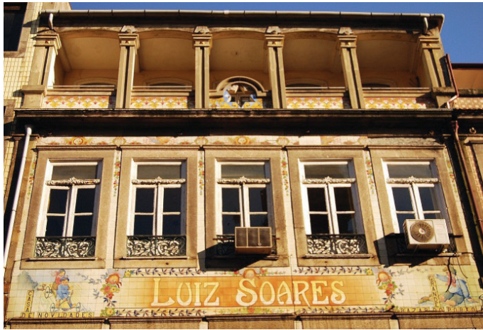
Fig. 112 - Fachada do "Grande Bazar do Porto - Luiz Soares", na Rua de Santa Catarina. Azulejos polícromos do início do Séc. XX.
