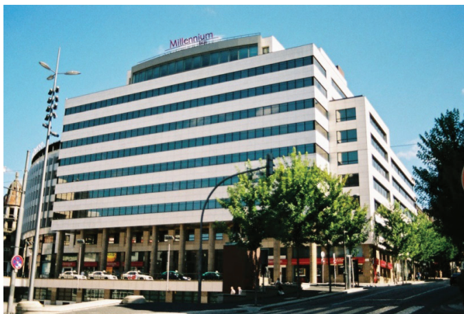
Fig. 173 - Aspecto do edifício “Palácio Atlântico”, na actualidade. ARS Arquitectos, 1944-1950.
