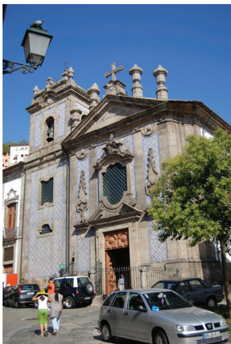
Fig. 57 - Fachada principal da Igreja de S. Pedro de Miragaia (1740). Revestimento azulejar de padrão, datado de 1863/1876.
