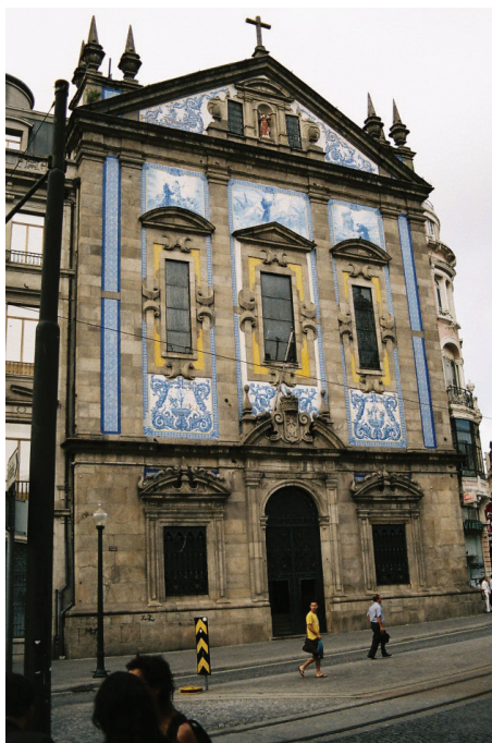
Fig. 83 - Fachada actual da Igreja dos Congregados (1836). Azulejos criados por Jorge Colaço e pintados por Jorge Colaço e F. Mendes de Oliveira colocados em 1929.
