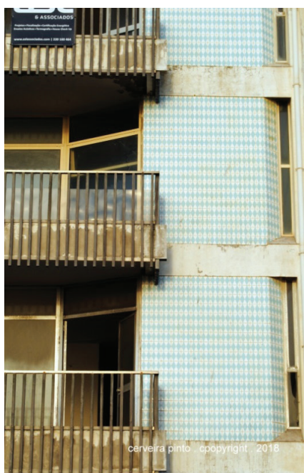
Fig. 224 - Detalhe da fachada com o revestimento de azulejos do edifício de habitação e comércio da Avenida Brasil, Porto, 1963. Arq. José Carlos Loureiro.
