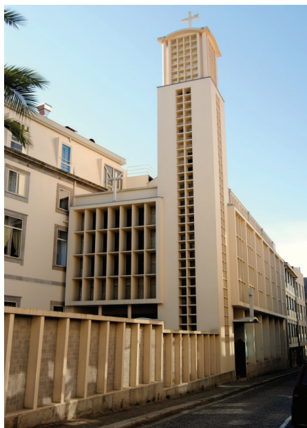
Fig. 178 - Igreja de N.ª Sra. do Perpétuo Socorro. Gaveto da Rua da Firmeza com Alves da Veiga, 1951-1953. Arq. Fernando Tudela e Fernando Barbosa.
