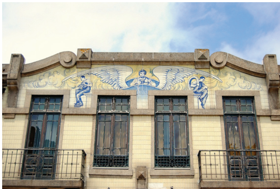
Fig. 114 - Edifício de garagem/oficina localizado na Avenida Camilo, no Porto. Os azulejos e a própria construção detêm algumas características Art Déco. Primeiras décadas do Séc. XX.
