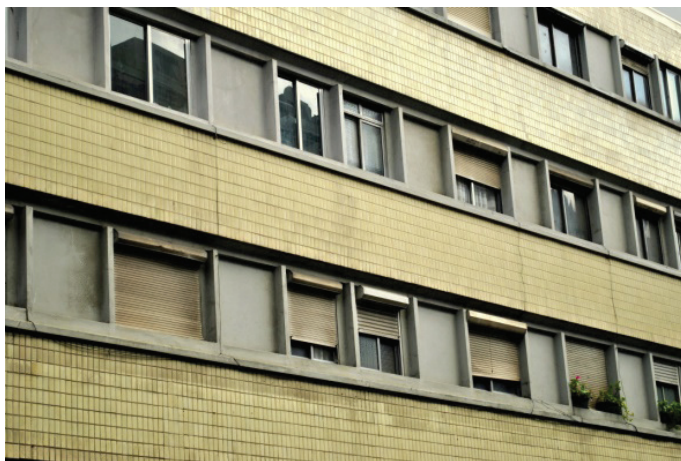
Fig. 186 - Detalhe da fachada do Bloco de Latino Coelho, Porto, 1952-1956.
