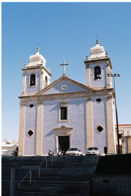
Fig. 71 - Igreja Paroquial de Mafamude, Gaia (Séc. XIX). Revestimento azulejar, de padrão, aparentemente da mesma época.
