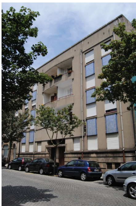
Fig. 153 - Fachada principal do edifício de habitação multifamiliar da rua Ferreira Cardoso n.º 172-174, Porto, 1936. Azulejos de padrão Art Déco. Arq. Homero Ferreira Dias.
