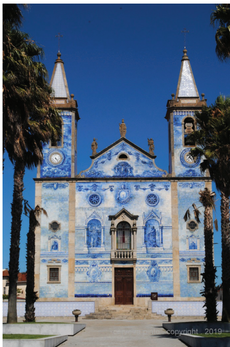
Fig. 92 - Fachada principal da Igreja de Santa Marinha de Cortegaça (1910-1918). Azulejos de padrão monocromáticos com painéis com representações figurativas de Santos.
