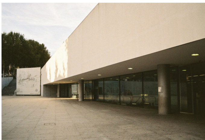
Fig. 271 - Aspecto geral do exterior da estação de Metro da Trindade, Porto, 2001-2008. Arq. Eduardo Souto de Moura.
