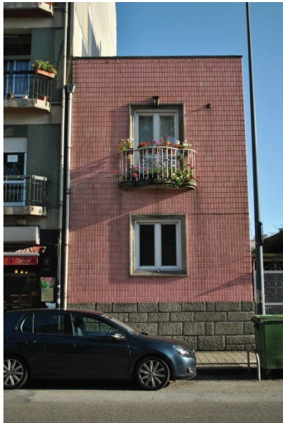
Fig. 137 - Edifício da Rua da Constituição, 1944. Azulejos cor-de-rosa, de lingote, colocados na posição vertical. Arq. Januário Godinho.
