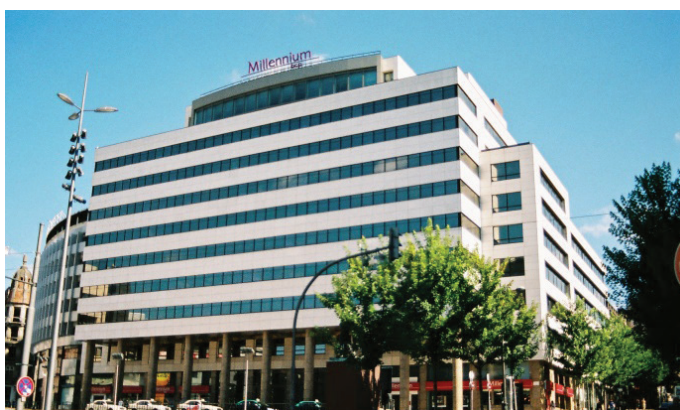
Fig. 122 - Imagem actual do edifício “Palácio Atlântico”, na Praça de D. João I, no Porto, da autoria da ARS arquitectos, 1950. Um edifício “funcionalista”, que adopta uma linguagem corbusiana e que aparenta ser o primeiro edifício moderno a utilizar azulejos figurativos policromos no exterior.
