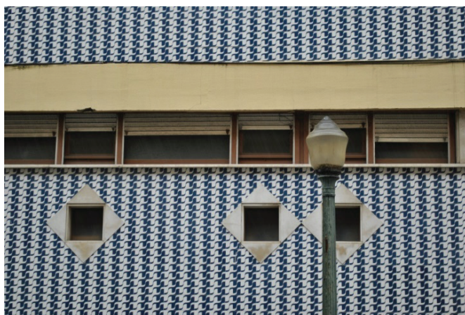
Fig. 232 - Detalhe da fachada do Abrigo Maternal Luísa Canavarro. R. de S. Brás n.º 293, Porto, 1967. Arq. A. Sérgio Menéres e Duílio Silveira.
