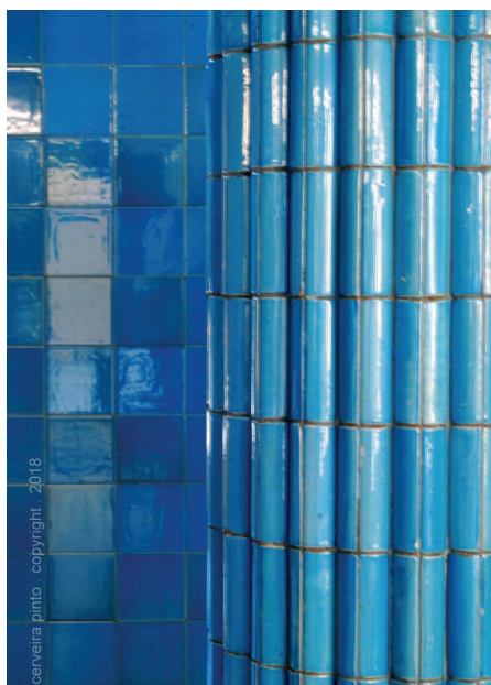
Fig. 240 - Revestimento azulejar de parede e coluna no interior do edifício da Câmara de Matosinhos. Arq. Alcino Soutinho.
