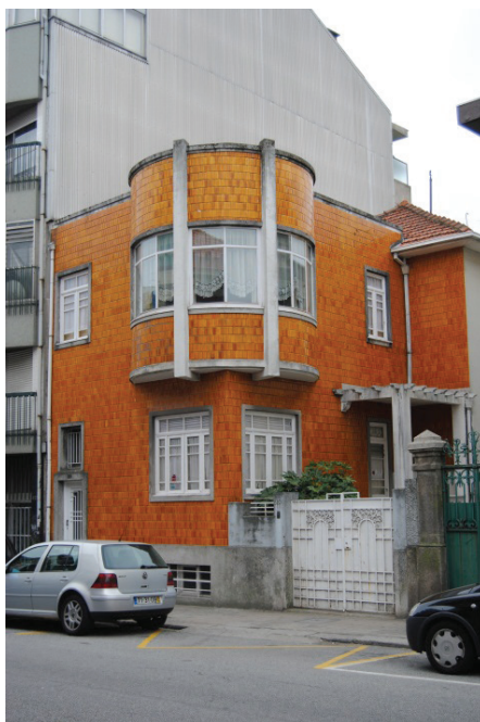
Fig. 125 - Interessante edifício de características Art Déco integralmente revestido com azulejos “de lingote”. Rua de Latino Coelho n.º 329, Porto, 1936.
