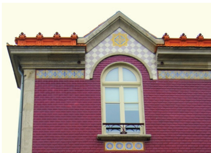
Fig. 140 - Detalhe do edifício na Rua Latino Coelho, sendo possível identificar os vários tipos de material cerâmico que o compõem.
