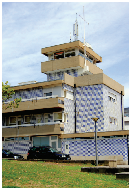
Fig. 227 - Aspecto da Estação de Pilotos do Porto de Leixões, Matosinhos, 1966. Arq. António Sérgio Menéres.
