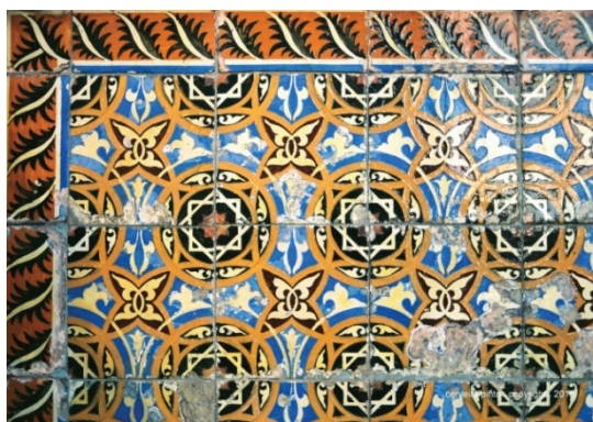
Fig. 296 - Raros azulejos de padrão existentes no edifício da Rua Almeida Costa, em Gaia, com indícios de acentuada degradação (ver fig. 76).
