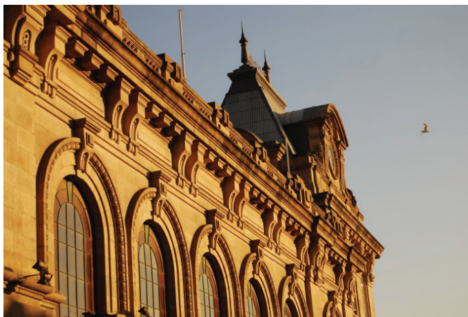
Fig. 115 – Fachada da estação de S. Bento, no Porto (detalhe). Arq. Marques da Silva. Início do Séc. XX.
