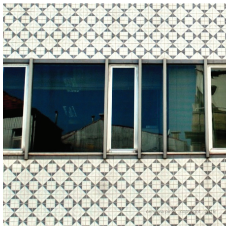
Fig. 230 - Detalhe da fachada do edifício de escritórios na rua Faria Guimarães n.º 345, Porto. Arq. J. Carlos Loureiro.
