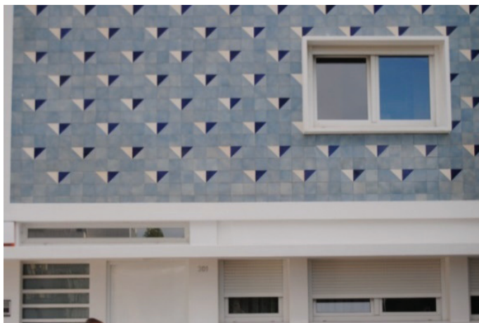
Fig. 183 - Detalhe da superfície azulejada. Fachada norte.
