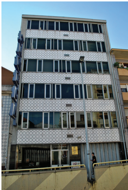
Fig. 229 - Fachada do edifício de escritórios da Rua Faria Guimarães n.º 345, Porto. Arq. J. Carlos Loureiro.
