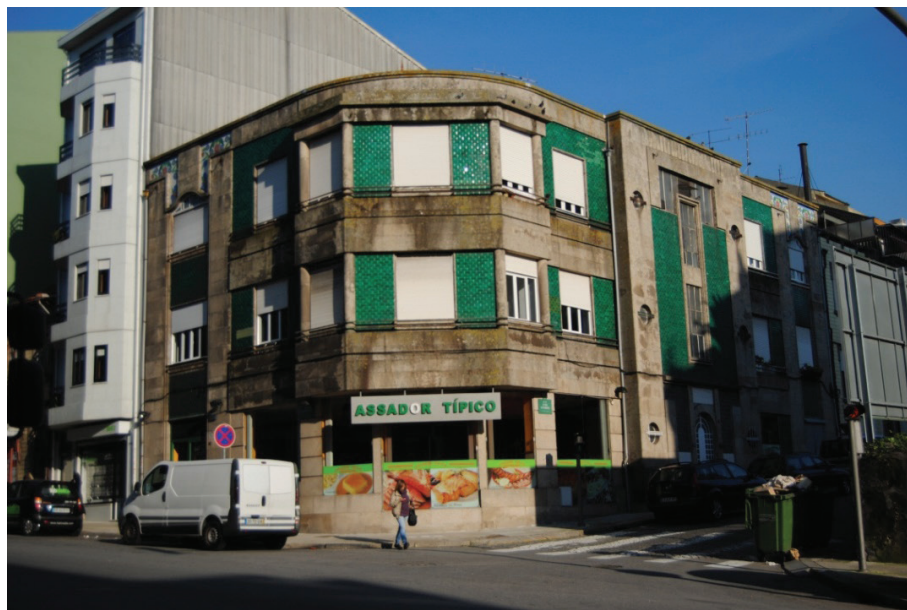
Fig. 158 - Fachadas sul e poente do edifício de gaveto da Av. Fernão de Magalhães com a Rua de Cunha Espinheira, Porto, 1938. Arq. Aucíndio dos Santos.
