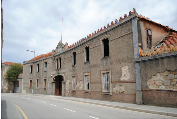
Fig. 105 - Aspecto actual do edifício principal da fábrica “Companhia Cerâmica das Devezas”, em Gaia. Séc. XIX.
