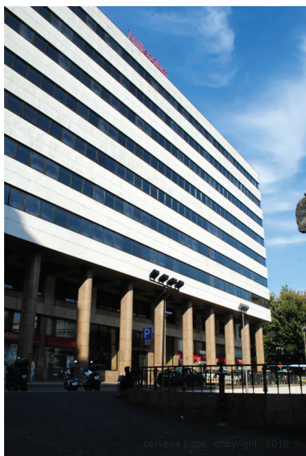
Fig. 121 - Fachada Sul do Palácio Atlântico e respectiva galeria onde se encontram os azulejos de Jorge Barradas. ARS Arquitectos, 1944-1950.
