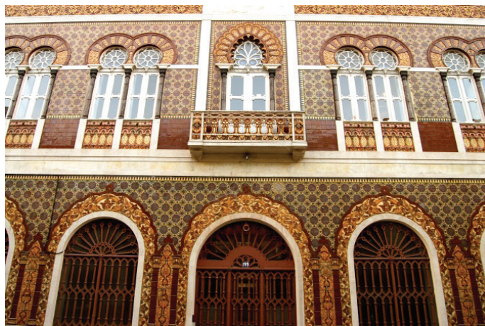
Fig. 36 - Aspecto da fachada do edifício da rua José Falcão, no Porto, que foi armazém e escritório da Fábrica das Devezas, 1901.
