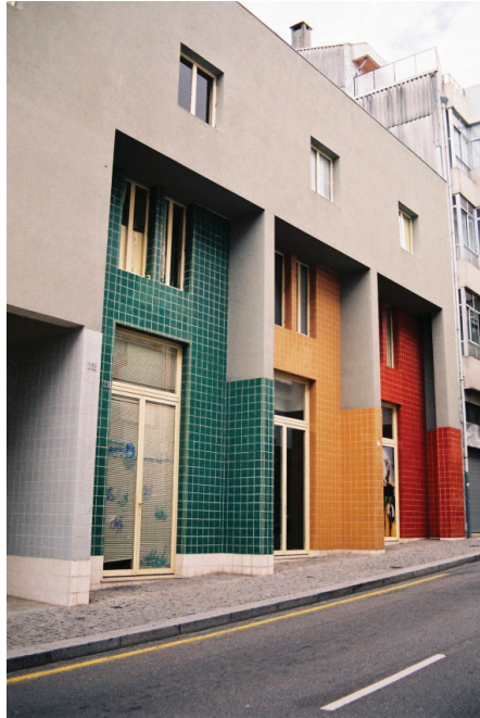
Fig. 262 - Aspecto parcial da fachada voltada para a Rua da Boavista, com o característico revestimento azulejar de cores planas. Boavista, Porto, 2003. Arq. Álvaro Siza Vieira.
