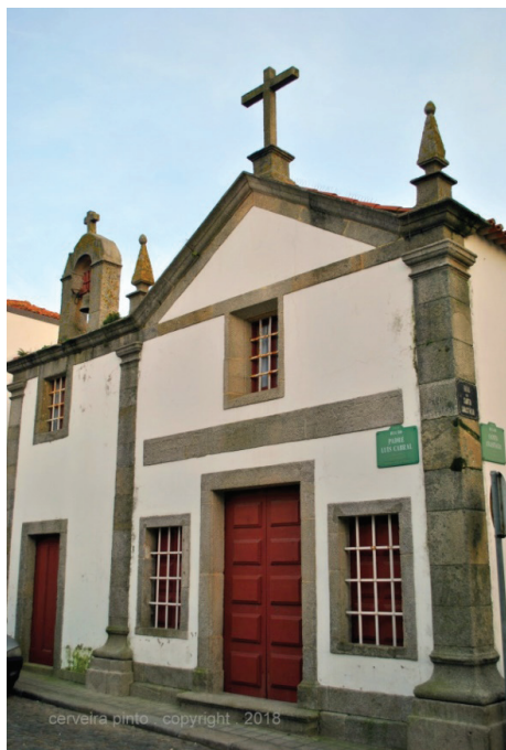
Fig. 66 - Capela de Santa Anastácia na actualidade, já sem o revestimento azulejar.
