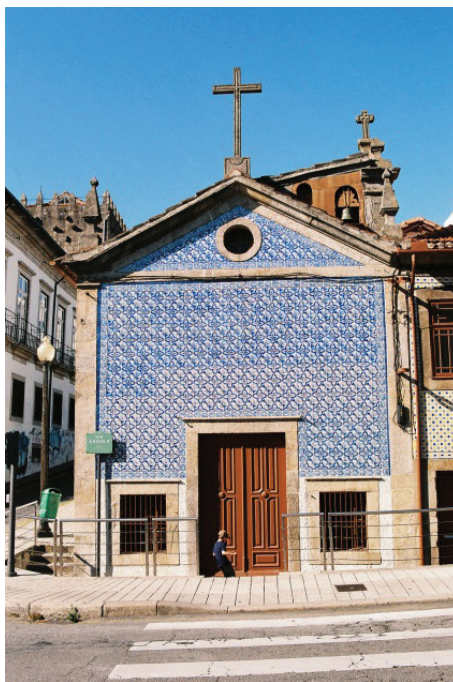
Fig. 67 - Fachada principal da Capela do Senhor da Boa-Nova, totalmente revestida de azulejos de padrão (Séc. XIX).
