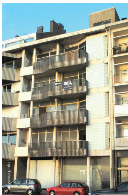
Fig. 223 - Fachada do edifício de habitação e comércio da Avenida Brasil, Porto, 1963. Arq. José Carlos Loureiro.
