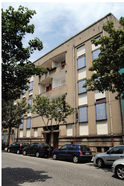
Fig. 134 - Edifício na Rua Ferreira Cardoso, Porto, 1936. Arq. Homero Ferreira Dias.
