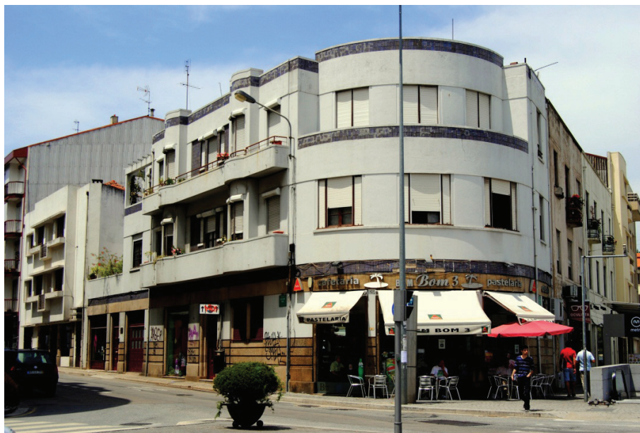
Fig. 156 - Edifício de habitação e comércio no gaveto da rua Fernandes Tomás com o Campo 24 de Agosto, Porto. 1936. Arq. José Ferreira Peneda.
