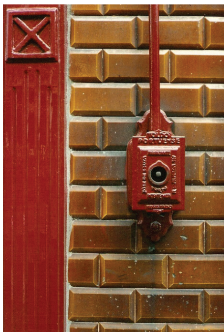
Fig. 45 - Azulejos biselados numa parede de um edifício do Porto, conjugados com elementos de ferro forjado.
