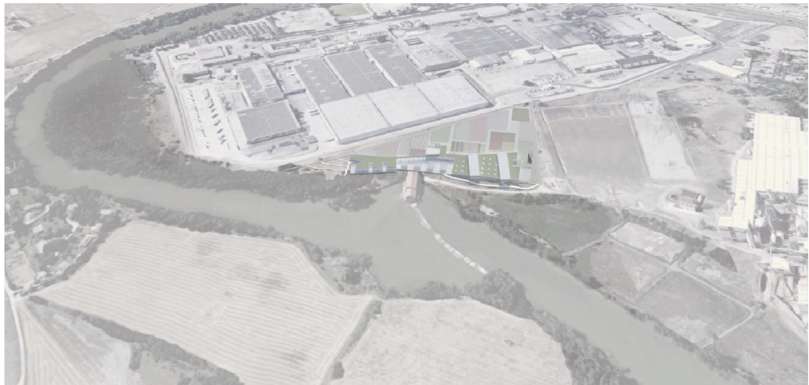
El edificio tiene un carácter dual marcado, en referencia a su CONDICIÓN CAMPO-CIUDAD.
