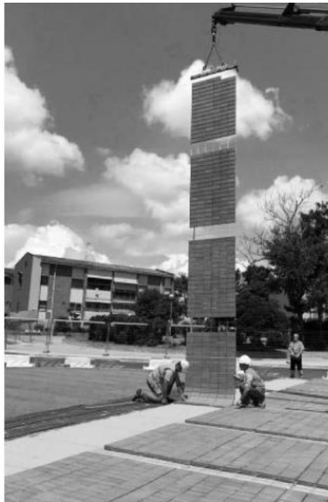
El sistema Flexbrick es rápido de colocar en obra, ya que no hace falta disponer uno a uno los ladrillos de la celosía, y puede llegar a mecanizarse la colocación de una malla de hasta 20
