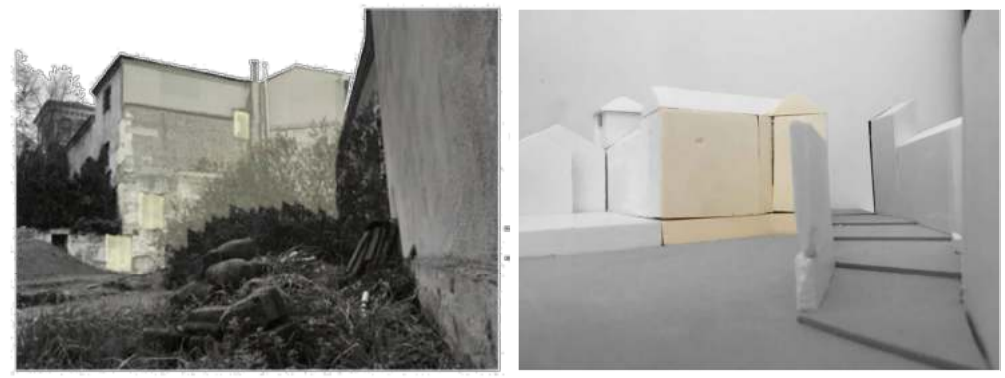
PALACIO FABIO NELLI, LA MEDIANERA DEL PALACIO QUE LINDA CON LA PARCELA SE ENCUENTRA EN MUY MAL ESTADO, ESTÁ FORMADA POR DIFERENTES PARTES, NO ES HOMOGÉNEA, TIENE DIFERENTES APARTEJOS, LABRILLOS, REJÍAS, MUY BIEN EL AMBIENTE DEL LUGAR DONDE EXISTE UNA SUPERPOSICIÓN DE CONSTRUCCIONES MUY DIVERSAS.
