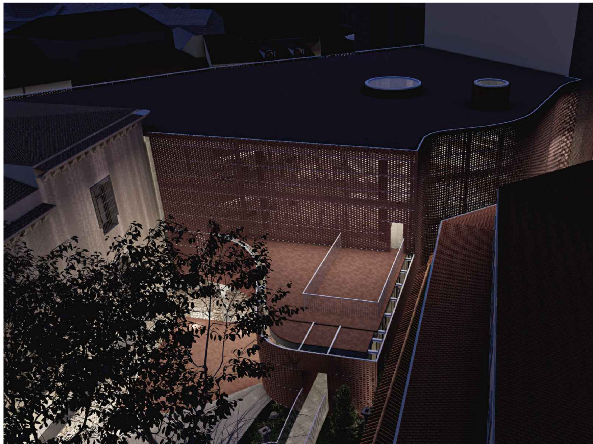
VISTA VERGEL PALACIO FABIO NELLI_RELACIÓN DEL MACIZO CON EL ENTORNO PRÓXIMO
