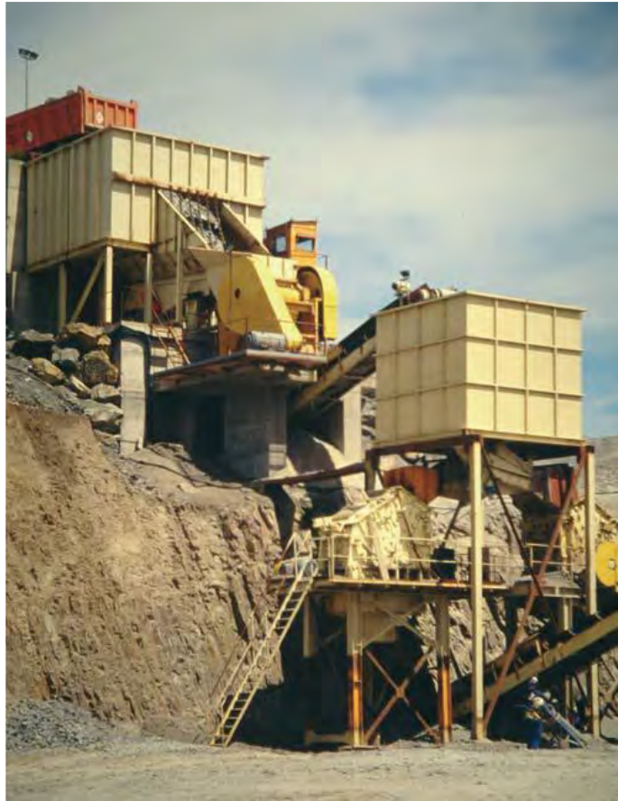
Imagen 7. Esquema de planta de tratamiento con trituración primaria
