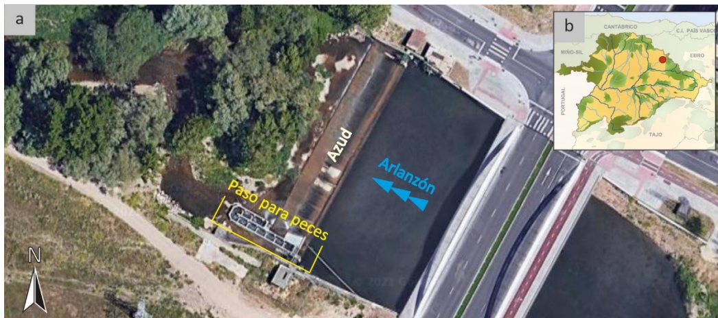
Figura A.3.1. Ubicación del paso para peces en el río Arlanzón (a) (fuente: Google Maps) y en la cuenca hidrográfica del Duero (b).
