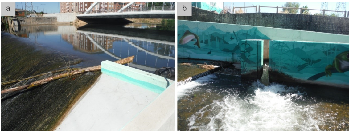
Figura A.3.3. Rebaje en el azud para la llamada (a) y la base del obstáculo junto a la entrada de peces (b).
