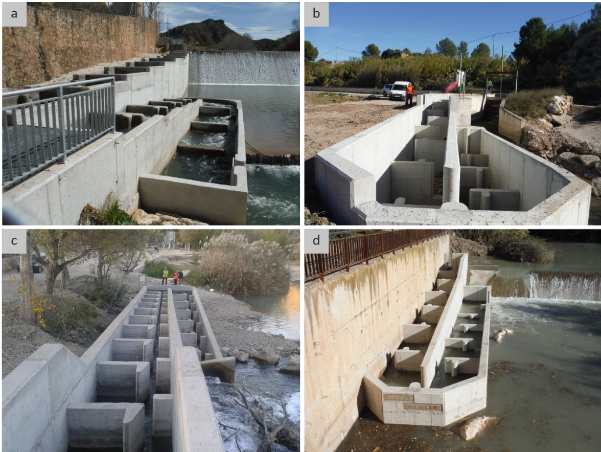
Figura 15. Escalas de estanques sucesivos visitadas en la cuenca del Segura: Cañaverosa (a), El Esparragal (b), El Jarral (c) y Elevación Postrasvase (d).
