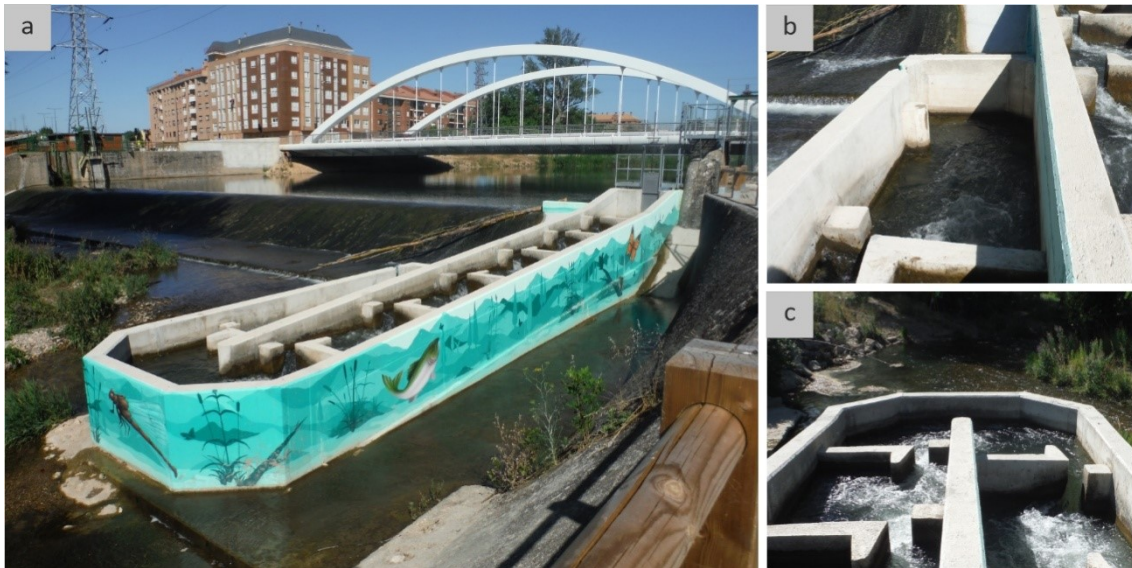
Figura A.3.2. Escala evaluada (a) y sus estanques singulares: el inferior (b) y uno en curva que es el tercero desde aguas abajo (c).
