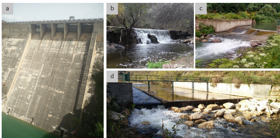
Figura 1. Algunos de los obstáculos más habituales en los ríos: presas (a), azudes (b), y obras descalzadas como las estaciones de aforo tipo V-flat (c) o de canal (d).
