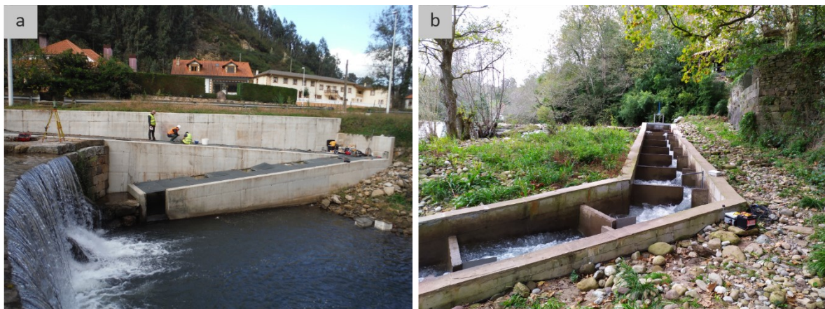
Figura 17. Escalas de estanques sucesivos estudiadas en el río Miera: Revolve (a) y El Arral (b).
