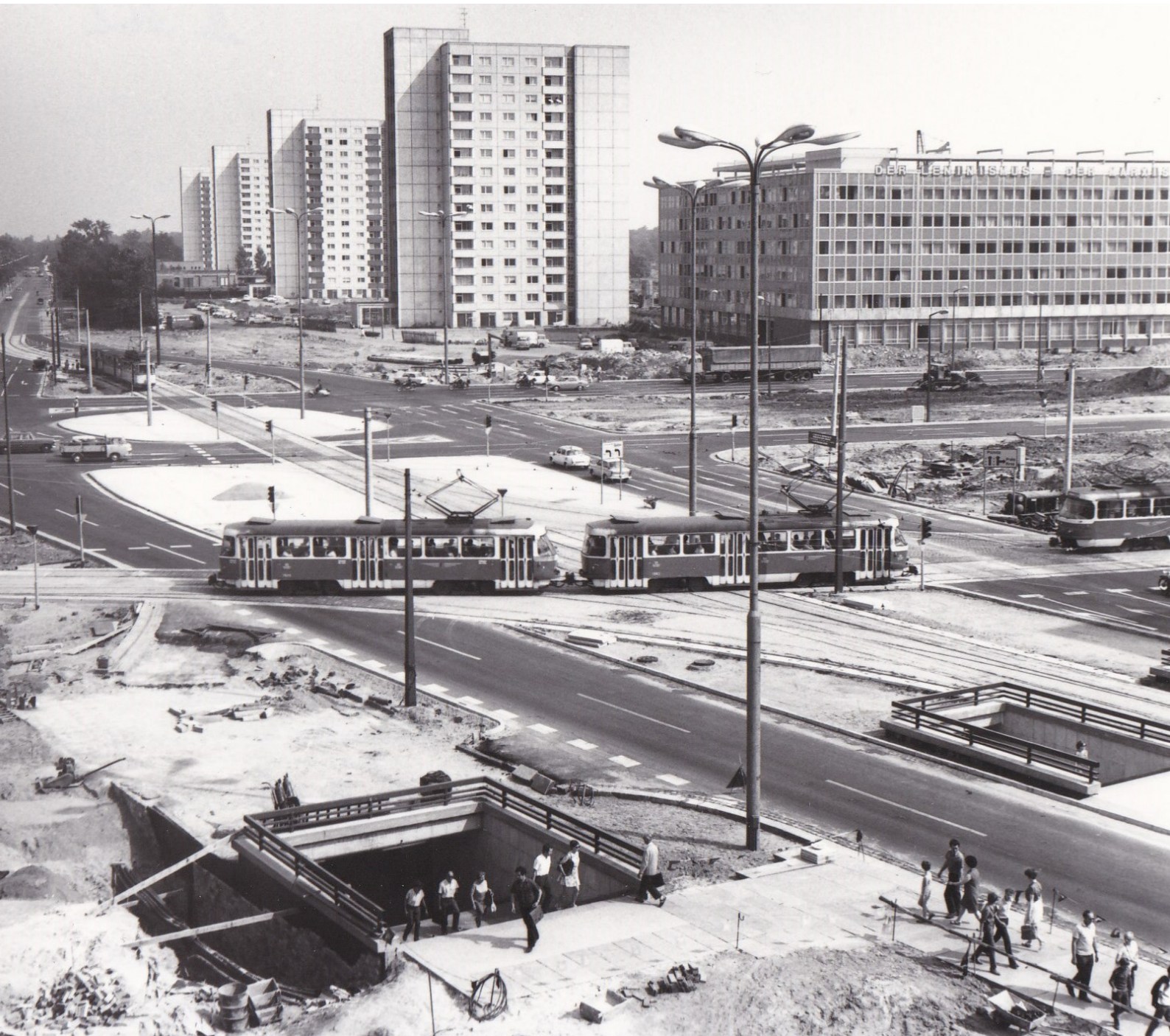
The construction of pedestrian tunnels in Pirnaischer Platz, Dresden, 1971. Source: Dresden Stadtmuseum, SMD_Ph 795_05_Pirnaischer Platz_August.
