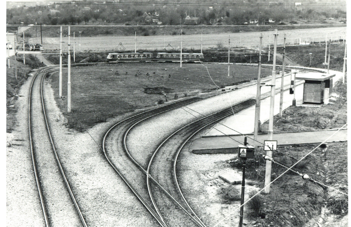
Fig. 207. La estación técnica de final de línea y su bucle, perteneciente al tranvía rápido de Bohunice en 1985. Fuente: Archivo Municipal de Brno, AMB-U5-XXIa57-01. Se puede apreciar el gran espacio consumido por el bucle tranviario, estrictamente necesario para los tranvías con una sola cabina. La existencia de tranvías con doble cabina en los países comunistas de aquel periodo fue limitada, de modo que los bucles fueron frecuentes.
