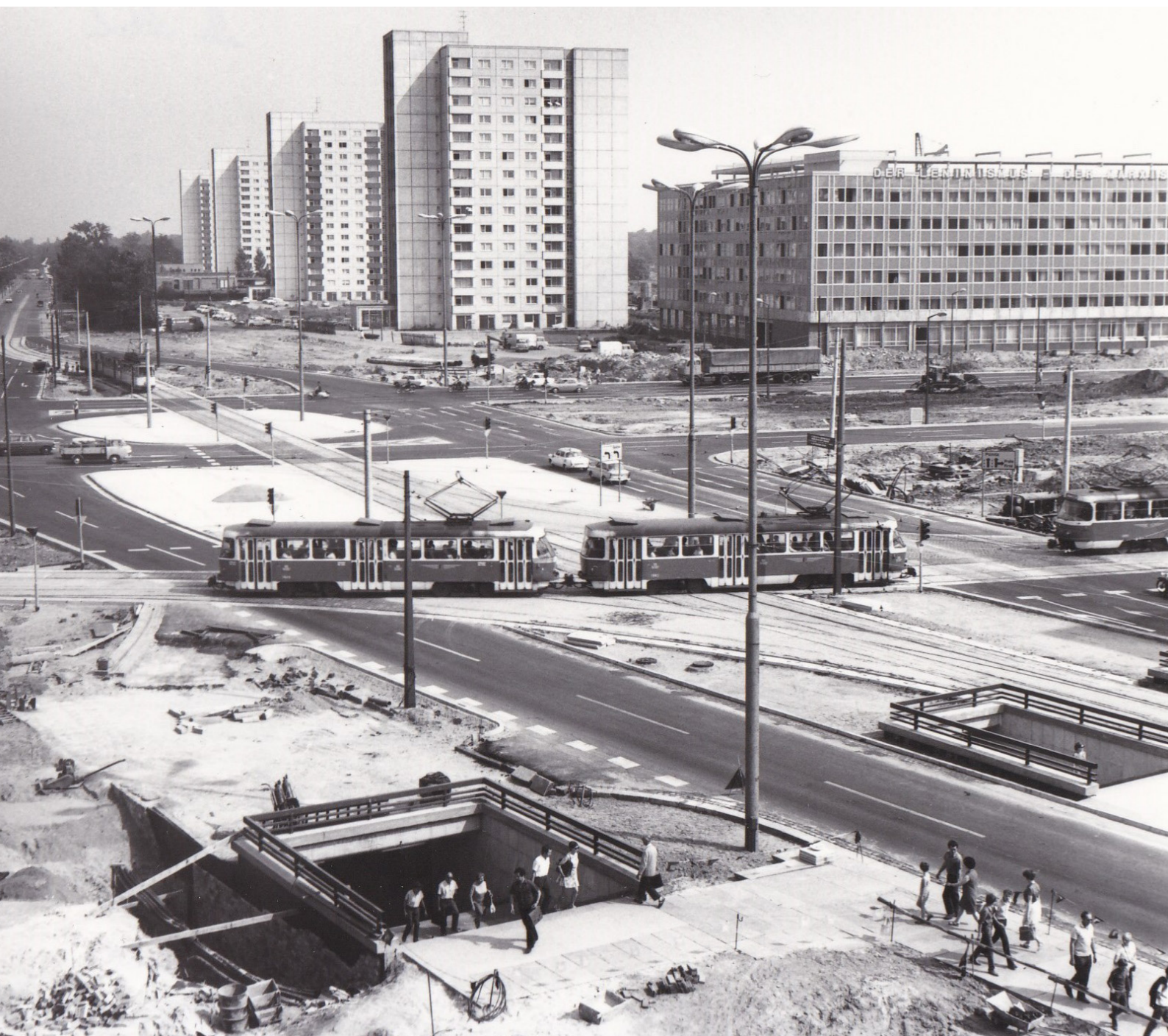
La construcción de tuneles peatonales en Pirnaischer Platz, Dresde, 1971. Fuente: Dresden Stadtmuseum, SMD_Ph 795_05_Pirnaischer Platz_August.
