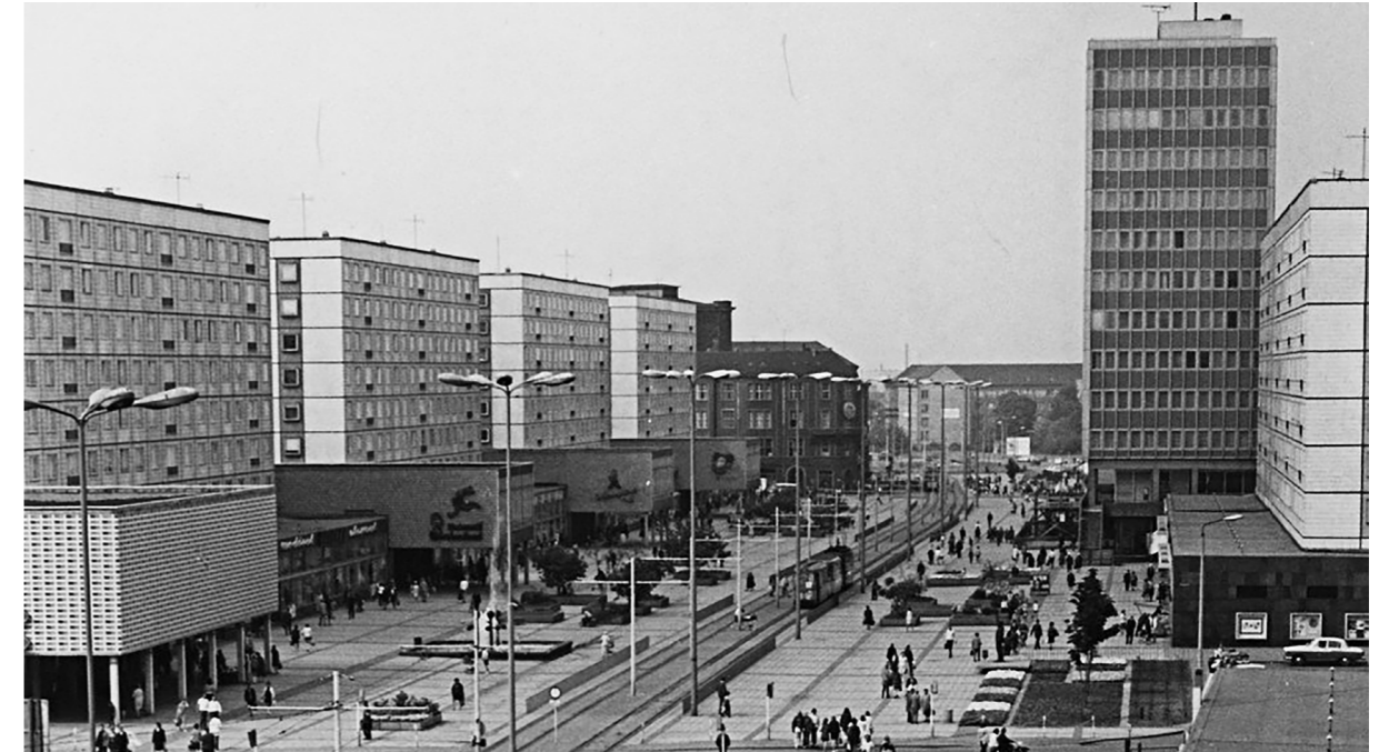
Fig. 68. Tranvías en Karl Marx Strasse, la avenida central de Magdeburgo con el tráfico peatonal y tranviario en 1968. Fuente: Archivo Federal de Alemania, 183-GO613-0008-001, foto de U. Richter.
