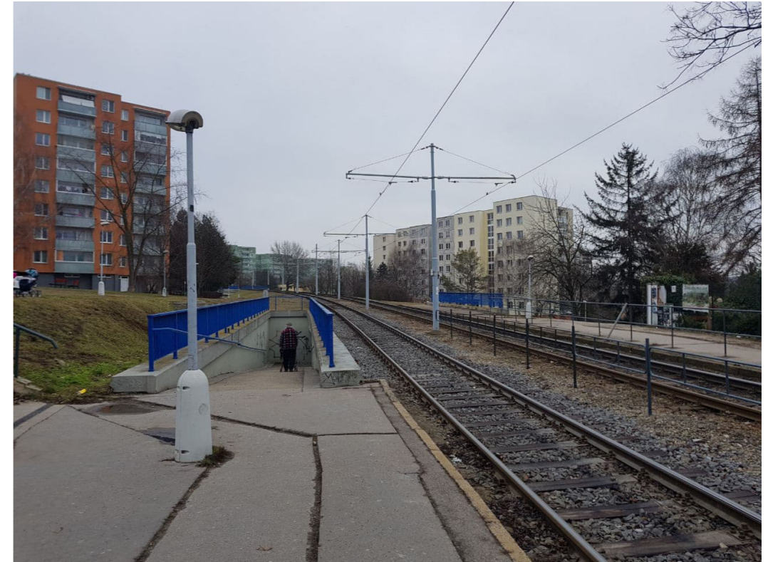
Fig. 226. Paso peatonal a nivel organizado posteriormente, por la incomodidad del paso subterráneo, en la parada tranviaria de Dunajská, área residencial de Bohunice. Fuente: foto de la autora, 2020. Se puede ver también un leve cambio de nivel entre la parada tranviaria y el espacio residencial.
