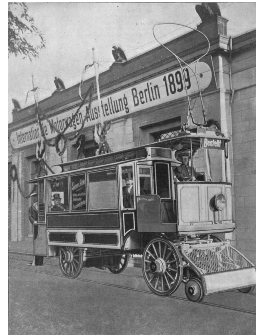
Fig. 2. Pruebas de Siemens y Halske en 1899: un tranvía eléctrico con su posibilidad de funcionamiento como ómnibus con batería por las calles. Fuente: Sin autor(a), (1900) A Combined Automobile and Tramway Omnibus , Scientific American , 82 (16), p. 24.
