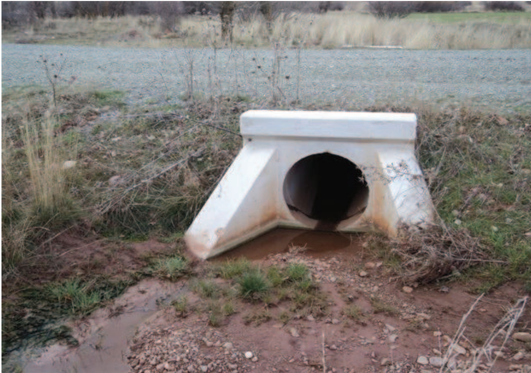
FOTO Nº 30. Marco Prefabricado hormigón 2x1 m.
