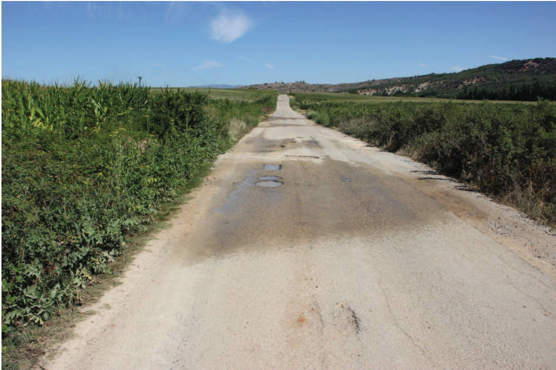
FOTO nº 7. Pk 1,200 hacia delante San Andrés. Tramo que se echó M.B.C. hace 2 años y se ve que está deteriorado.
