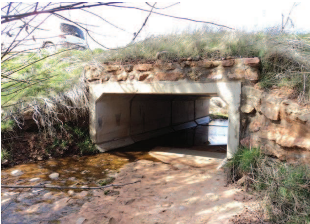
FOTO Nº 30. Marco Prefabricado hormigón 2x1 m.
