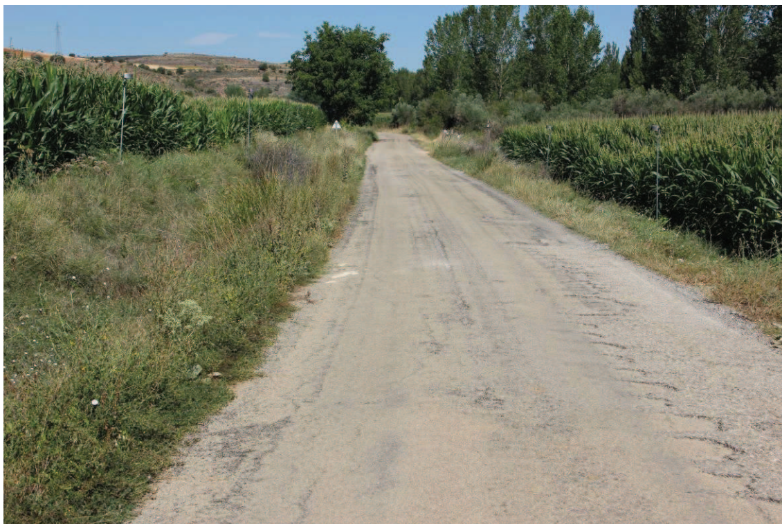
FOTO Nº 11. Pk 2,700 hacia atrás. Cunetas con mucha vegetación arbórea, sobre todo chopo.
