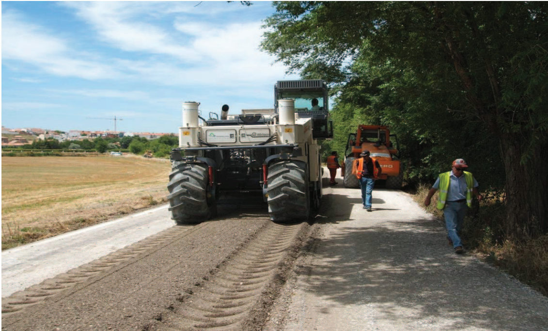
FOTO Nº 32. Motoniveladora extendiendo material reciclado.
