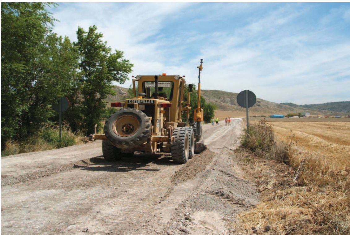
FOTO Nº 32. Motoniveladora extendiendo material reciclado.
