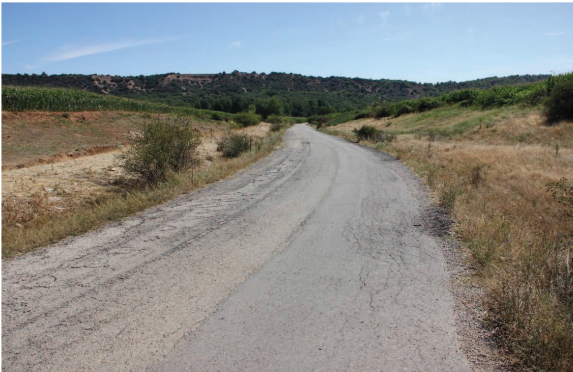
FOTO nº 7. Pk 1,200 hacia delante San Andrés. Tramo que se echó M.B.C. hace 2 años y se ve que está deteriorado.
