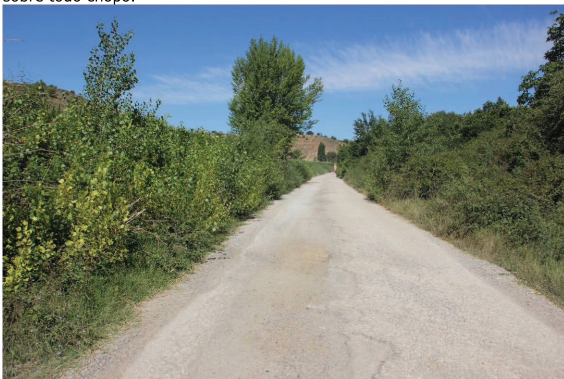
FOTO Nº 11. Pk 2,700 hacia atrás. Cunetas con mucha vegetación arbórea, sobre todo chopo.
