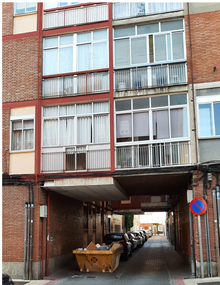
Figura 5. Aislamiento térmico de suelos por el exterior.
