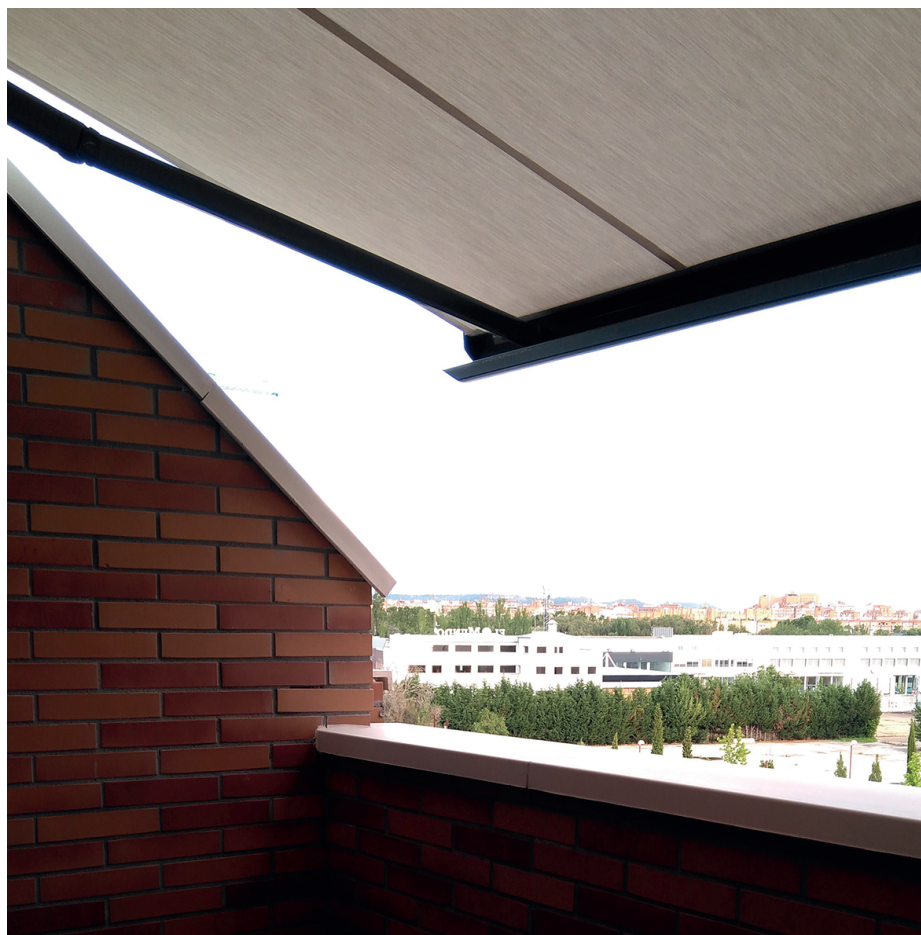
Figura 2. Efecto de toldos instalados en vivienda.
