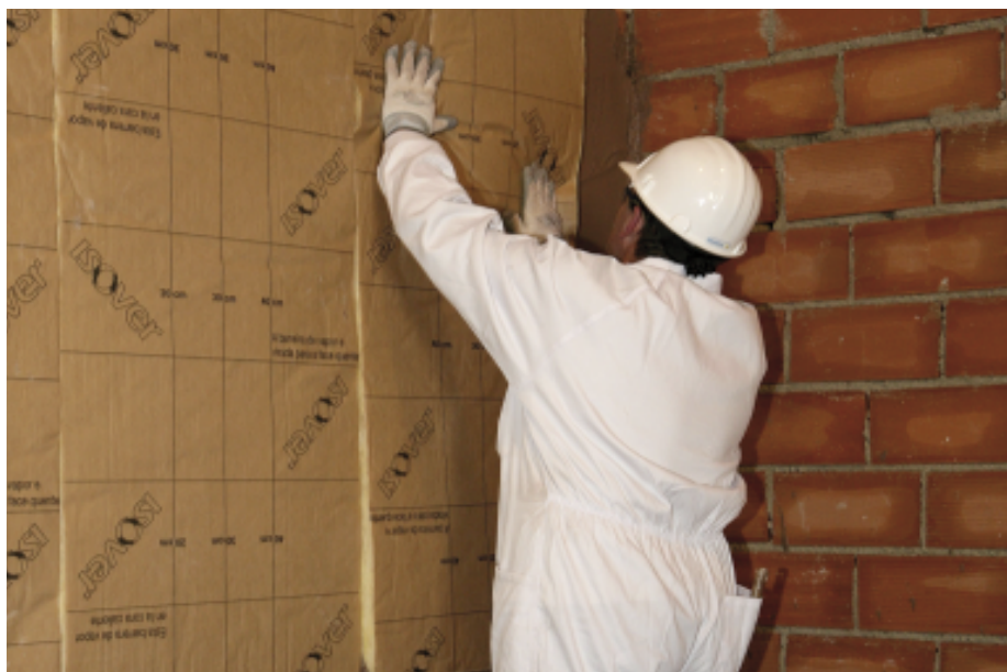
Figura 5. Panel semirrígido de Lana de Vidrio ISOVER, no hidrófilo, revestido por una de sus caras con papel kraft que actúa como barrera de vapor (fuente de imagen: ISOVER).
