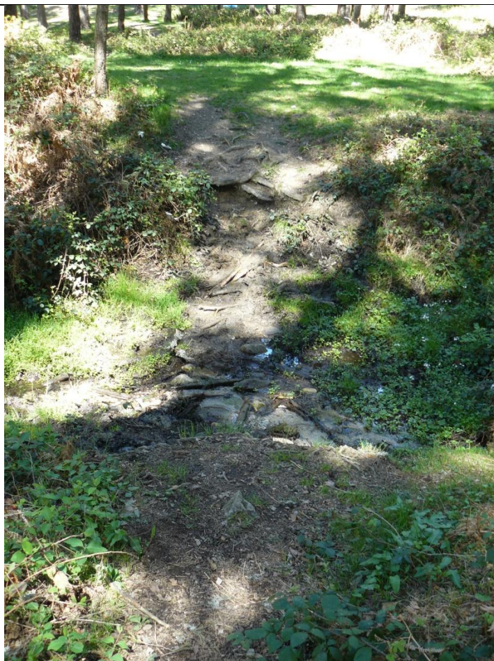
Cruce de la senda peatonal con el Arroyo de Camalalieber, donde se proyecta la instalación de una pasarela de madera.
