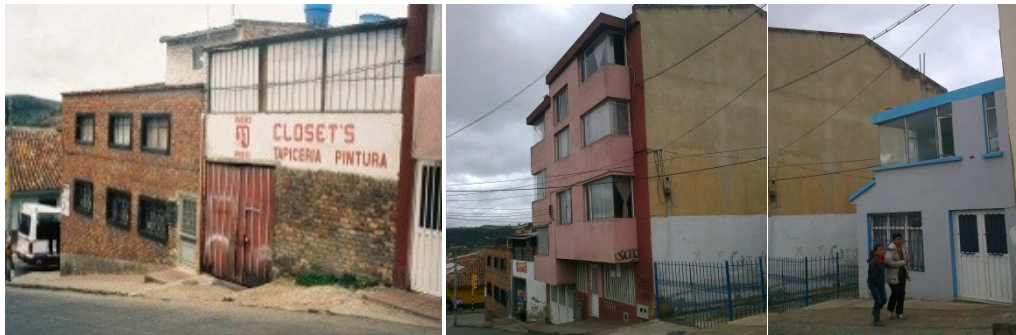
Foto n°91 perfil sobre la calle 17 entre carreras 9 y 8, manzana 1, elaboración propia 2008.
