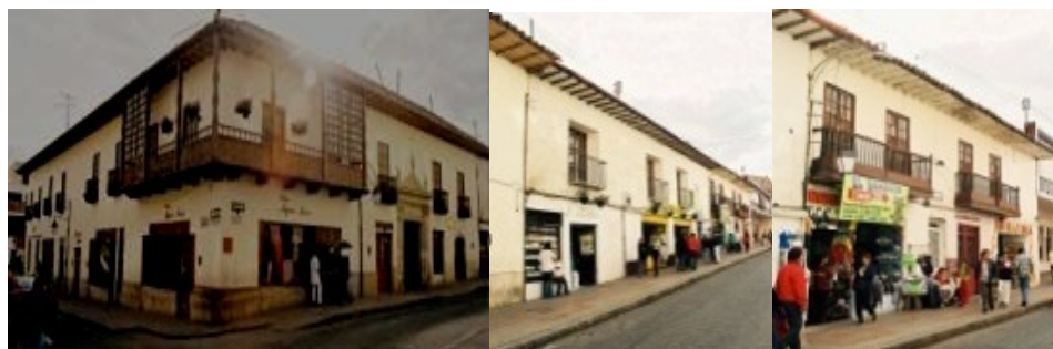
Foto n° 27 Perfil calle 19 entre carrera 11 y 12, manzana 18. Elaboración propia, 2008.
