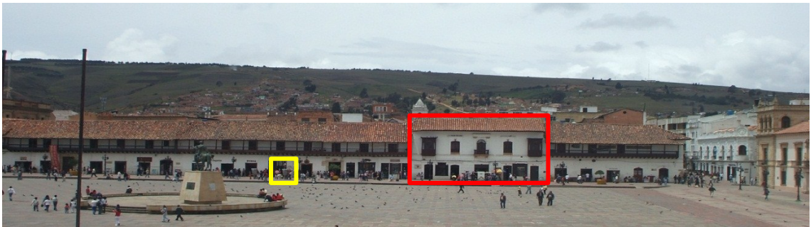
Foto 16. Fachada sobre la carrera 10 entre calles 19 y 20, manzana 14. Elaborado foto propia, 2006.
