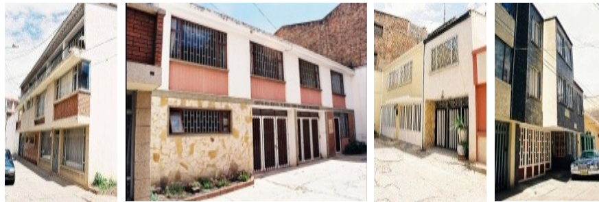
Foto nº 34 permeabilidad al interior de la manzana 8 sobre la calle 18, elaboración propia, 2008
