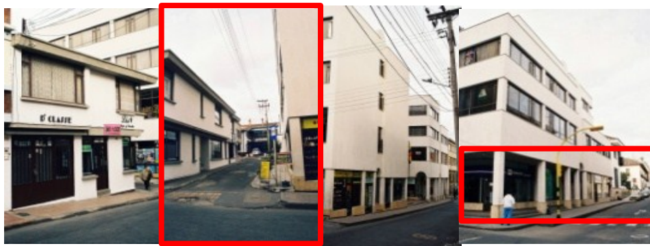
Foto nº 32 Perfil esquinera perfil calle 18 entre carrera 12 y 11, manzana 18. Elaboración propia, 2008
