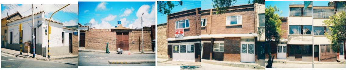
Foto n°75 perfil sobre la calle 25 entre carreras 9 y 10, manzana 125, elaboración propia, 2008
