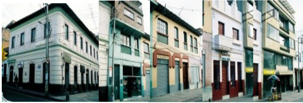
Foto n°57 perfil sobre la calle 20 entre carreras 12 y13, manzana 22, elaboración propia, 2008.
