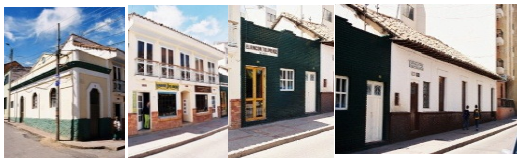
Foto nº108 perfil sobre la carrera 10 entre calles 16 y 15, manzana 151, elaboración propia 2008.
