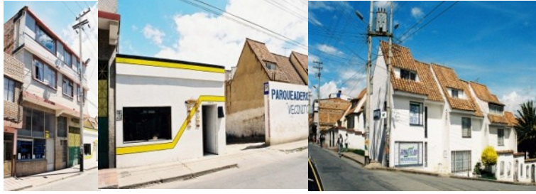
Foto nº113 perfil sobre la carrera 11 entre calles 16 y 15, manzana 151, elaboración propia 2008.
