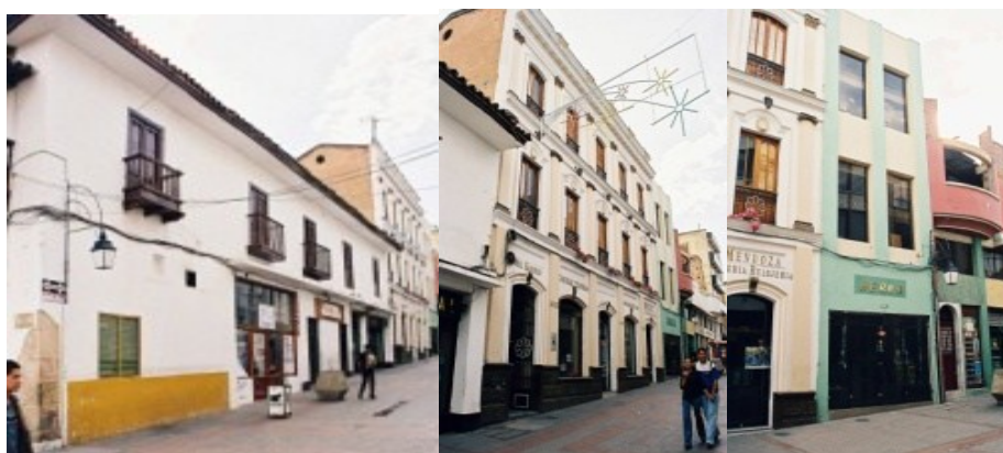
Foto n° 24 Perfil sobre la calle 20 entre carreras 10 y 11, manzana 14. Elaboración propia, 2008
