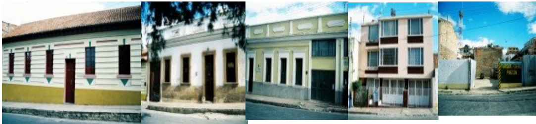
Foto n°70 perfil sobre la calle 23 entre carrera 8 y 9, manzana 93, elaboración propia, 2008
