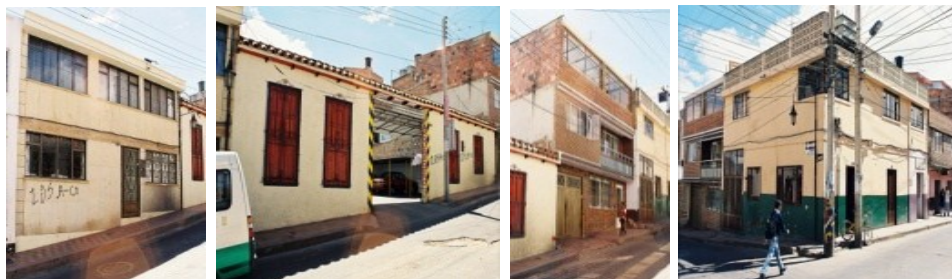
Foto n°111 perfil sobre la calle 16 entre carreras 11 y 10, manzana 151, elaboración propia 2008.
