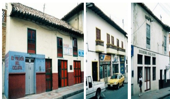
Foto n°62 perfil sobre la calle 19 entre carreras 12 y 13, manzana 22, elaboración propia, 2008.
