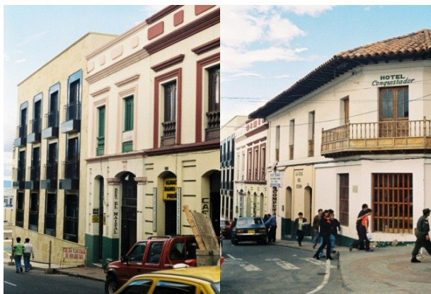
Foto nº46 perfil sobre la carrera 9 entre calles 20 y21, manzana 5, elaboración propia, 2008.
