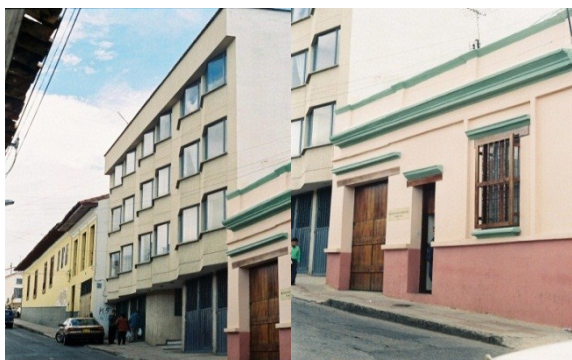
Foto nº50 perfil sobre la carrera 8 entre calle 20 y21, manzana 5, elaboración propia, 2008
