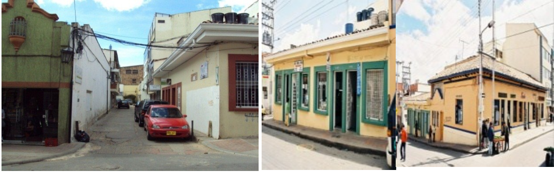
Foto n°39 perfil sobre la calle 18 entre carreras 9 y 10, manzana 8, elaboración propia, 2008
