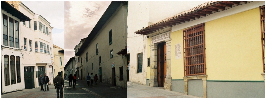
Foto n°48 perfil sobre la calle 20 entre carreras 9 y 8, manzana 5, elaboración propia, 2008
