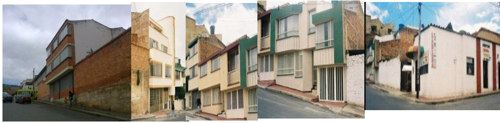
Foto n°88 perfil sobre la calle 16, entre carrera 9 y 8, manzana 1, elaboración propia 2008.
