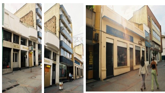
Foto n° 25. Perfil sobre la calle 20 entre carreras 10 y 11, manzana 14. Elaboración propia, 2008
