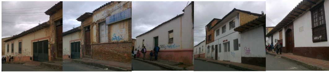
Foto n°92 perfil sobre la calle 17 entre carreras 9 y 8, manzana 1, elaboración propia 2013.
