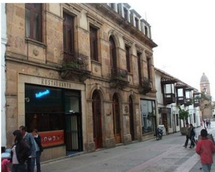
FOTO 17. PREDIO CON ALTERACIONES EN PRIMER PISO
