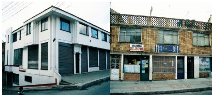
Foto n°61 perfil sobre la calle 19 entre carreras 12 y 13, manzana 22, elaboración propia, 2008.
