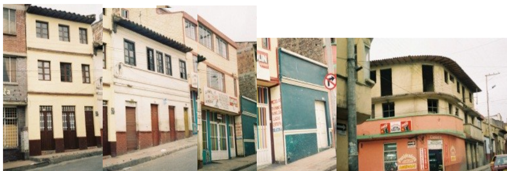
Foto n°94 perfil sobre la calle 19 entre carreras 13 y14, manzana 24, elaboración propia 2008.
