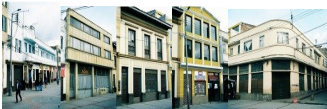
Foto n°58 perfil sobre la calle 20 entre carreras 12 y13, manzana 22, elaboración propia, 2008
