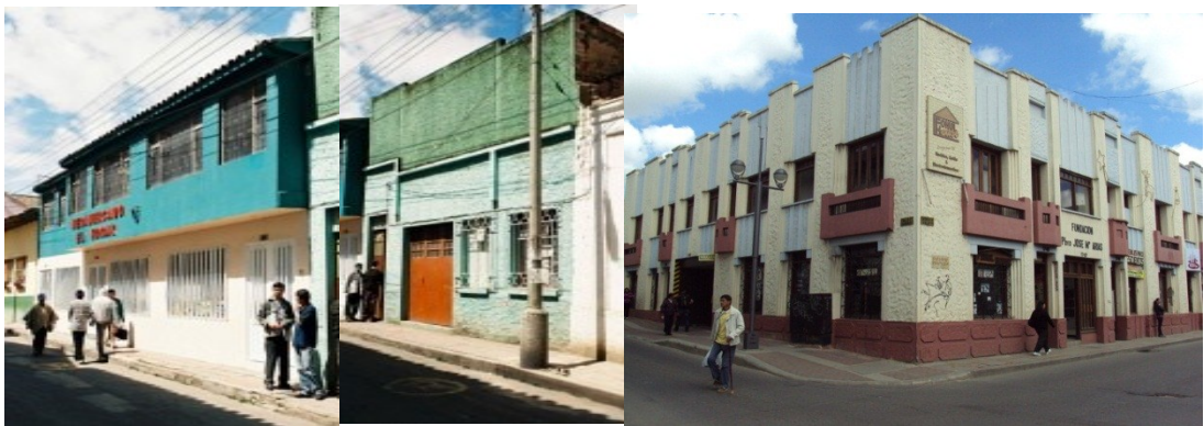
Foto n°43 perfil sobre la calle 17 entre carrera 10 y 9, manzana 8, elaboración propia, 2008
