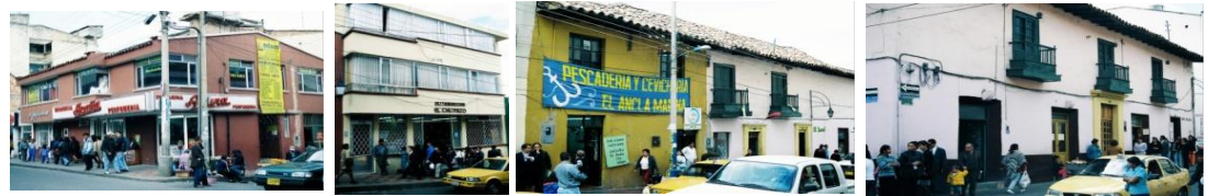
FACHADA POR LA CALLE 17 ENTRE CARRERA 11 Y 10
