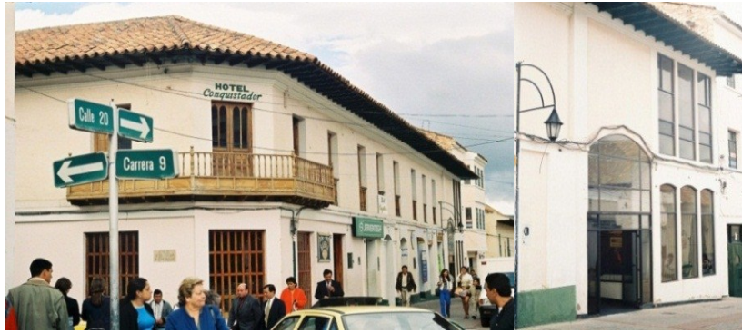
Foto n°47 perfil sobre la calle 20 entre carreras 9 y 8, manzana 5, elaboración propia, 2008
