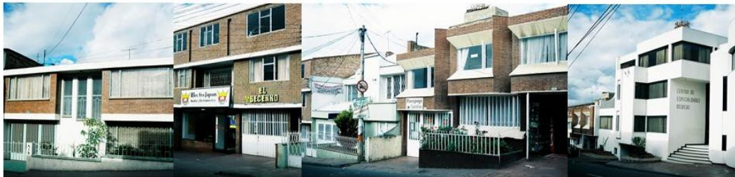
Foto nº65 perfil sobre la carrera 9 entre calle 23 y 22, manzana 93, elaboración propia, 2008
