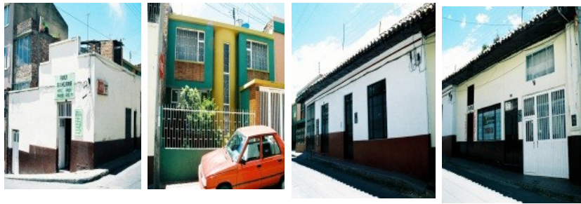
Foto n°71 perfil sobre la calle 24 entre carrera 9y10, manzana 125, elaboración propia, 2008
