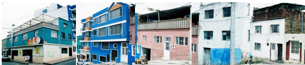
Foto n°101 perfil sobre la calle 16 entre carrera 12 y 11, manzana 178, elaboración propia 2008.
