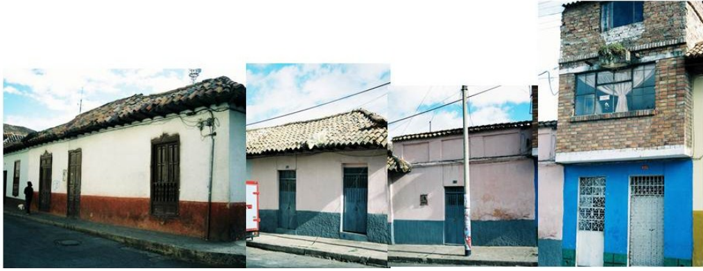
Foto n°69 perfil sobre la calle 23 entre carrera 8 y 9, manzana 93, elaboración propia, 2008
