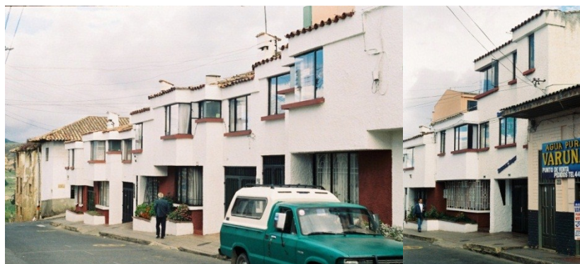
Foto n°52 perfil sobre la calle 21 entre carreras 8 y 9, manzana 5, elaboración propia, 2008
