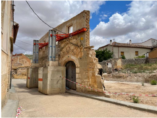
Ilustración 35. Fachada de la Casa del Cordón de Valdecañas (Palencia). Fotografía propia, 25 de junio de 2022.
