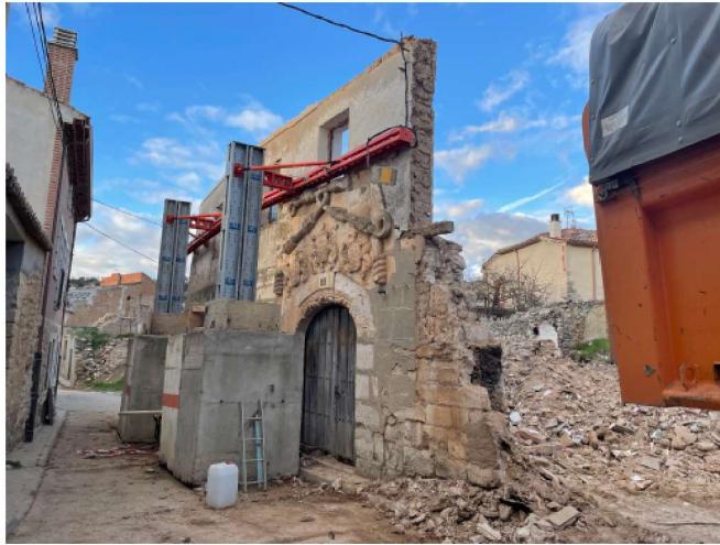
Ilustración 33. Demolición de la fachada de la Casa del Cordón de Valdecañas (Palencia). Fotografía propia, 10 de marzo de 2022.
