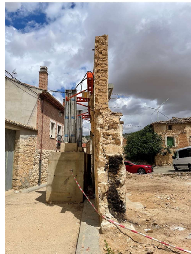
Ilustración 9. Espesor del muro de la Casa del Cordón de Valdecañas de Cerrato. Fotografía propia, 25 de junio de 2022.
