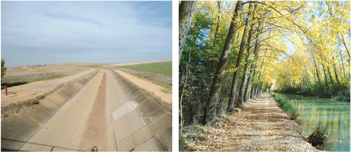
Figura 3. Oposición gráfica entre el duro canal Cea-Carrión (Villacarralón) y el canal de Castilla (Tamariz de Campos), paradigma de integración paisajística de una infraestructura.
