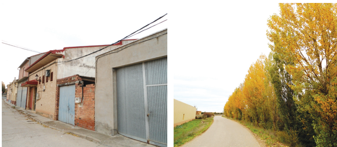
Figura 5. Imágenes enfrentadas características de espacios periurbanos en Villalón de Campos: degradación urbanística a la izquierda; integración y presencia de zonas verdes a la derecha.
