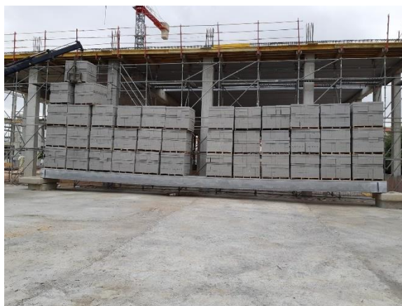
Figura 2. Prueba de carga estática in situ de una viga en una obra [4]
