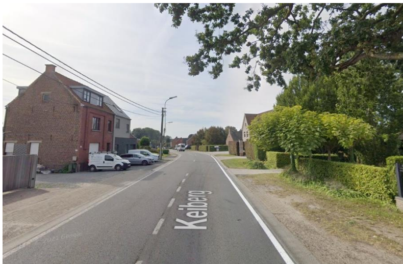
Figura 63: Desarrollo en cinta en torno a la carretera nacional N-462 con viviendas adosadas de principios del siglo XX (izquierda) y viviendas con jardín más recientes (derecha)
