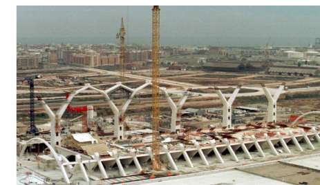
Fig. 118. Construcción del Museu Príncipe Felipe
