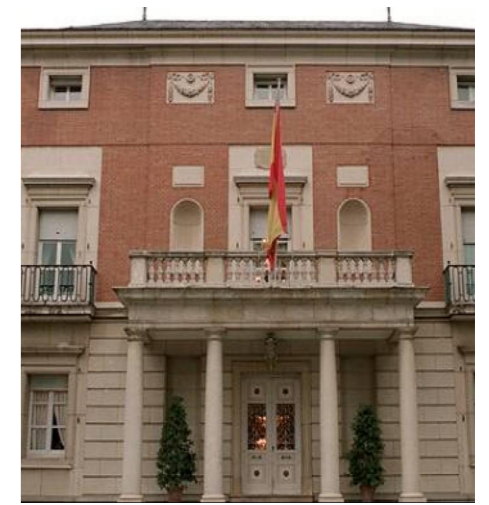
Fig. 94. Detalle de la fachada principal
