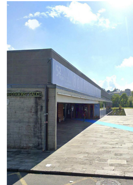
Fig. 240. Vista de la entrada al edificio
