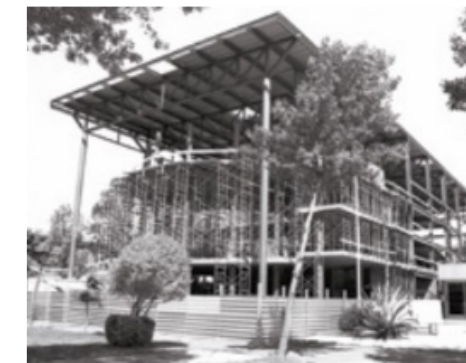
Fig. 246. Construcción del edificio
