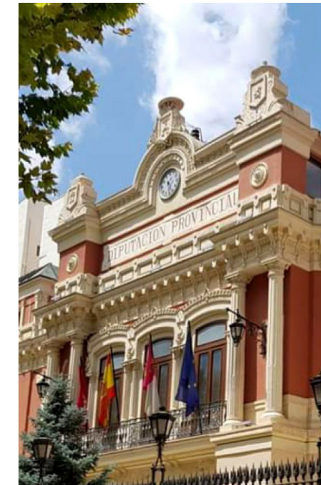
Fig. 76. Detalle del reloj y escudo de la fachada
