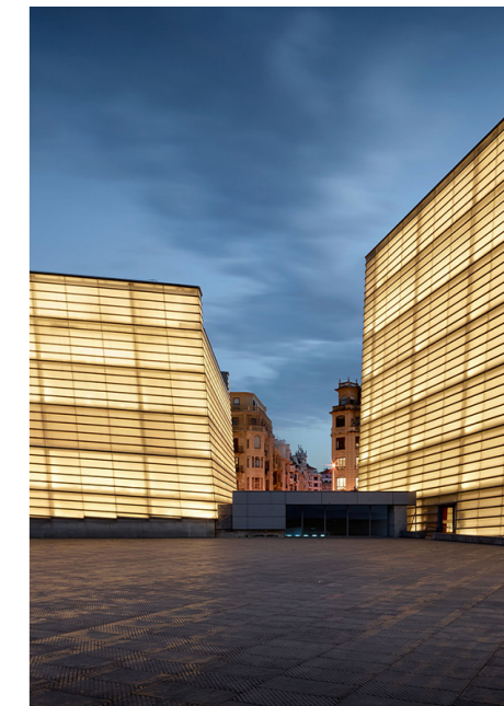
Fig. 209. Vista de la entrada al edificio
