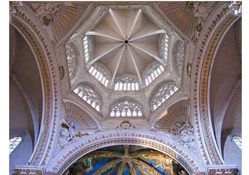
Fig. 157. Vista del cimborrio desde el interior
