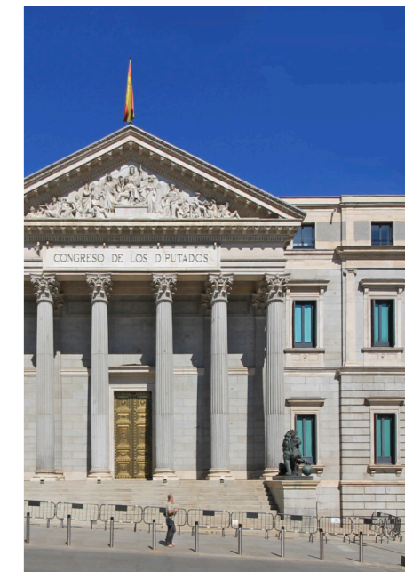
Fig. 53. Fachada principal del edificio
