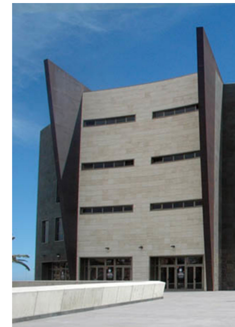
Fig. 234. Vista de la entrada al edificio
