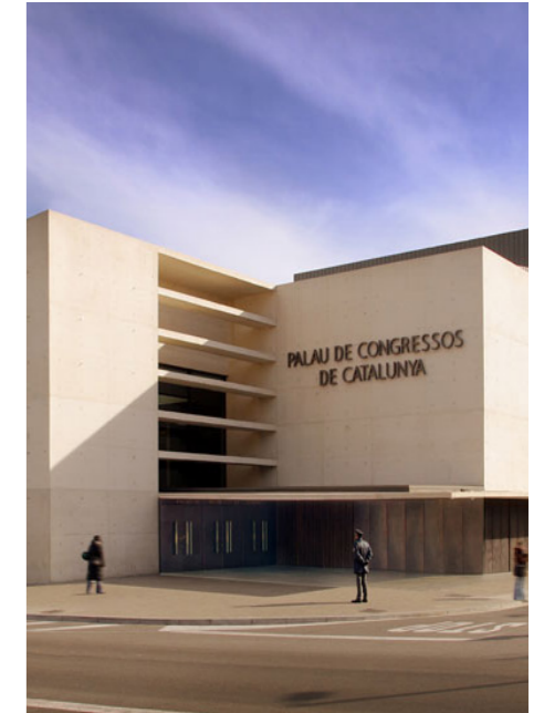
Fig. 215. Vista de la entrada al edificio
