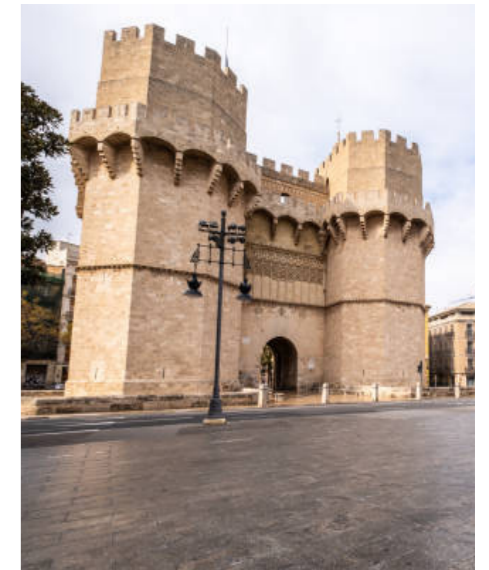
Fig. 311. Vista exterior del edificio
