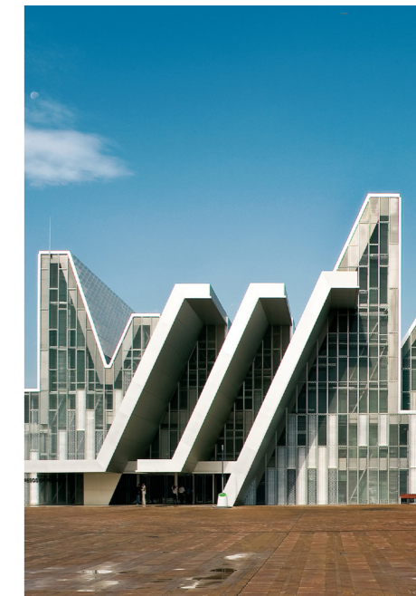
Fig. 258. Vista del distribuidor
