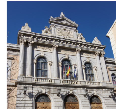
Fig. 88. Detalle de la fachada principal
