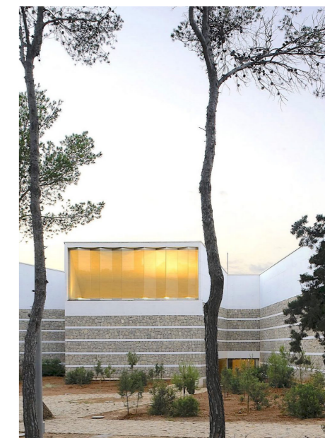
Fig. 222. Vista de la entrada al edificio
