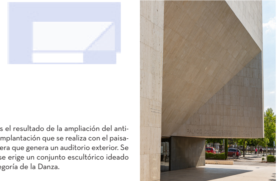
Fig. 228. Vista de la entrada al edificio
