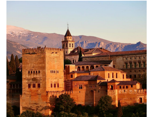
Fig. 296. Vista desde el exterior del conjunto
