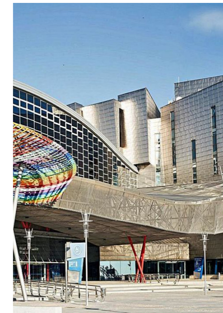
Fig. 200. Vista de la entrada al edificio
