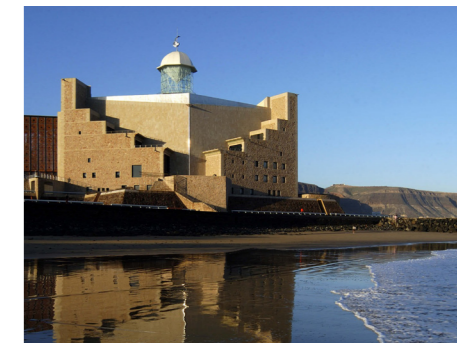
Fig. 181. Vista exterior del edificio
