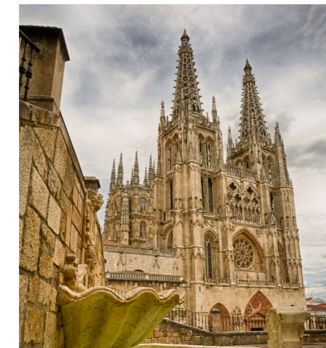
Fig. 137. Vista exterior del edificio
