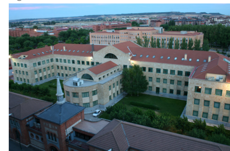
Fig. 107. Vista trasera del edificio actual
