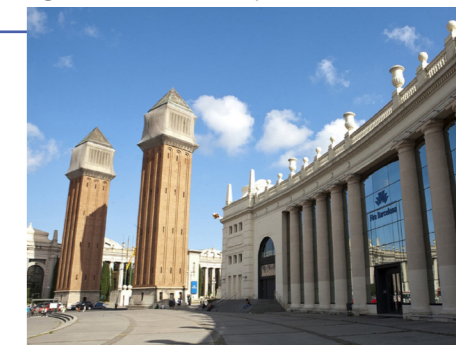
Fig. 189. Pabellones de Fira Barcelona
