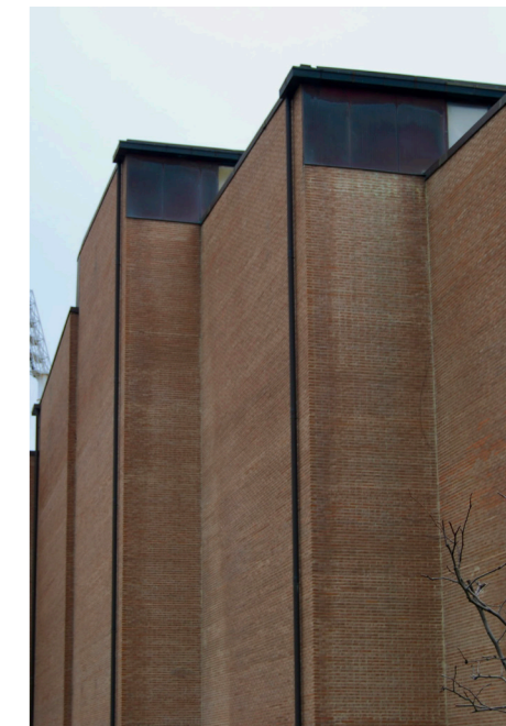
Fig. 281. Vista exterior del edificio
