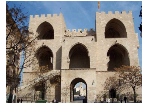
Fig. 312. Vista trasera de las torres
