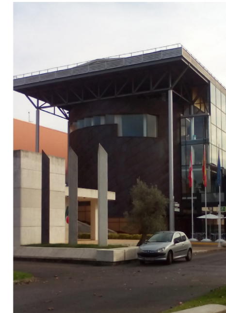
Fig. 245. Vista de la entrada al edificio
