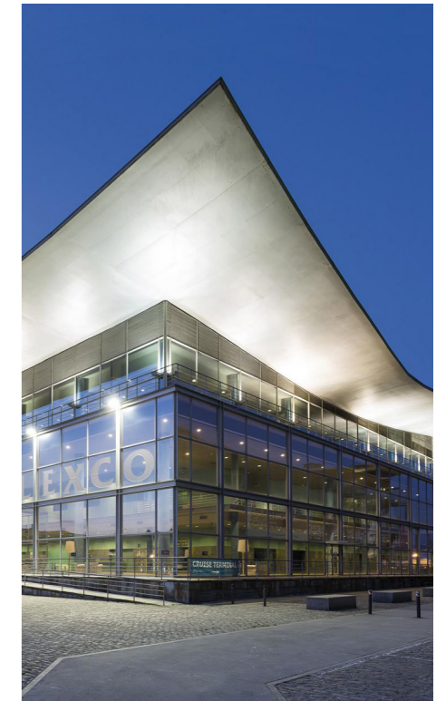
Fig. 287. Vista exterior del edificio
