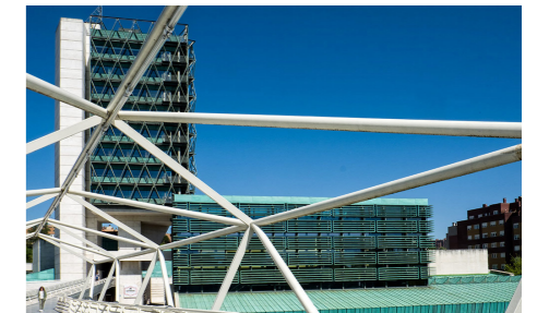
Fig. 168. Vista exterior desde la pasarela
