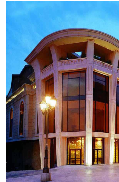
Fig. 263. Vista del distribuidor
