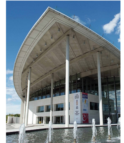
Fig. 250. Vista de la entrada al edificio
