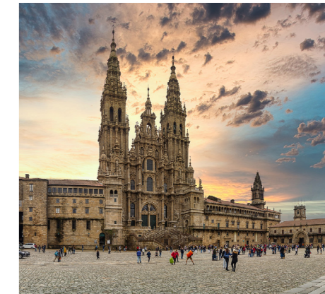
Fig. 59. Vista de la fachada principal del edificio
