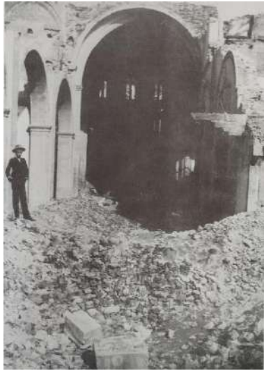
FIGURA 35: Derribo de la iglesia del convento de San Francisco. Casaprima, A. (1996.). El campo de los hombres buenos.
