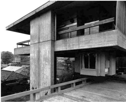
Fig. 93. Módulos dormitorio suspendidos del forjado
