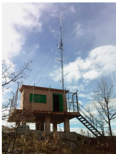
Ilustración 23: Caseta de vigilancia de Corcos. Fuente JCyL.
