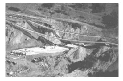
Figura 4. Desmoronamiento de 200 m. del terraplén del ferrocarril Villalba – Ávila, entre los puntos kilométricos 99 y 100. (arroyo de Majada Honda). Fuente: Antonio Sánchez.
