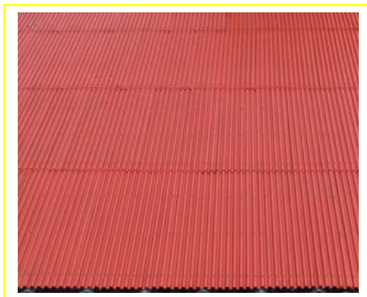
Ilustración 7. Cubierta de fibrocemento
